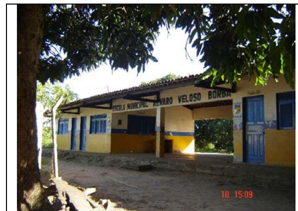
Foto 6.3.3-36 – Escola Municipal Álvaro Veloso Borba, no Engenho Lage. Município: Itambé - PE Coordenadas: 270.706 E 9.174.955 N
