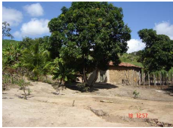
Foto 6.3.3-31 – Tipo de construção no Engenho Meirim. Município: Itambé - PE Coordenadas: 270.697 E 9.177.340 N
