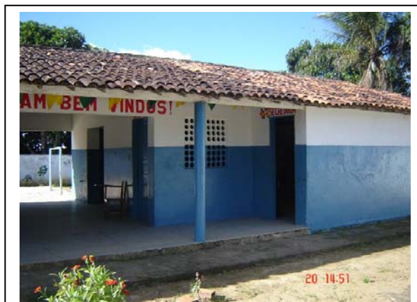
Foto 6.3.3-14 – Escola Municipal Dário Coquita Ferreira da Costa. Município: Araçoiaba - PE Coordenadas: 271.414 E 9.142.877 N
