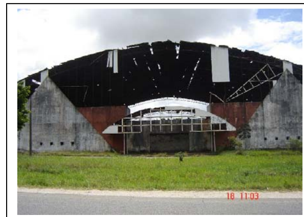
Foto 6.3.3-48 – Localidade de Marcação – Casa de Show Olimpo (desativada), na Rodovia PB-032.
