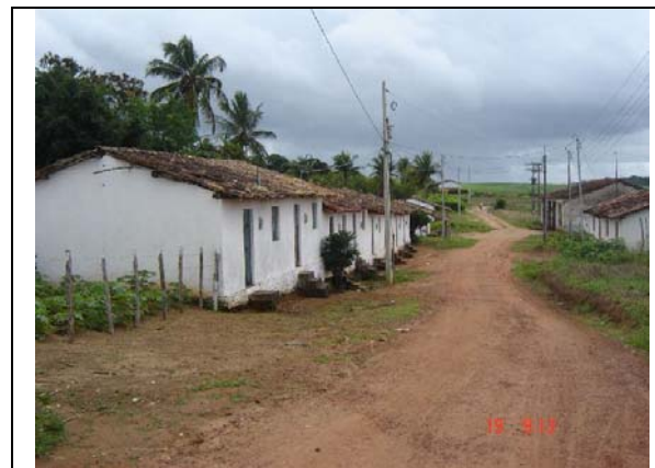
Foto 6.3.3-28 – Casas dos Engenhos Monte Carmelo e Pruá. Município: Itambé - PE Coordenadas: 268.309 E 9.171.965 N
