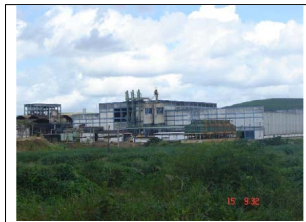
Foto 6.3.3-4 – Sede da Usina São José Município: Igarassu – PE. Coordenadas: 278.206 E 9.135.349 N
