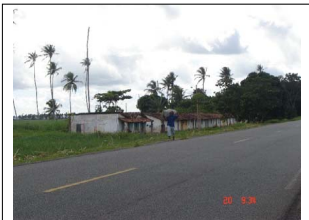
Foto 6.3.3-21 – Casas do Sítio Siqueira, às margens da Rodovia PE-062, vista sentido Centro de Condado. Município: Condado - PE Coordenadas: 264.927 E 9.159.391 N
