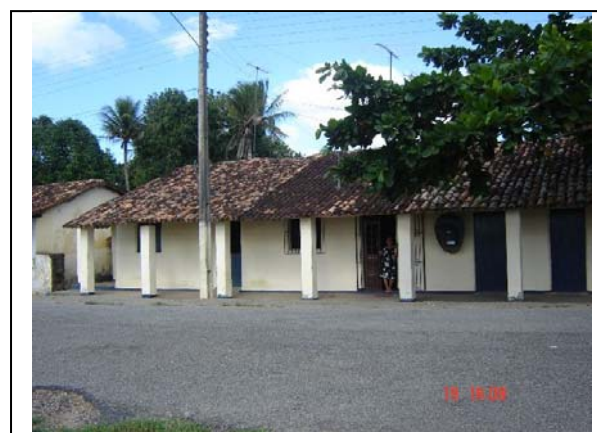
Foto 6.3.3-18 – Casas antigas de engenho, bairro Quirizeira, Avenida 7 de Setembro, próximas ao traçado da LT no lado esquerdo. Município: Condado - PE Coordenadas: 265.970 E 9.159.632 N
