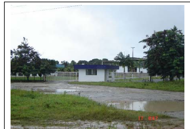
Foto 6.3-52 – Instalações da Água Mineral Platina, na Rodovia BR-230, ao lado do DNIT. Município: Santa Rita - PB Coordenadas: 278.247 E 9.209.007 N
