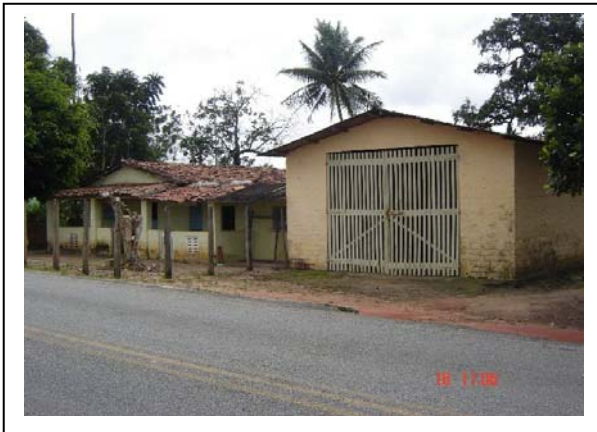
Foto 6.3.3-37 – Localidade de Marcação, ocupação às margens da Rodovia PB-032. Município: Pedras de Fogo - PB Coordenadas: 271.309 E 9.181.656 N
