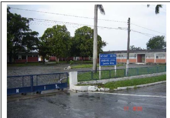
Foto 6.3-51 – Instalações da Regional do DNIT, na Rodovia BR-230. Município: Santa Rita - PB Coordenadas: 278.247 E 9.209.007 N
