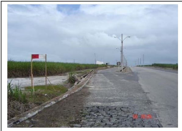
Foto 6.3.3-39 – Cruzamento com a Rodovia PB-032. Ao fundo, instalações do Posto Fiscal Zélice Pereira de Moraes. Município: Pedras de Fogo - PB Coordenadas: 272.417 E 9.182.010 N
