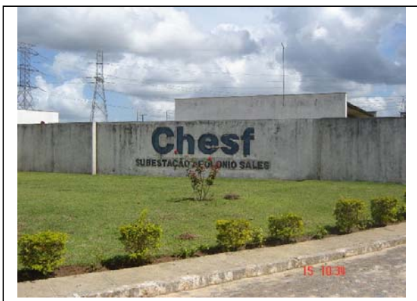
Foto 6.3.3-1 – Subestação Pau Ferro (Apolônio Sales). Município: Igarassu - PE Coordenadas: 277.370 E 9.130.653 N
