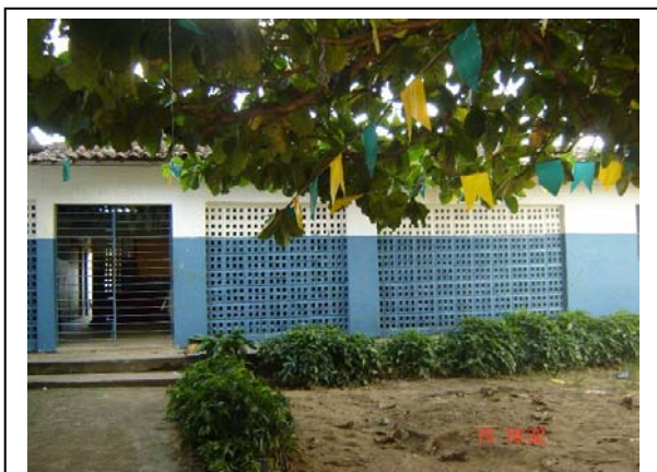
Foto 6.3.3-13 – Escola Municipal Maria Carneiro de Albuquerque, em Vila Canaã. Município: Araçoiaba - PE Coordenadas: 274.128 E 9.141.383 N
