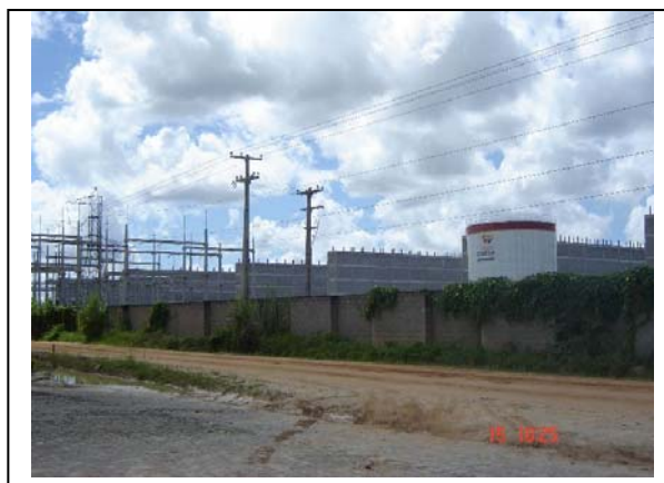
Foto 6.3.3-2 – UTE Pernambuco III da Centrais Elétricas de Pernambuco – EPESA. Município: Igarassu - PE Coordenadas: 277.540 E 9.130.580 N
