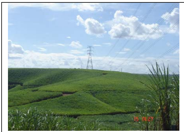
Foto 6.3.3-7 – Paralelismo com a LT 230kV Pau Ferro – Campina Grande II em área do extinto Engenho Cumbe de Baixo.
