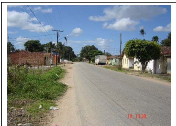
Foto 6.3.3-19 – Bairro Quirizeira, Avenida 7 de Setembro, que será cruzada pelo traçado da LT. Município: Condado - PE Coordenadas: 266.693 E 9.160.350 N
