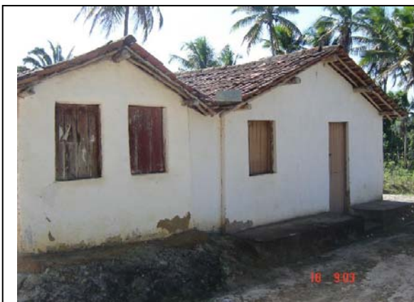
Foto 6.3.3-45 – Localidade de Imbiribeira – casas vazias mais próximas ao traçado da LT.
