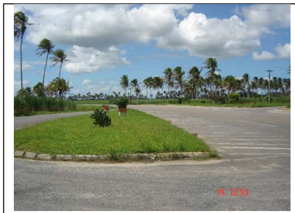
Foto 6.3.3-20 – Trevo de entroncamento das Rodovias PE-062 (Condado – Aliança) e PE-052 (Condado – Itaquitinga). Município: Condado - PE Coordenadas: 265.635 E 9.159.665 N
