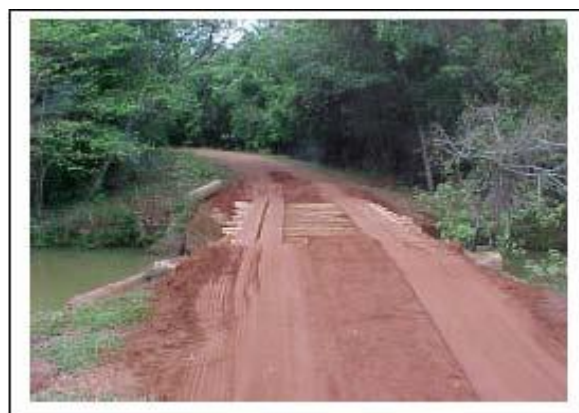
Foto 11-22 – Pontes provisórias para evitar danos aos cursos d'água.
