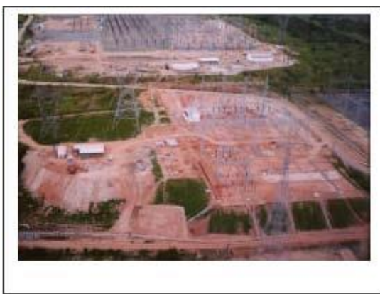
Foto 11-15 – Taludes com e sem dispositivos de drenagem.
