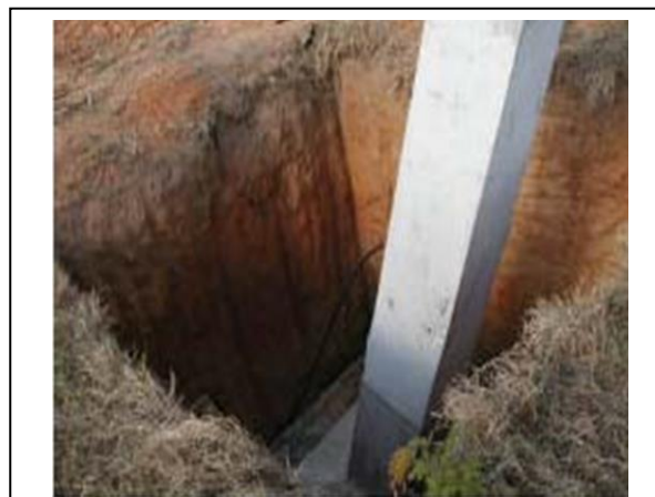
Foto 11-48 – Fundação pré-moldada.
