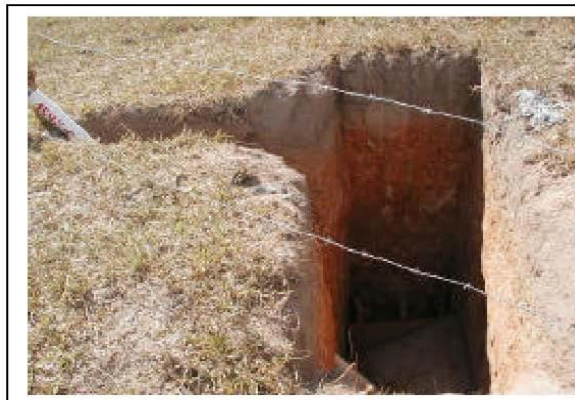
Foto 11-42 – Detalhe da escavação do estai.
