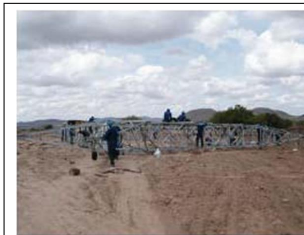
Foto 11-56 – Processo de montagem de torres.
