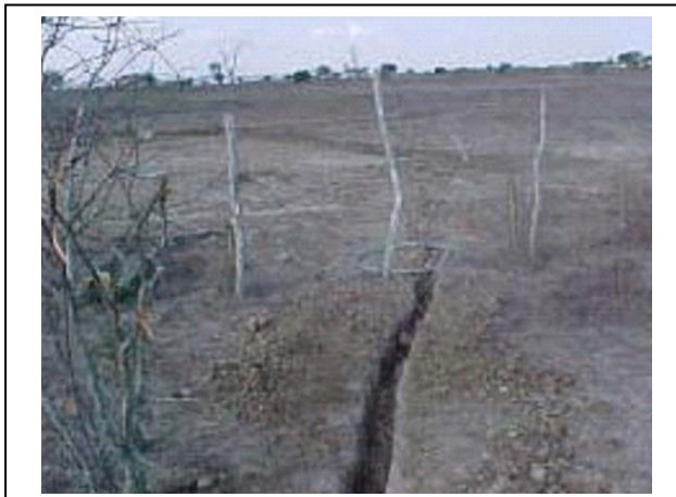
Foto 11-67 – Vala para instalação do aterramento.
