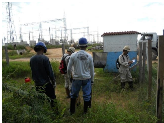
Foto 8: entrada de acesso a SE 230kv com a SE Oriximiná (500kv) ao fundo
