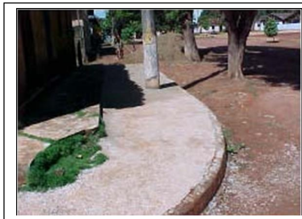
Foto 11-4 – Disposição apropriada de restos de concreto.
