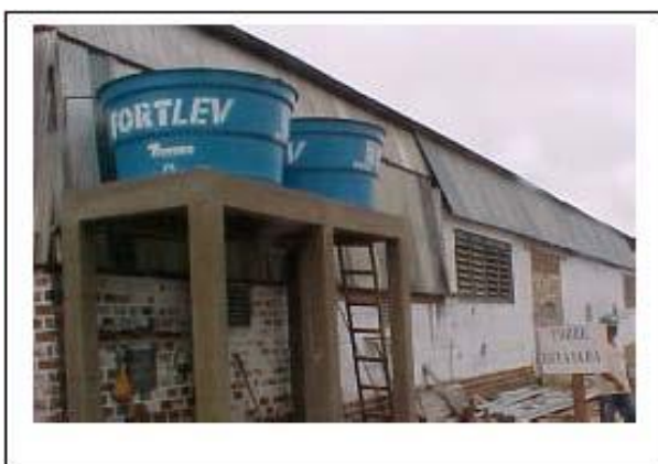
Foto 11-17 – Armazenamento apropriado de água para consumo no canteiro.
