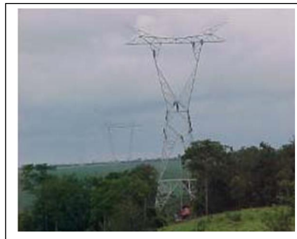
Foto 11-58 – Processo de montagem de torres.
