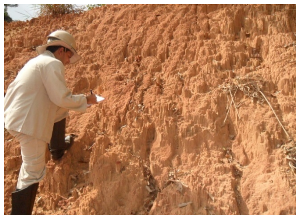
Foto 19 - Verificação de barrancos nas margens da estrada
