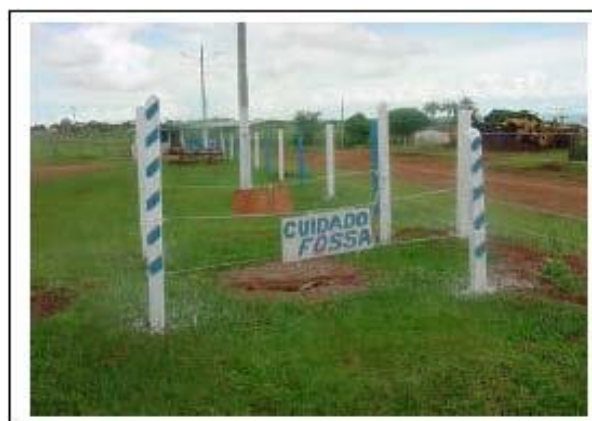
Foto 11-18 – Tratamento e disposição apropriados dos esgotos gerados no canteiro.
