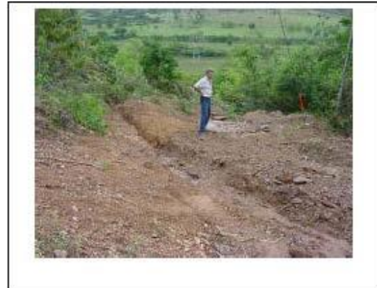
Foto 11-12 – Dispositivo provisório de drenagem para evitar erosão na área da torre.
