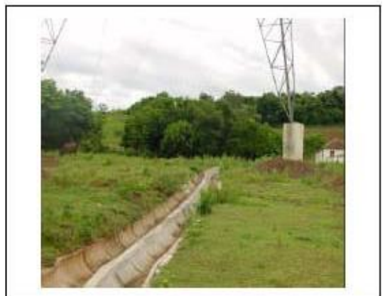
Foto 11-14 – Dispositivo permanente de drenagem para proteger o pé da torre sobrelevada.
