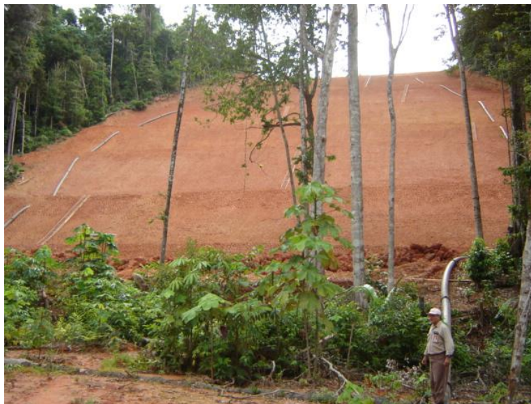
Foto 17-1 – Retaludamento da área e sistema de drenagem
