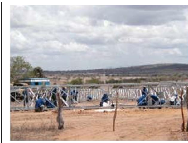
Foto 11-55 – Processo de montagem de torres.
