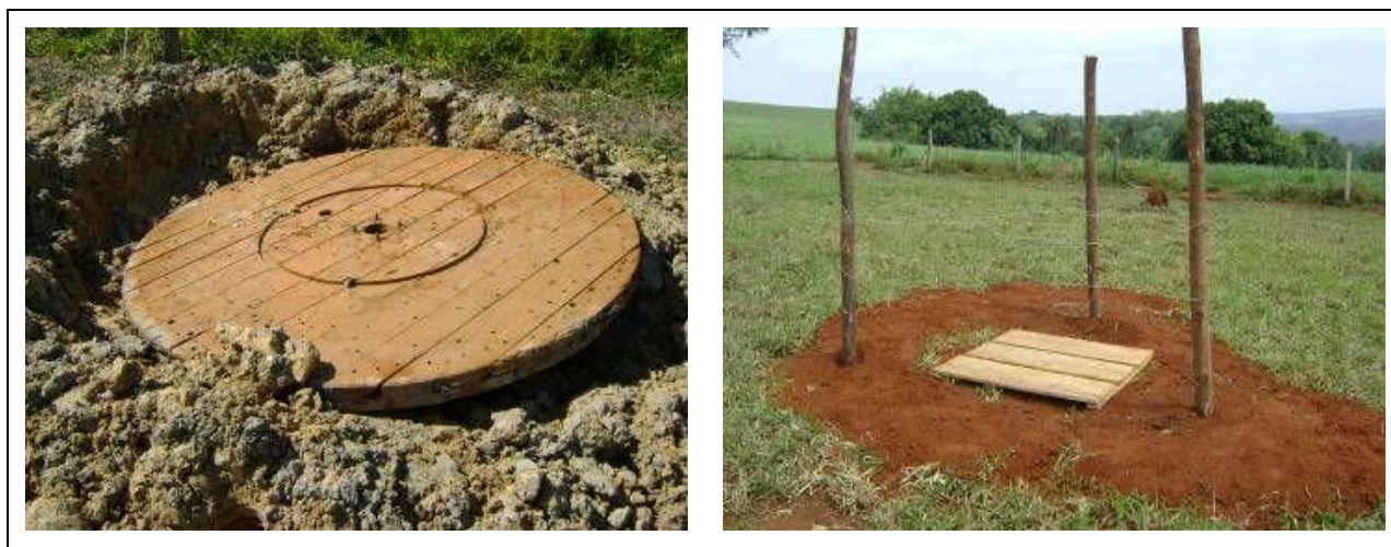
Figura 9-12 – Isolamento da cava utilizando-se lateral de bobina como tampa (à esquerda) e cerca de arame e tampa de madeira (à direita).
