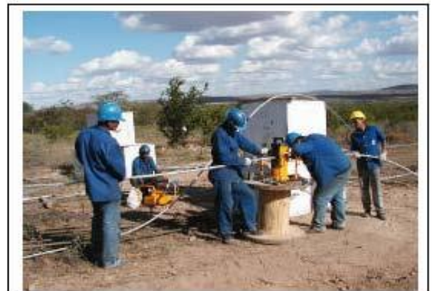
Foto 11-64 – Lançamento de cabo.
