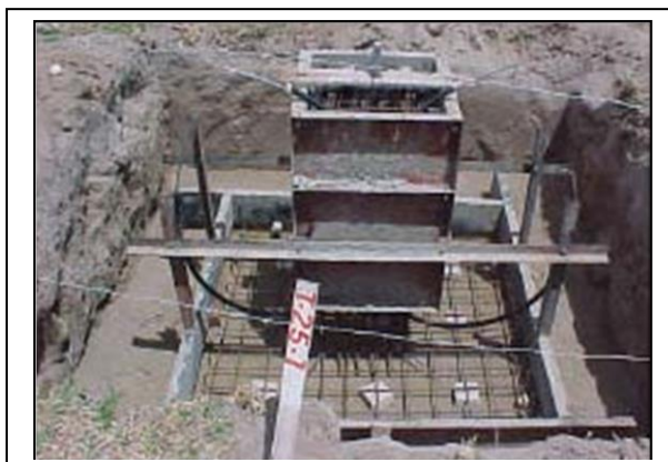
Foto 11-43 – Fundação in loco .
