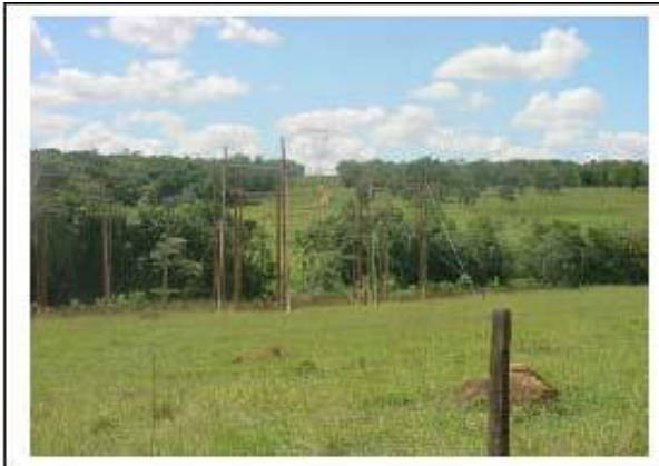
Foto 11-59 – Instalação de cavalete para o cruzamento de uma LT.
