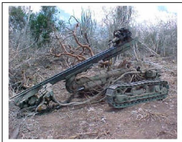
Foto 11-38 – Utilização de compressor para fazer a vala do estai.
