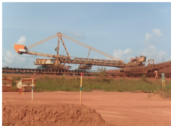
Foto 9 – Instalação de lavagem, ciclonação e filtração do minério
