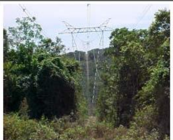
Foto 11-34 – Abertura da faixa de 7 a 10m de largura e corte seletivo de vegetação.
