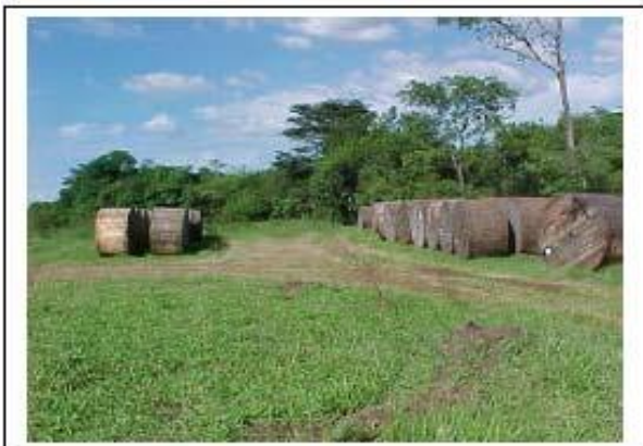
Foto 11-63 – Organização dos carretéis na praça de lançamento.
