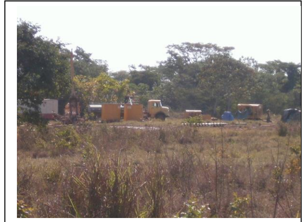
Foto 11-66 – Praça de Lançamento de cabos condutores.
