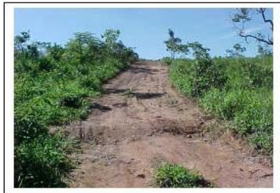
Foto 11-10 – Acesso com dissipadores de energia.
