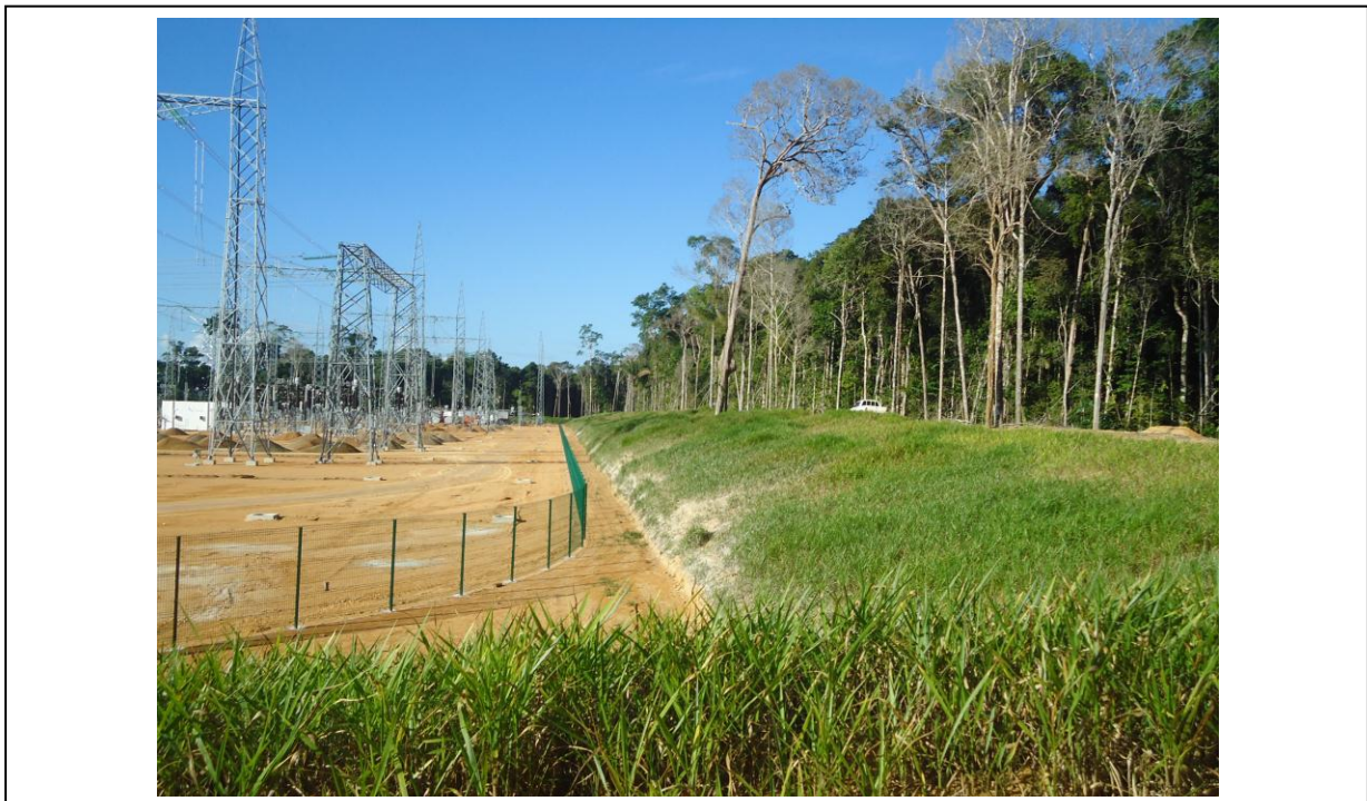
Foto 17-15: Outra vista de talude de corte protegido por vegetação herbácea
