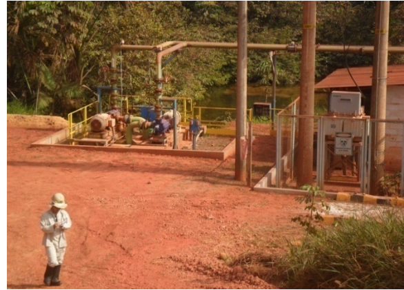
Foto 11 - Usina de captação de água
