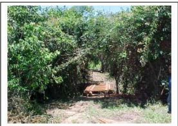
Foto 11-27 – Pontes provisórias para evitar danos aos cursos de água.
