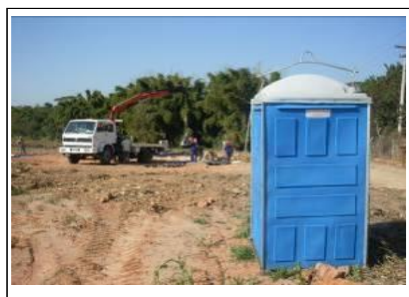
Foto 11-20 – Banheiro químico na praça de serviço.
