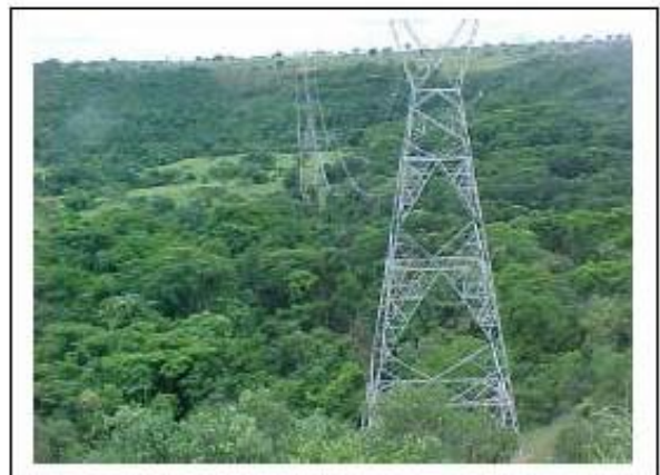
Foto 11-70 – Faixa de serviço de 7 a 10m de largura numa área de remanescente florestal.
