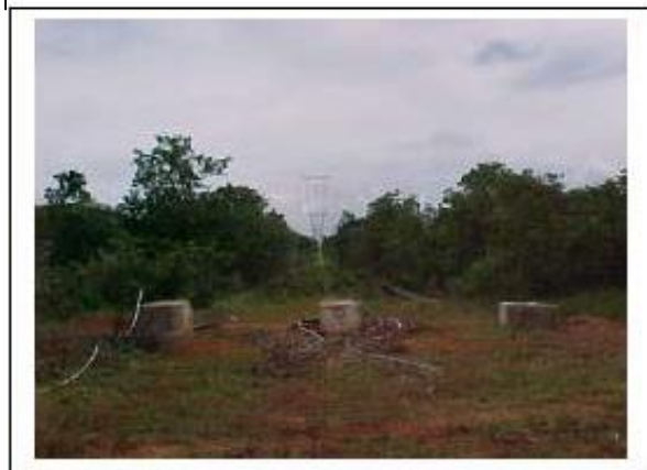
Foto 11-69 – Praça de lançamento locada em área sem vegetação arbustiva.
