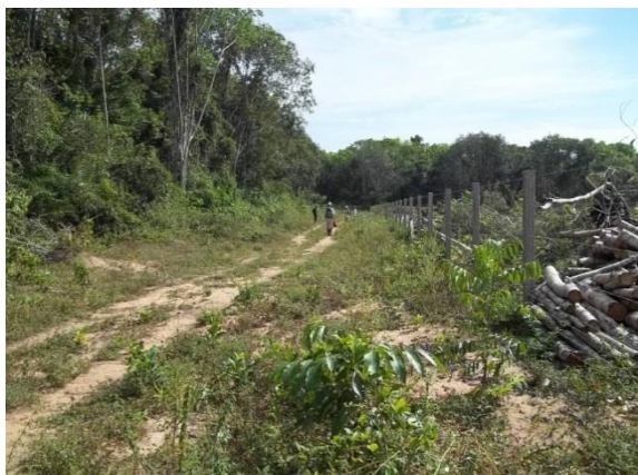
Foto 9: vista da entrada de acesso a SE 230kv.
