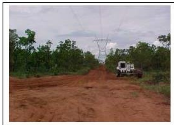
Foto 11-72 – Acesso utilizando a faixa de serviço.
