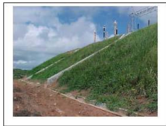
Foto 11-16 – Taludes com dispositivos de drenagem.
