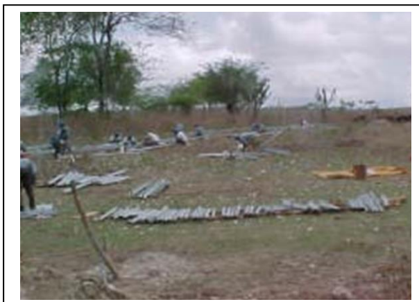
Foto 11-51 – Processo de montagem de torres.
