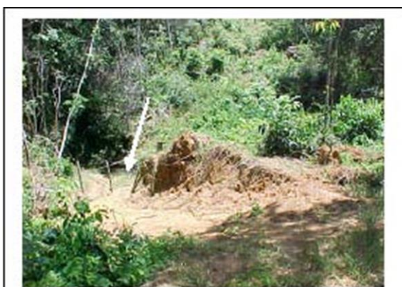
Foto 11-5 – Não conformidade: corte de margem de córrego.
