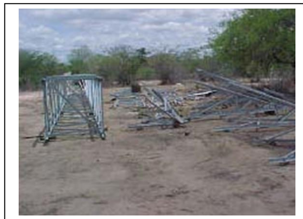
Foto 11-52 – Processo de montagem de torres.
