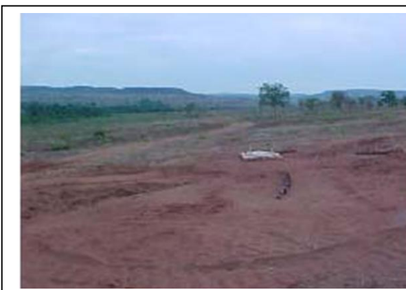
Foto 11-49 – Recomposição da área de fundação.
