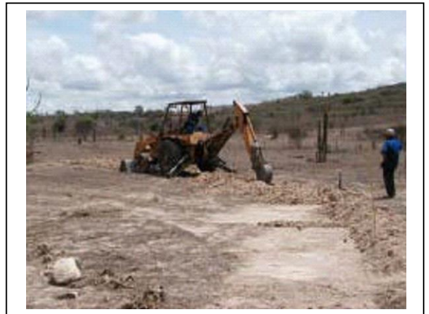
Foto 11-68 – Uso de trator para instalação do aterramento
