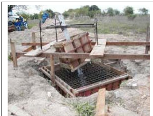
Foto 11-47 – Fundação in loco .
