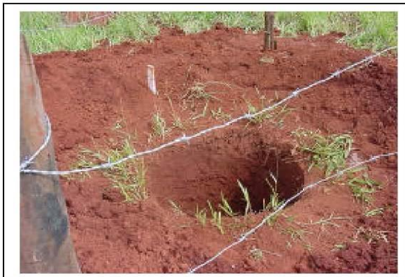
Foto 11-41 – Detalhe da escavação com broca do mastro central.
