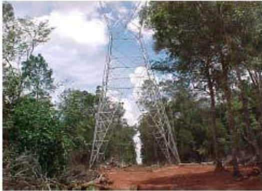
Foto 11-29 – Abertura da faixa de 7 a 10m de largura e corte seletivo de vegetação.
