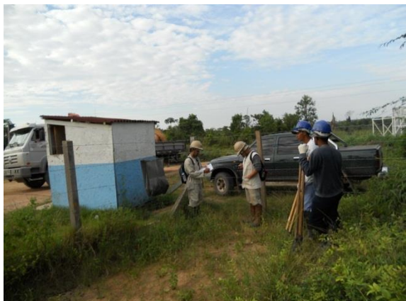
Foto 7: entrada do acesso a SE 230kv
