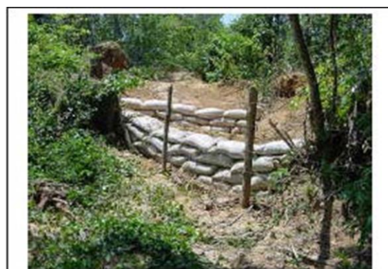
Foto 11-6 – Recomposição de área degradada com muro de contenção.
