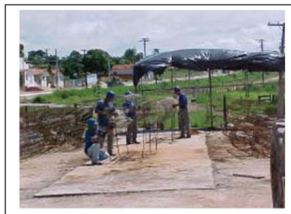
Foto 11-46 – Fundação pré-moldada.
