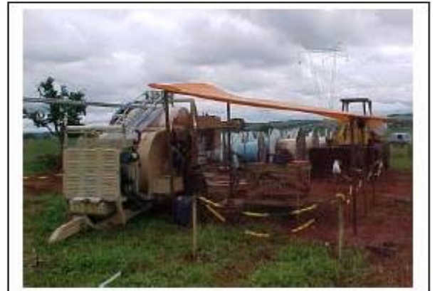
Foto 11-62 – Praça de lançamento de cabos locada corretamente.
