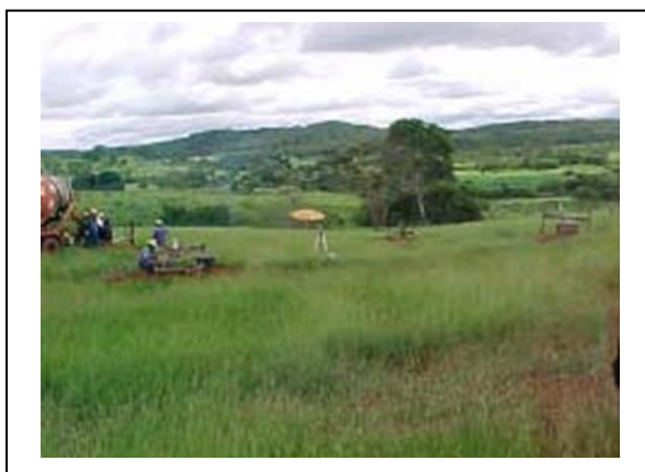
Foto 11-45 – Fundação in loco .
