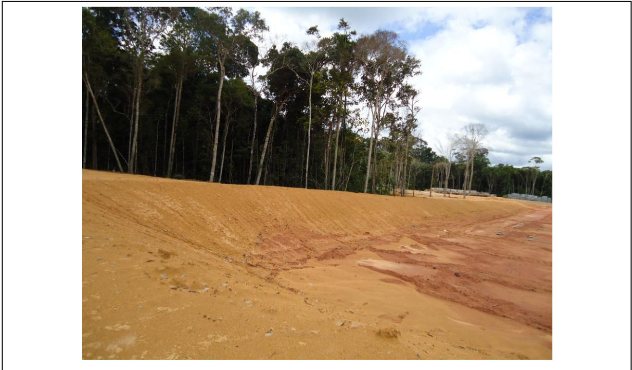
Foto 17-11: Aspecto de talude de corte antes de receber recobrimento vegetal
