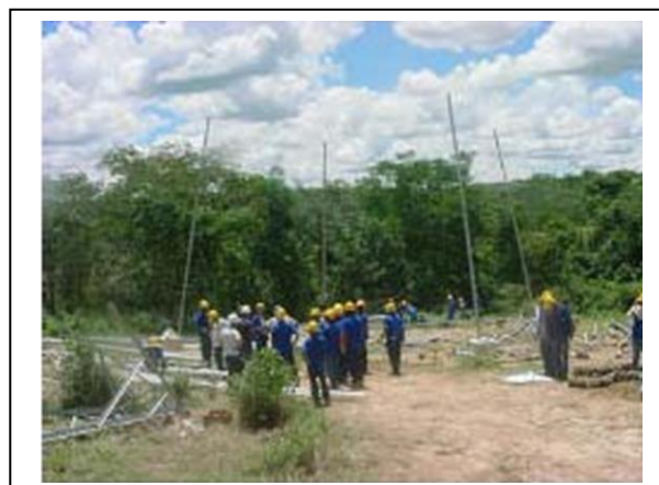
Foto 11-54 – Processo de montagem de torres.
