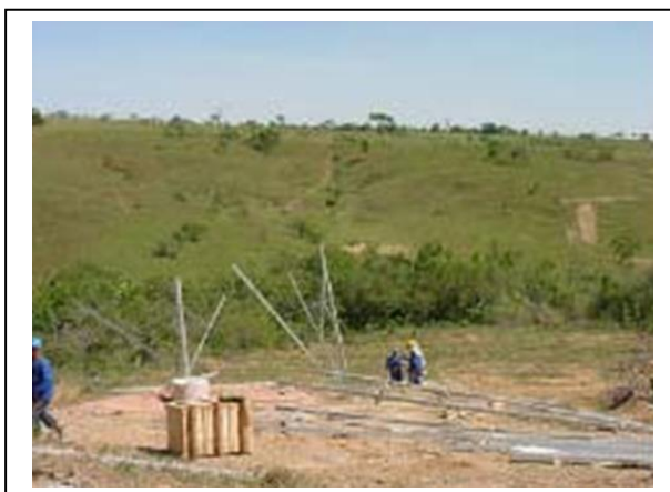
Foto 11-53 – Processo de montagem de torres.
