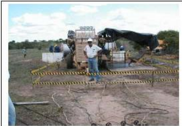
Foto 11-61 – Praça de lançamento de cabos locada corretamente.
