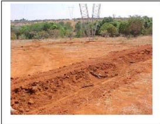
Foto 11-11 – Dispositivo provisório de drenagem para evitar erosão na área da torre.
