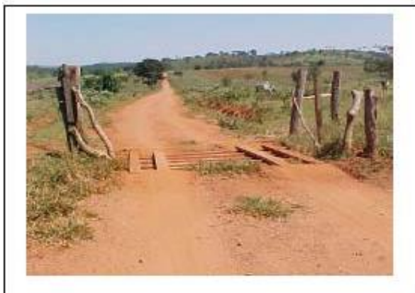
Foto 11-23 – Restauração de mata-burro danificado na obra.
