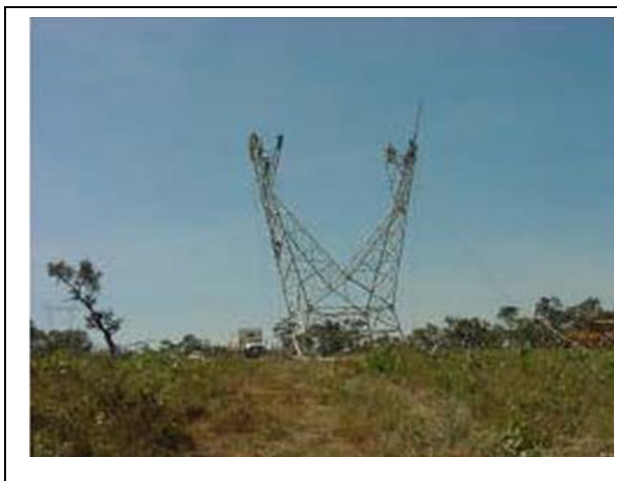
Foto 11-57 – Processo de montagem de torres.
