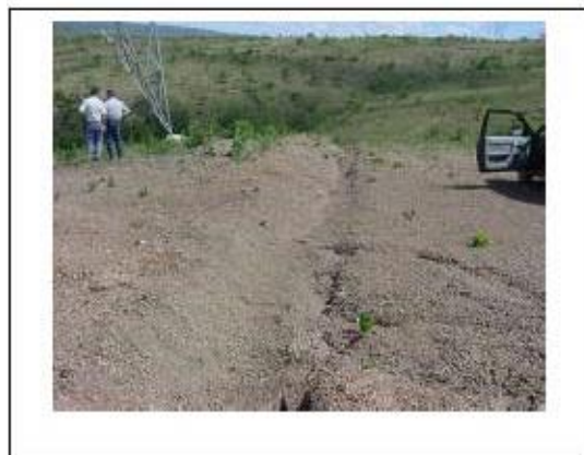
Foto 11-13 – Dispositivo provisório de drenagem para proteger o pé da torre.
