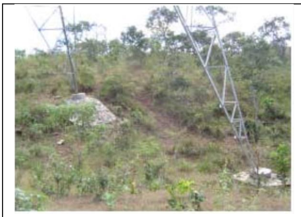
Foto 11-75 – Proteção definitiva na base. A cobertura vegetal conteve os processos erosivos.
