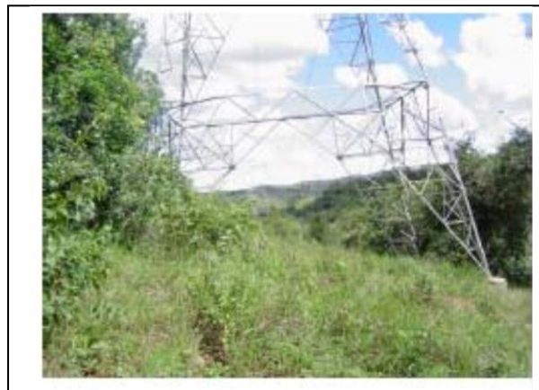
Foto 11-74 – Revegetação com capim nativo, logo após o nivelamento final do terreno.
