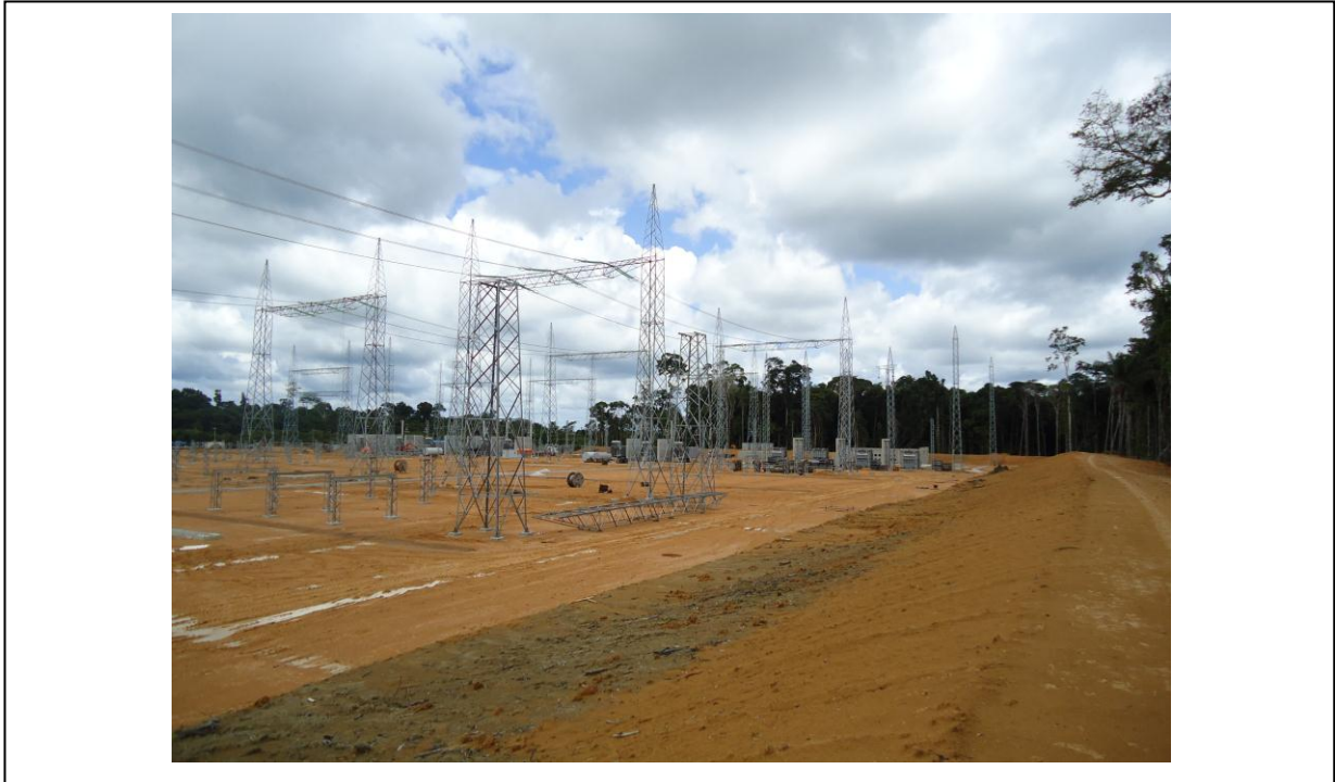
Foto 17-13: Vista longitudinal de talude recém-revegetado exclusivamente com gramínea
