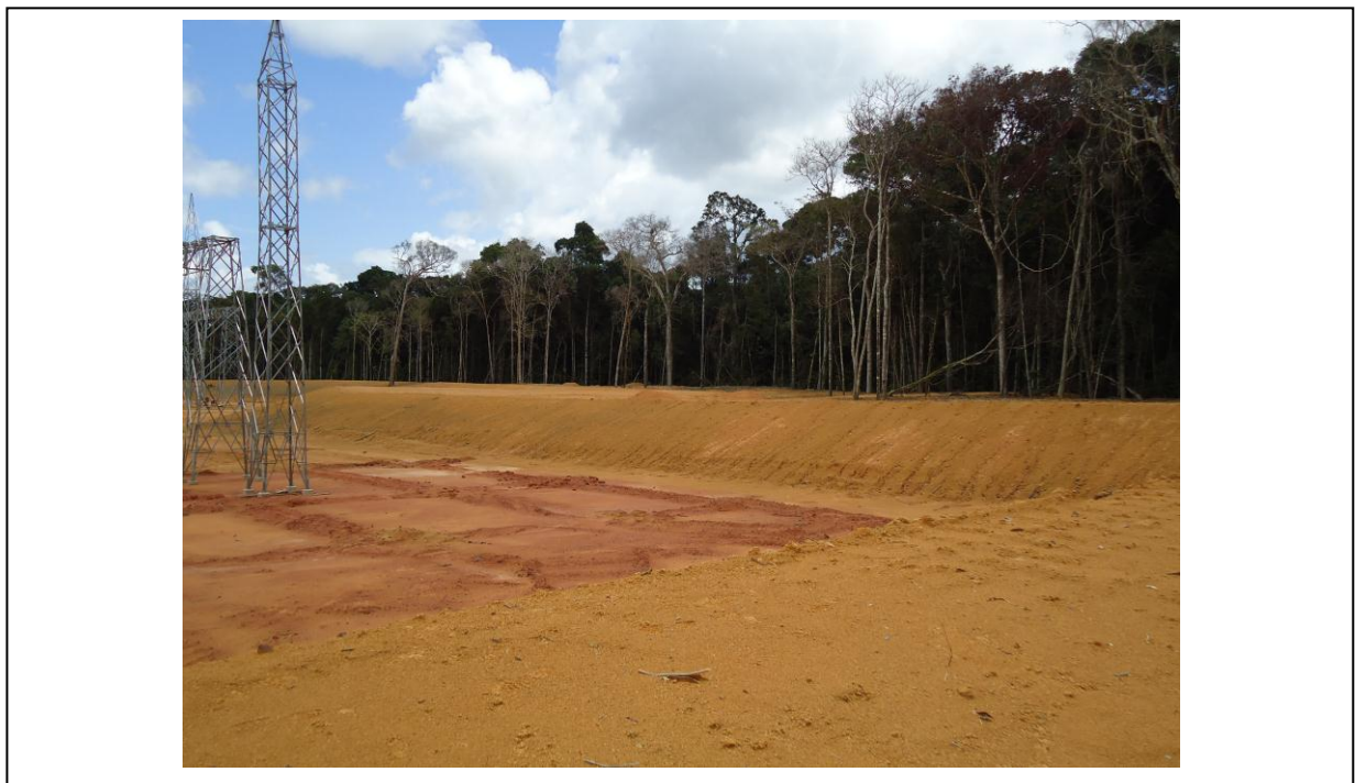
Foto 17-12: Vista lateral da mesma área, tendo ao fundo vegetação florestal distanciada da área energizada
