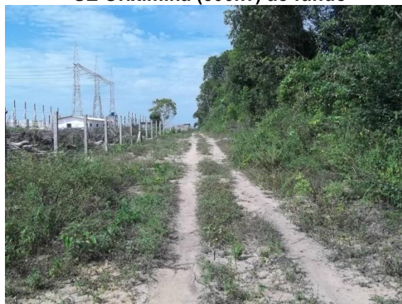
Foto 10: vista do final do acesso a SE 230kv para a entrada.
