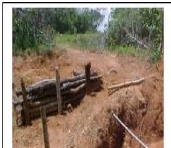
Foto 11-8 – Medida provisória para o controle de erosão.
