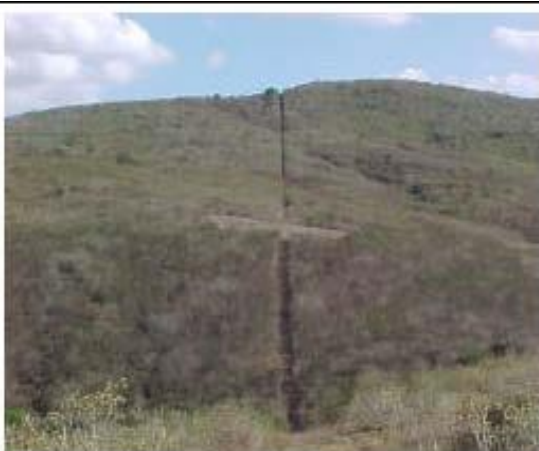
Foto 11-33 – Abertura da faixa de 7 a 10m de largura.
