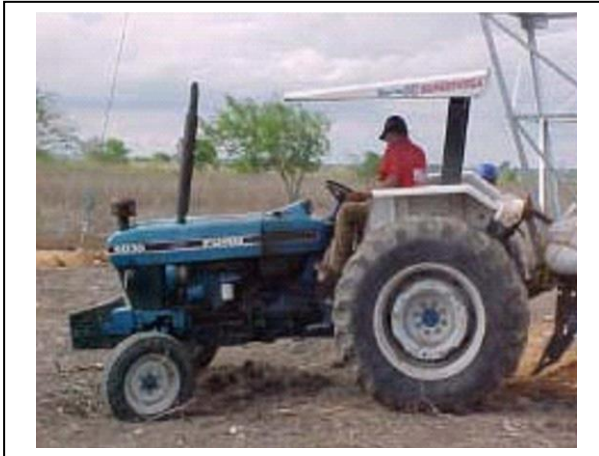
Foto 11-65 – Uso de trator para instalação do aterramento.
