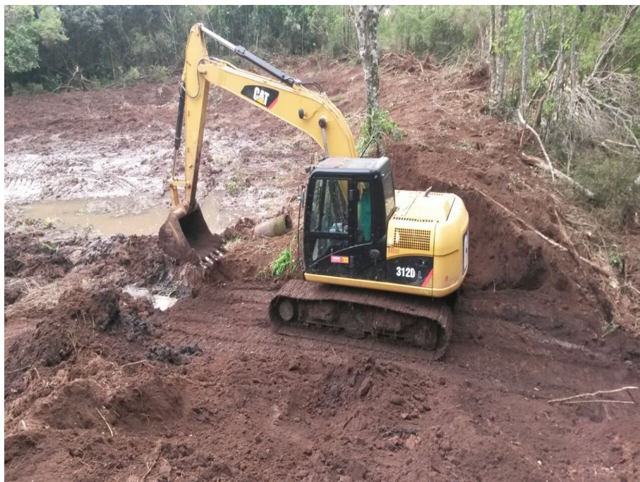
Ilustração 28: Execução da recuperação dos açudes na TI Toldo Pinhal.
