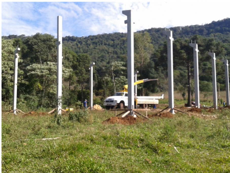
Ilustração 35: Execução da superestrutura com lançamentos dos pilares pré-moldados.
