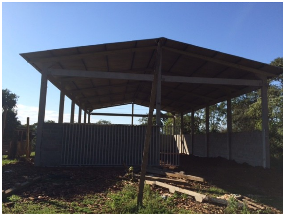
Ilustração 37: Galpão concluído, restando apenas a limpeza de restos de obra.
