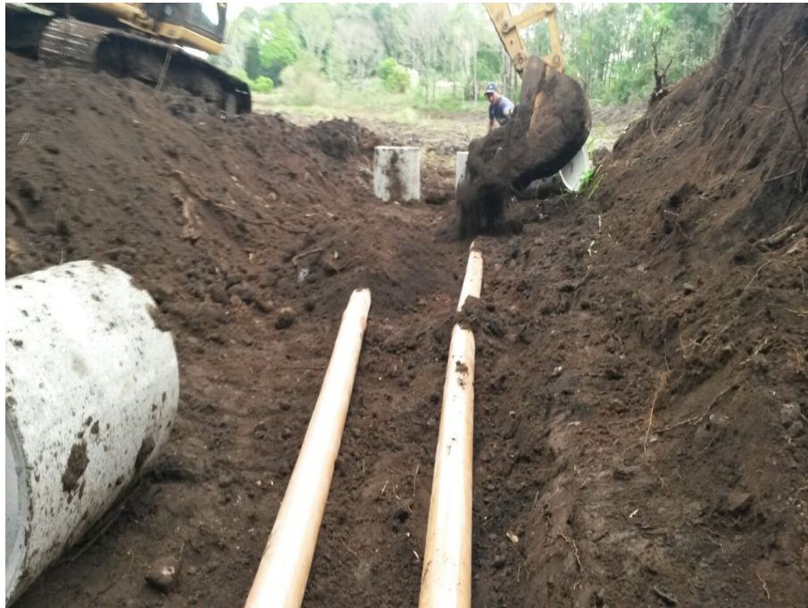
Ilustração 29: Execução da recuperação dos açudes na TI Toldo Pinhal.
