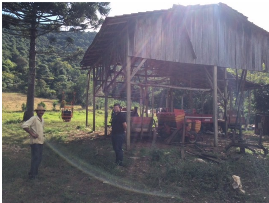
Ilustração 33: Vistoria do local do futuro galpão.
