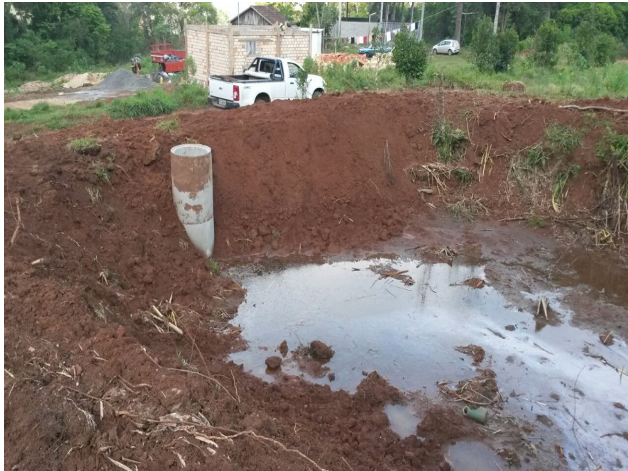
Ilustração 27: Execução da recuperação dos açudes na TI Toldo Pinhal.
