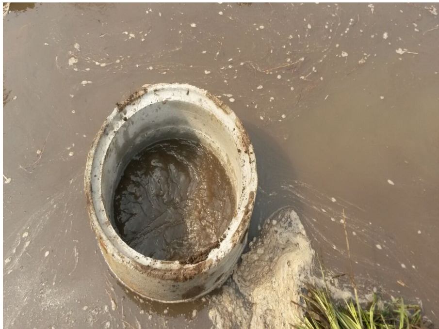
Ilustração 30: Execução da recuperação dos açudes na TI Toldo Pinhal.
