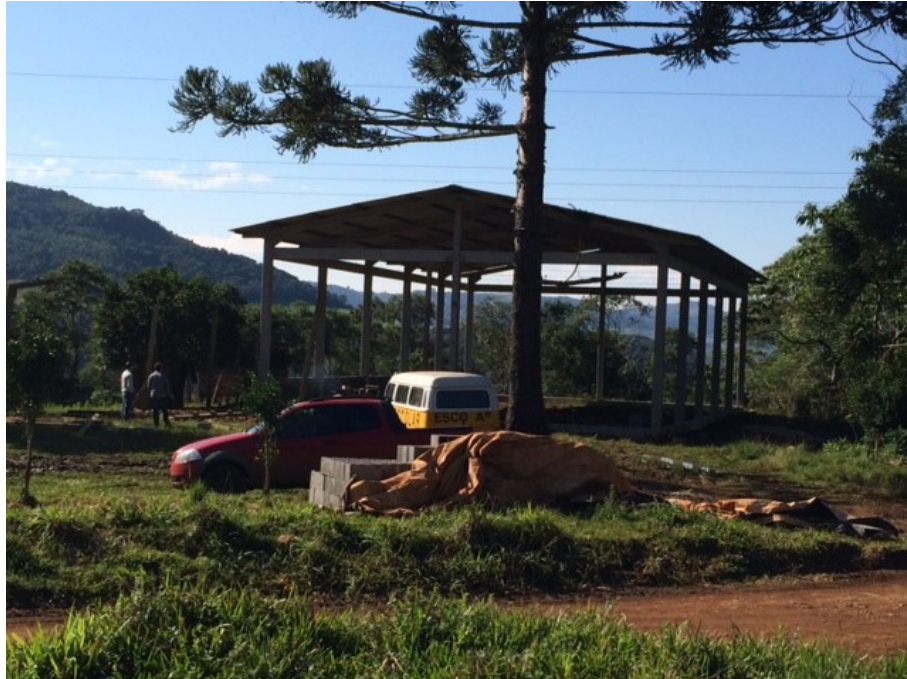
Ilustração 36: Superestrutura e telhamento concluídos, sendo iniciado a execução da alvenaria.
