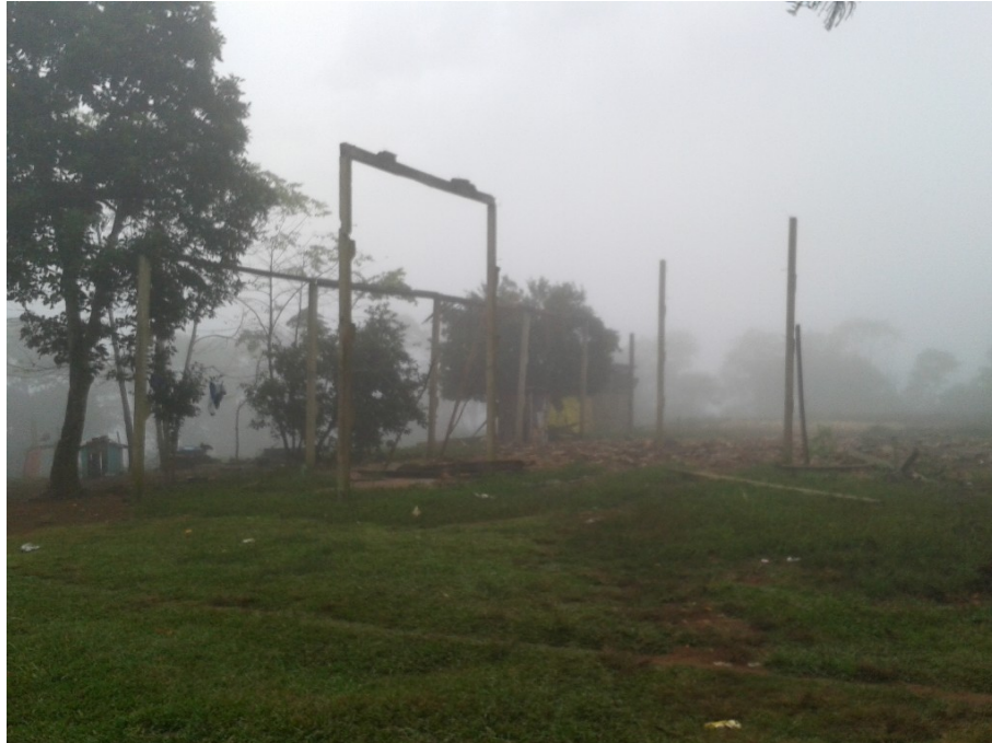
Ilustração 34: Finalização da demolição do antigo galpão.
