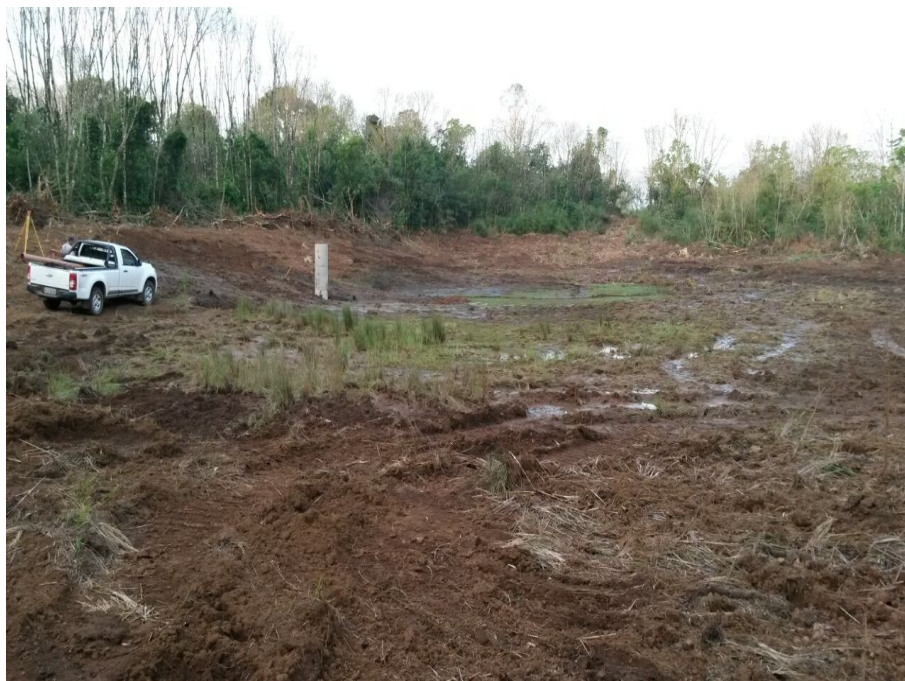
Ilustração 32: Execução da recuperação dos açudes na TI Toldo Pinhal.
