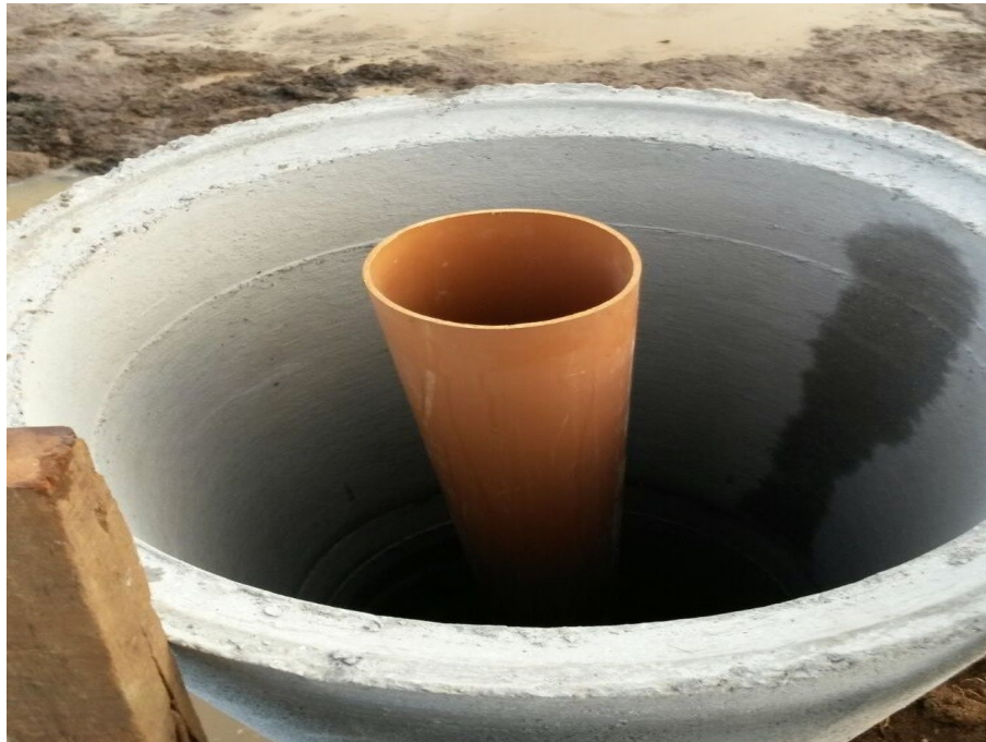
Ilustração 31: Execução da recuperação dos açudes na TI Toldo Pinhal.
