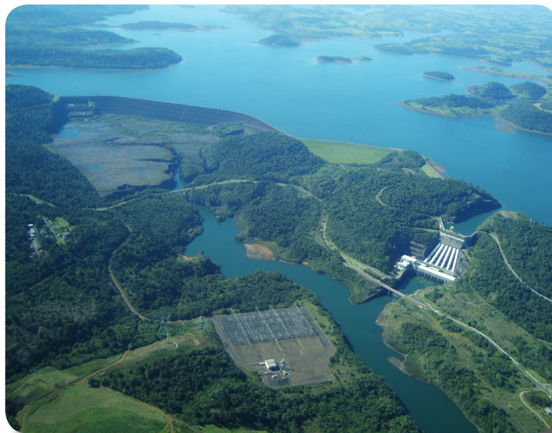
Usina Hidrelétrica em Salto Santiago, Rio Iguaçu/PR
