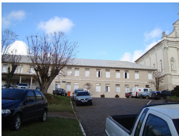
Figura 6.4.13: Hospital Municipal de São Domingos do Sul - RS.
