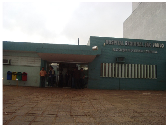
Figura 6.4.22: Hospital São Paulo em Xanxerê (SC), um dos municípios com canteiro de obras.
