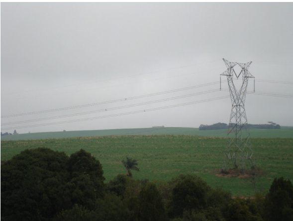
Figura 6.4.57: No município de Clevelândia é possível avistar LT existente com fragmentos florestais e pastagens.
