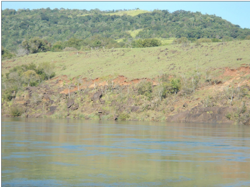
Figura 6.63: Erosão na encosta do rio Iguaçu, próximo da Usina Hidrelétrica Salto Santiago.
