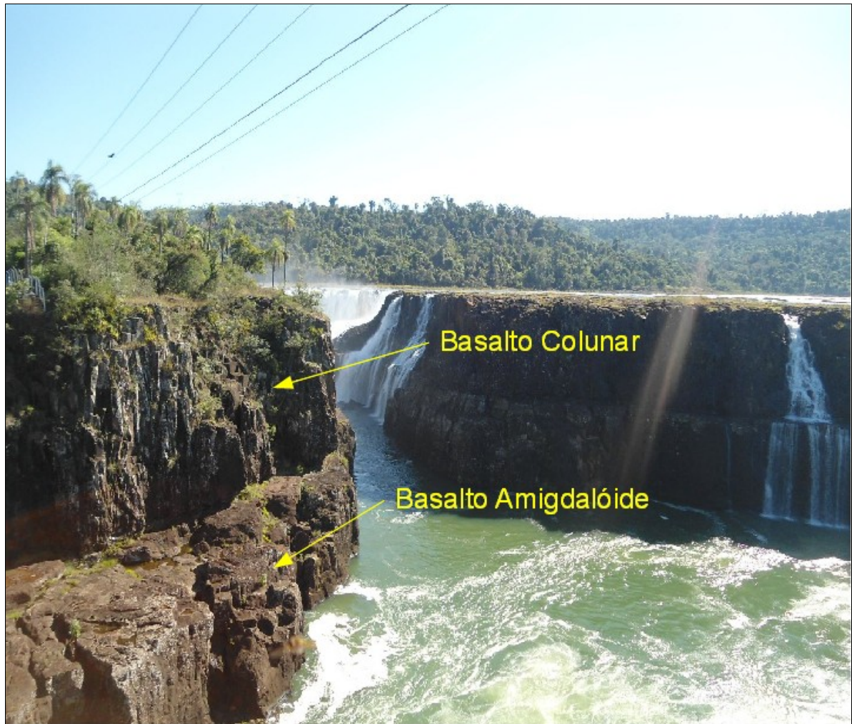
Figura 6.47- Basaltos colunar e amigdalóide da Formação Serra Geral. Usina Salto Santiago, município de Saudades do Iguçu, PR.
