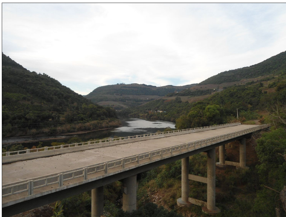
Figura 6.56: Vale bem encaixado do rio das Antas.
