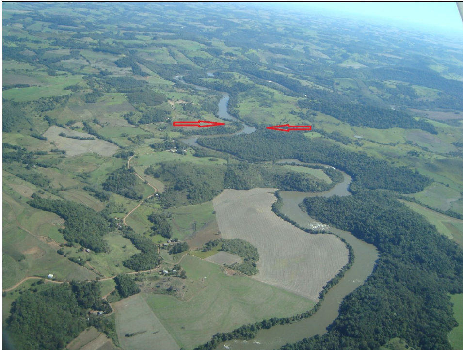
Figura 6.21: Vista aérea do rio Chopim. Em destaque, local próximo do cruzamento da nova LT 525kV. Fonte: PROSUL - 02/05/2012.
