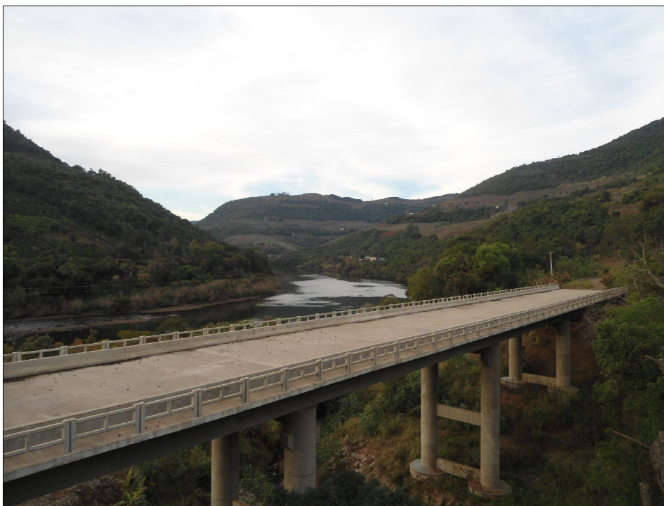
Figura 6.41: Rio das Antas próximo ao ponto de cruzamento da LT. Data: 15/06/2012.
