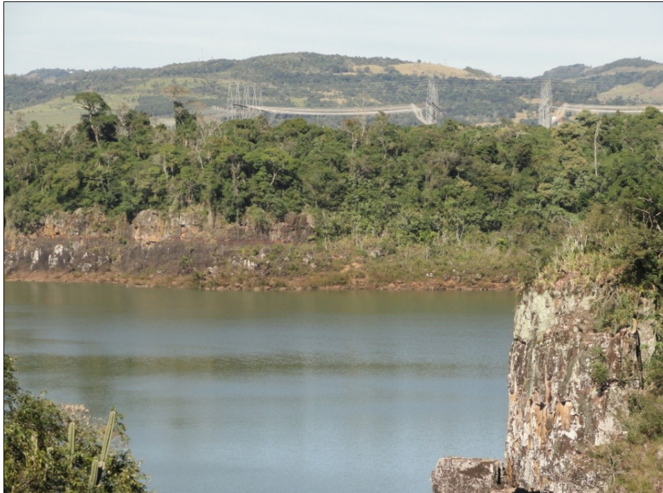
Figura 6.21: Aspecto da vegetação ao redor da subestação de Salto Santiago, local onde se iniciará a LT, município de Saudades do Iguaçu, PR.
