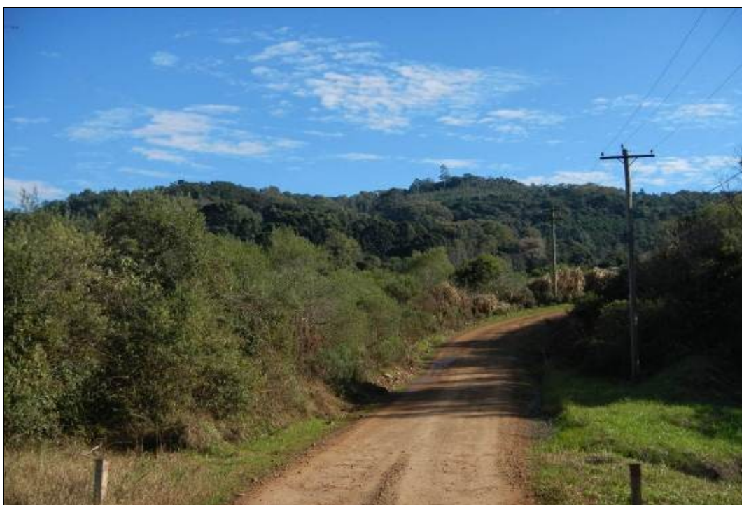
Figura 6.65: Detalhe da posição da estrada em relação ao curso d'água com destaque para a diferença no grau de conservação da APP nos dois lados da estrada, Barão, RS.
