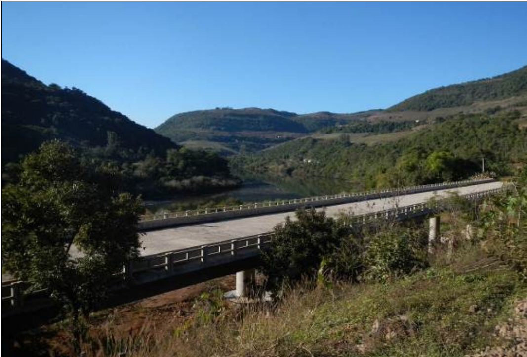
Figura 6.75: Detalhe da ponte sobre o curso d'água.
