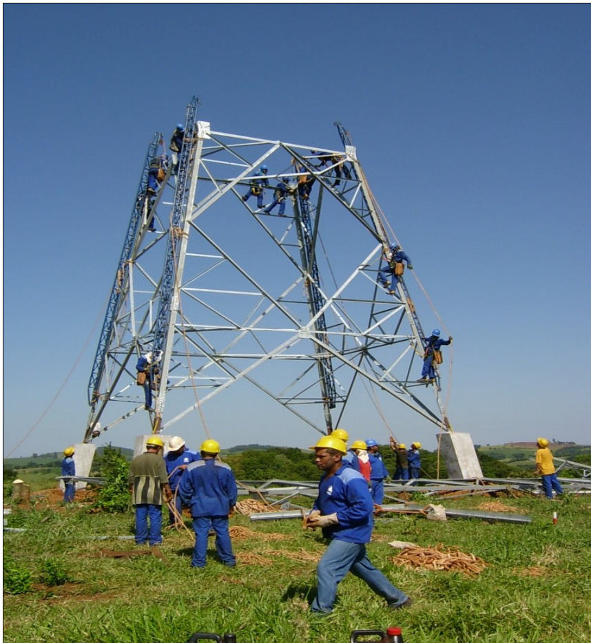
Figura 4.23- Montagem de torre autoportante.
