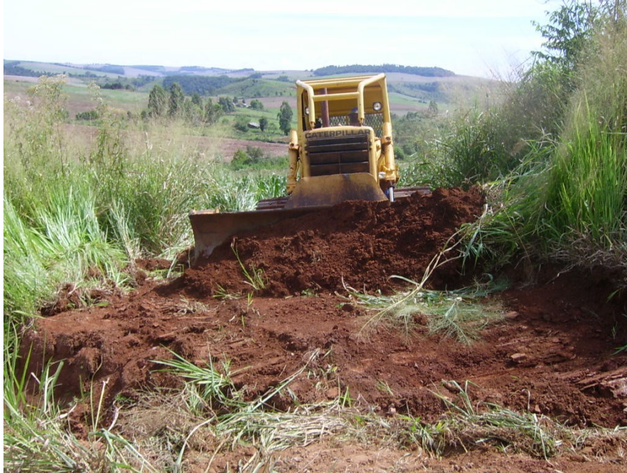
Figura 4.16- Abertura dos acessos com trator de esteira.
