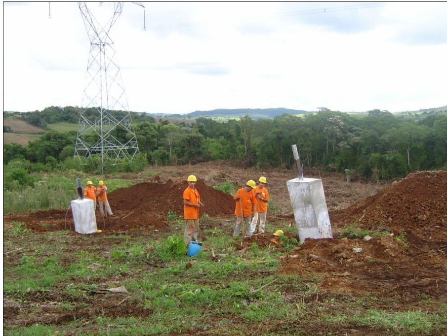
Figura 4.22- Fundação de torre finalizada.
