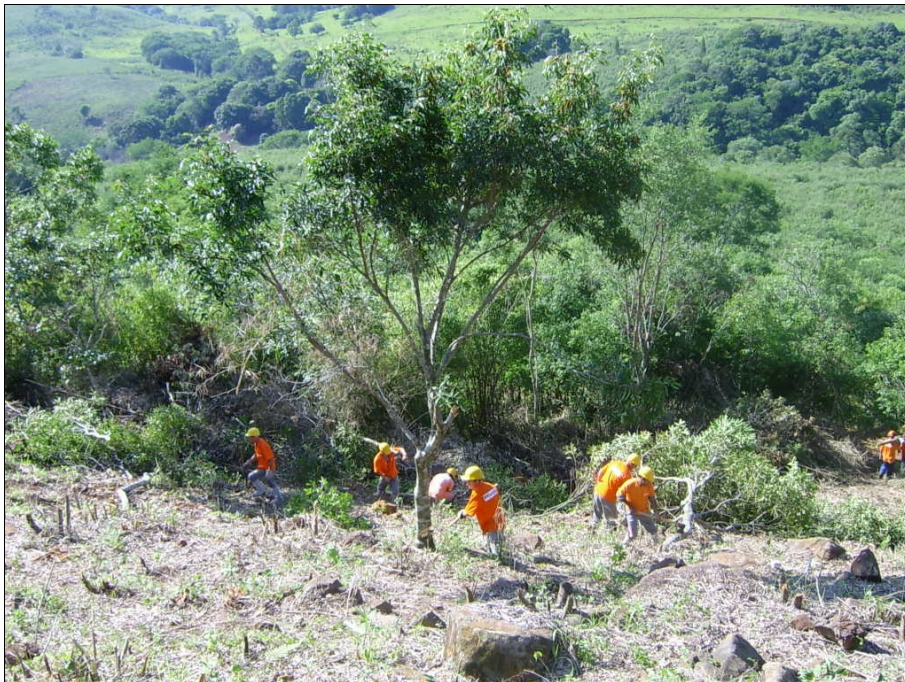
Figura 4.19- Supressão de vegetação para abertura de praça de torre
