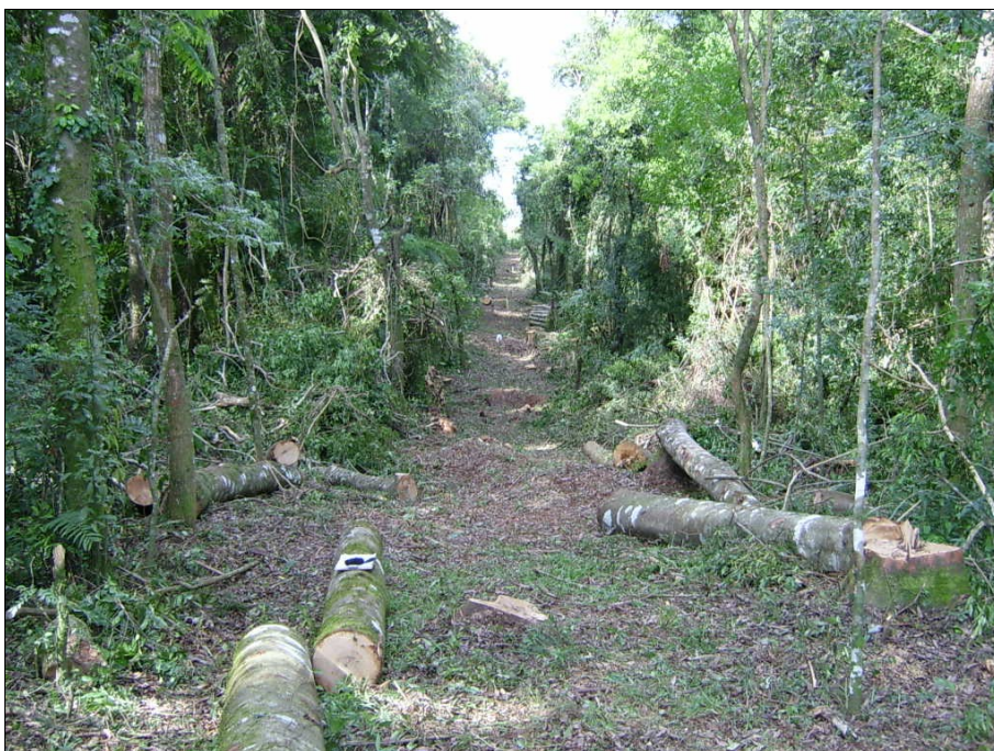
Figura 4.20- Supressão de vegetação para abertura de faixa de serviço (até 3 m) dentro da faixa de servidão (70 m).
