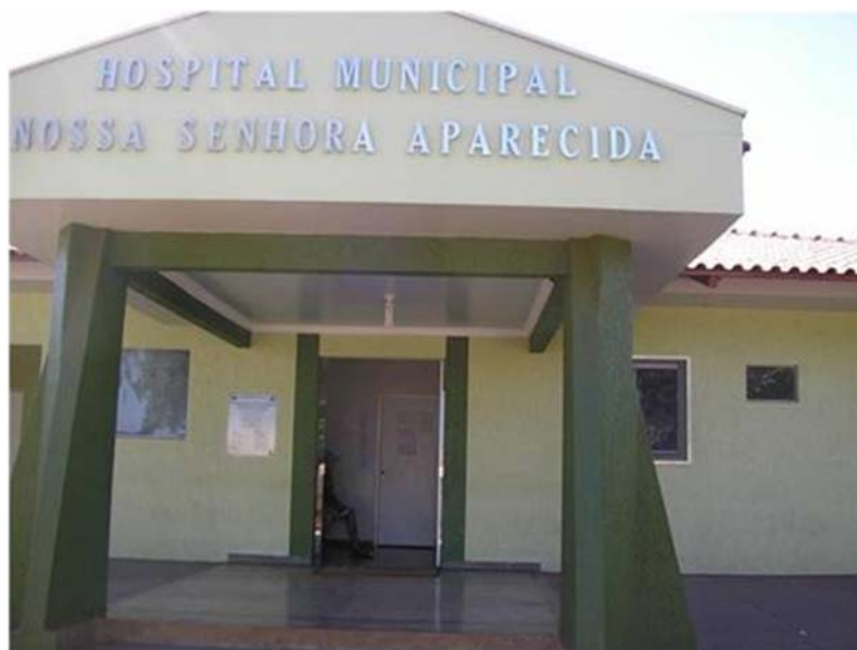
Foto 4. 19 - Hospital Municipal de Alto Taquari
