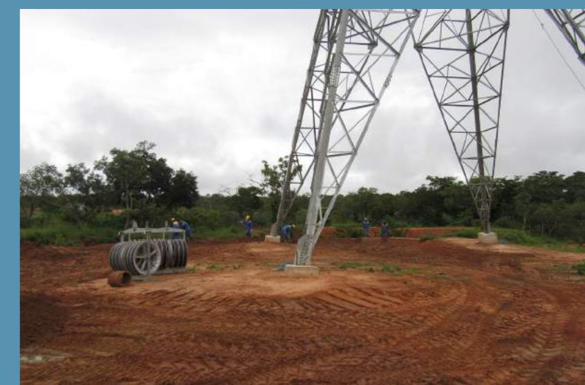
Praça de trabalho para implantação da torre.
