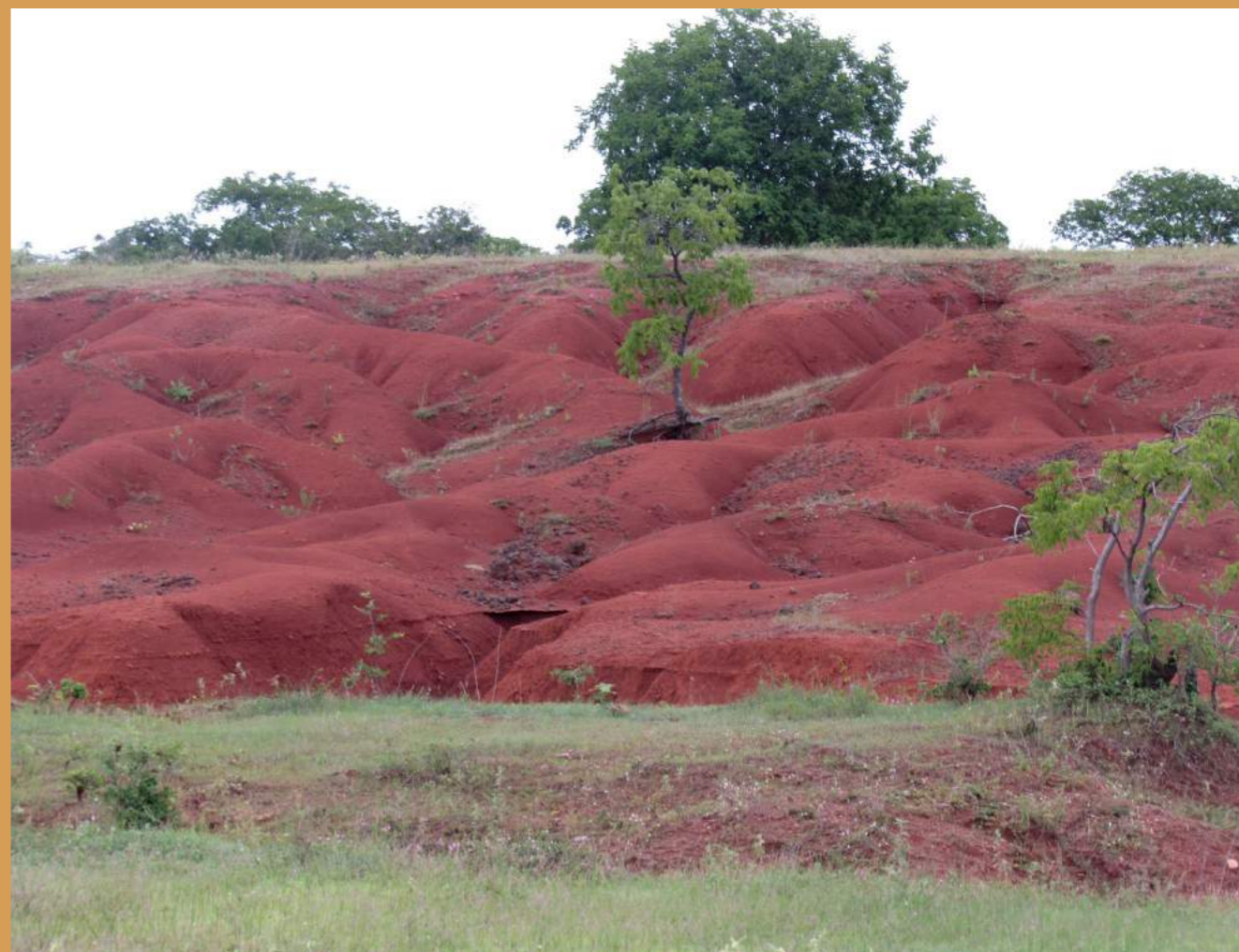
Exemplo de processo erosivo.
