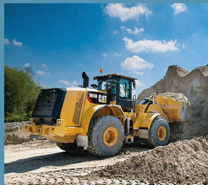
Retroscavadeira executando Terraplenagem
