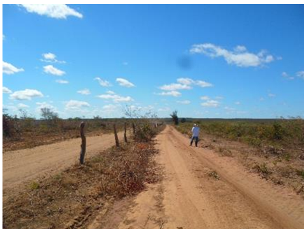
G - Visada para Az = 000°. Vista geral em direção à LT. Área de mata arbórea-arbustiva, recoberta por sedimentos inconsolidados. Ponto B017. (N8779294/E507378 - UTM/SIRGAS2000 23L).
