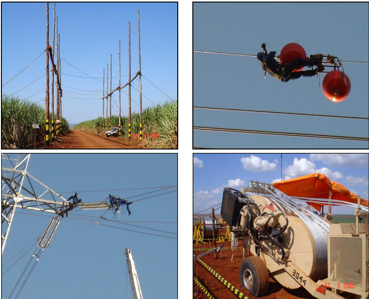
Figura 6.3-8 - Praça de lançamento dos cabos condutores, pára-raios, isolantes e acessórios
