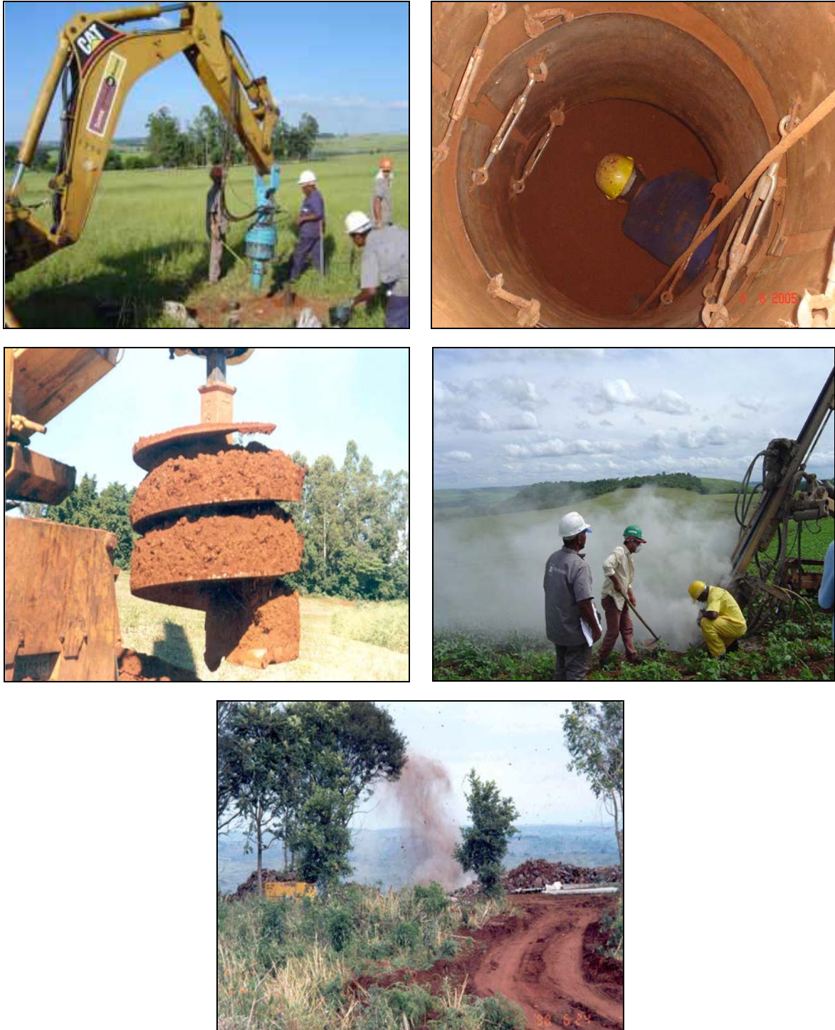
Figura 6.3-4 - Escavação para fundações das torres (acima) e utilização de explosivos (abaixo)
