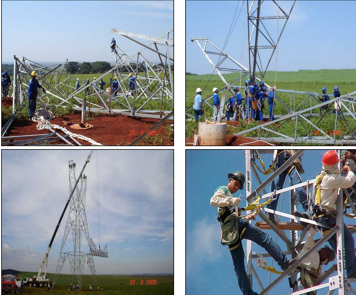
Figura 6.3-7 - Praça de montagens das torres
