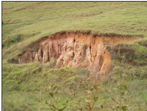
Figura 3.6.3.5-35 - Processo de voçorocamento instalado no corte de estrada
