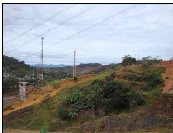
Figura 3.6.3.5-30 - Aspecto das encostas nas proximidades da subestação de Mesquita, extremidade noroeste do empreendimento, mostrando a ocupação desordenada dos solos desencadeando processos erosivos (UTM 757105/7851219)
