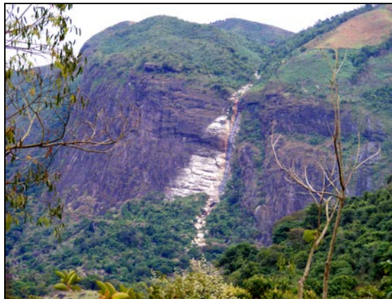
Figura 3.6.3.5-33 - Aspecto da encosta com cicatriz de um recente movimento de massa devido o solo com pouca espessura e alto grau de declividade
