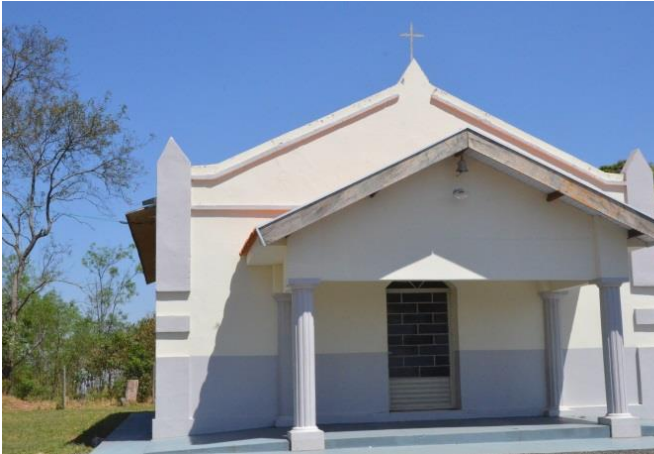
Figura 152: Capela de São Roque.( Sítio Água da Bananeira)
