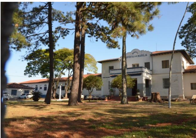
Figura 99: Hospital de consultas e internação.
