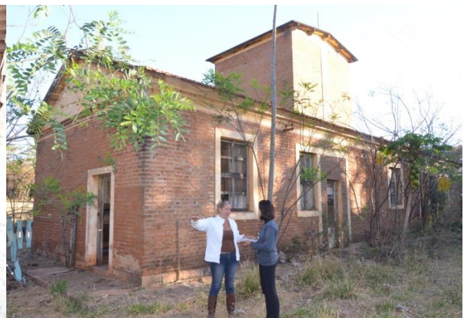
Figura 70: Casa de antigos funcionários na “Usininha”.
