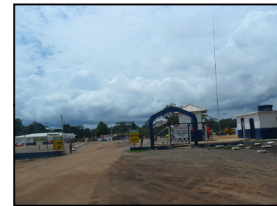
Ponto Notável N° 43 - Canteiro de Obras da Delta Engenharia
