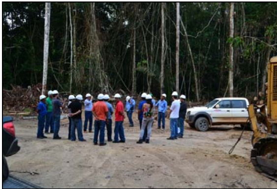
Figura 3-23 - Visita a LT CC 600 kV Porto Velho - Araraquara 02, nº 02, em fase de instalação. 26/09/2013.
