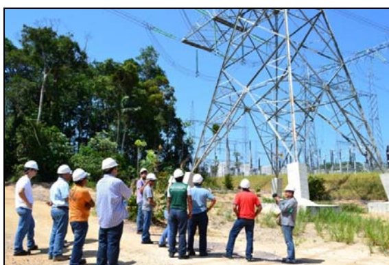
Figura 3-21 - Visita a LT 500 kV Oriximiná - Manaus, em fase de operação. 24/09/13.
