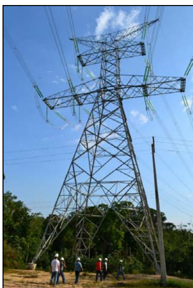
Figura 1-89 - Visita a LT 500 kV Oriximiná - Manaus, área de torre autoportante. 24/09/13.
