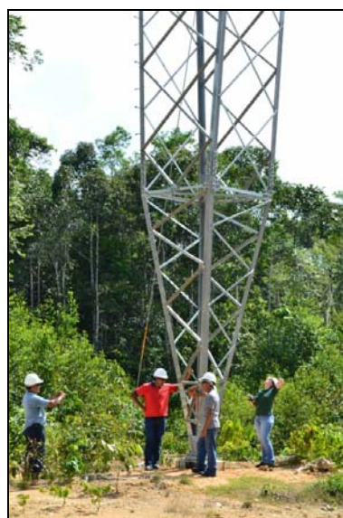
Figura 1-90 - Visita a LT 500 kV Oriximiná - Manaus, área de torre estaiada. 24/09/13.
