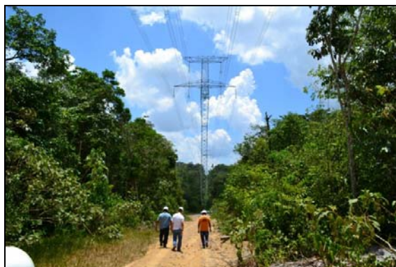
Figura 1-87 - Visita a LT 500 kV Oriximiná - Manaus, faixa de serviço. 24/09/13.
