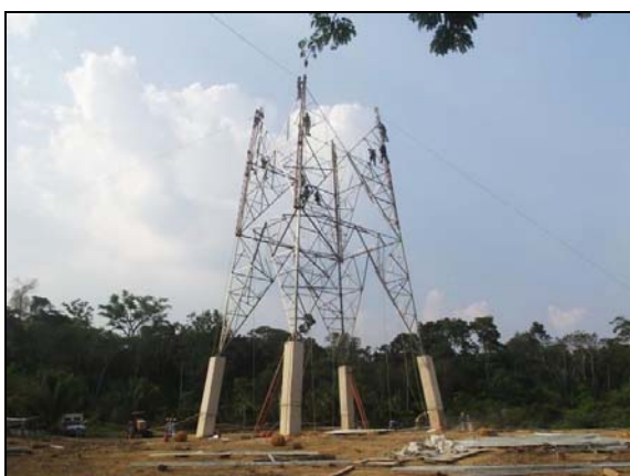
Figura 1-99 - LT CC 600 kV Porto Velho - Araraquara 02, nº 02, montagem de torre autoportante manual. 27/07/2013.
