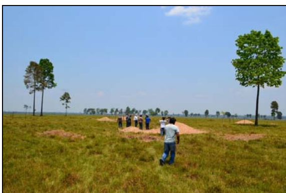
Figura 1-97 - LT CC 600 kV Porto Velho - Araraquara 02, nº 02, área de fundação de torre estaiada. 27/09/2013.
