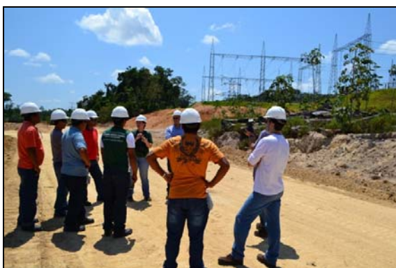
Figura 1-83 - Visita a LT 500 kV Oriximiná - Manaus, área da Subestação. 24/09/13.
