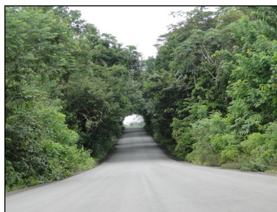
Figura 1-61 - Passagem natural de fauna. 25/07/2013.
