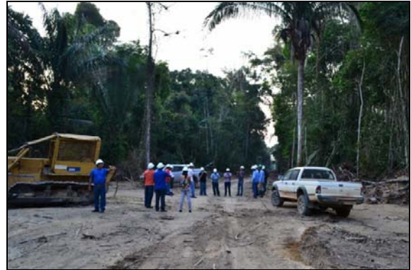
Figura 1-92 - Visita a LT CC 600 kV Porto Velho - Araraquara 2, n°02, supressão da vegetação em área de torre. 26/09/13.
