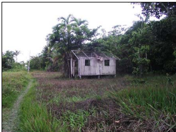
Figura 1-137 - Casa abandonada, comunidade Samaúma, rio Jauaperi. 05/10/2013.
