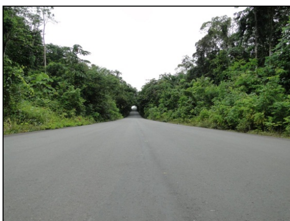
Figura 1-60 - Passagem natural de fauna. 25/07/2013.
