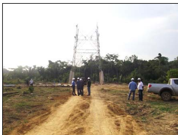
Figura 1-100 - LT CC 600 kV Porto Velho - Araraquara 02, nº 02, montagem de torre autoportante manual. 27/07/2013.
