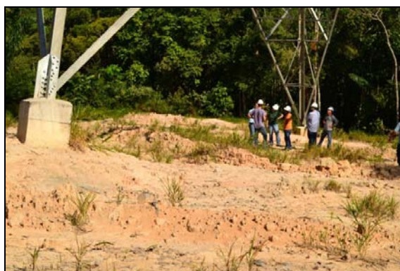
Figura 1-84 - Visita a LT 500 kV Oriximiná - Manaus, área de torre autoportante. 24/09/13.
