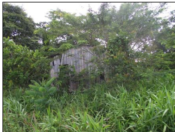
Figura 1-138 - Casa abandonada, comunidade Samaúma, rio Jauaperi. 05/10/2013.
