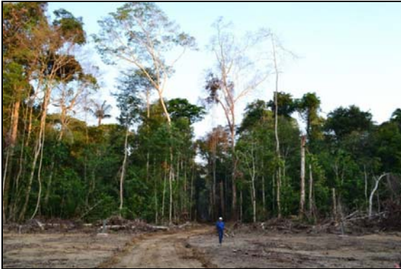
Figura 1-91 - Visita a LT CC 600 kV Porto Velho - Araraquara 2, n°02, supressão da vegetação e área de torre. 26/09/13.
