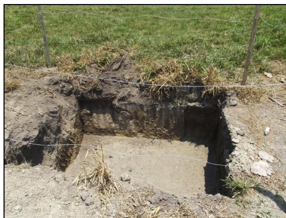
Figura 1-98 - Detalhe da área de fundação de torre estaiada. 27/09/2013.
