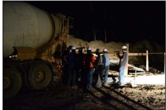
Figura 1-94 - Visita a LT 500 kV Oriximiná - Manaus, área de concretagem de torre autoportante. 26/09/13.
