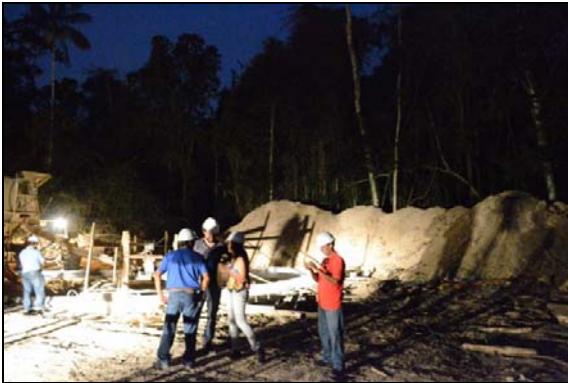
Figura 1-93 - Visita a LT 500 kV Oriximiná - Manaus, área de concretagem de torre autoportante. 26/09/13.
