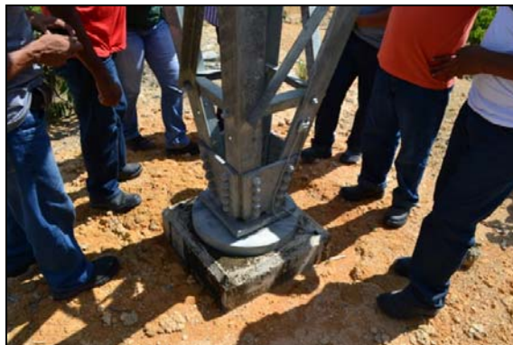
Figura 1-86 - Detalhe do mastro central da torre estaiada. 24/09/13.
