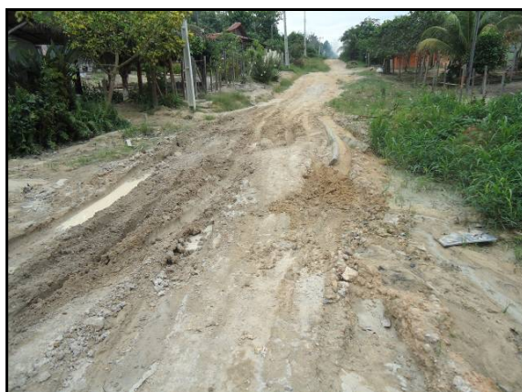
Figura 3.6.5.4-45 - Ramal da Comunidade Nova Canaã
