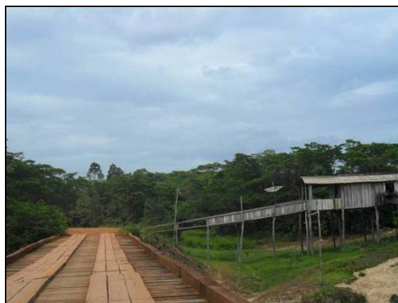
Figura 3.6.5.4-115 - Ponte sobre o Rio Baraúna
