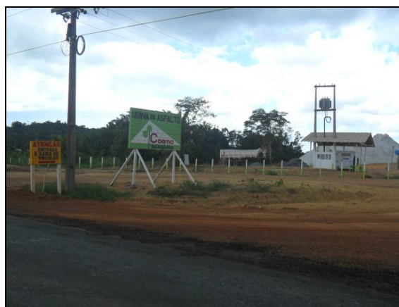
Figura 3.6.5.4-97 - Vicinal 06 - Usina de Asfalto - COEMA (788.511/110.255)
