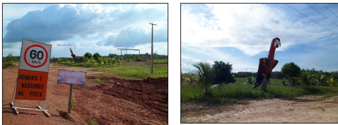
Figura 3.6.5.3-10 - Loteamento Arara Vermelha em construção em Rorainópolis
