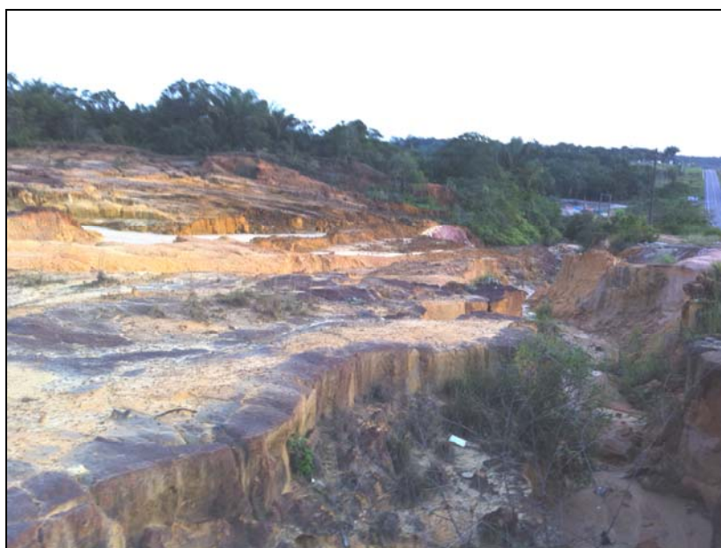
Figura 3.6.3.6-43 - Voçoroca ao lado da BR - 174, que segue no lado direito da imagem
