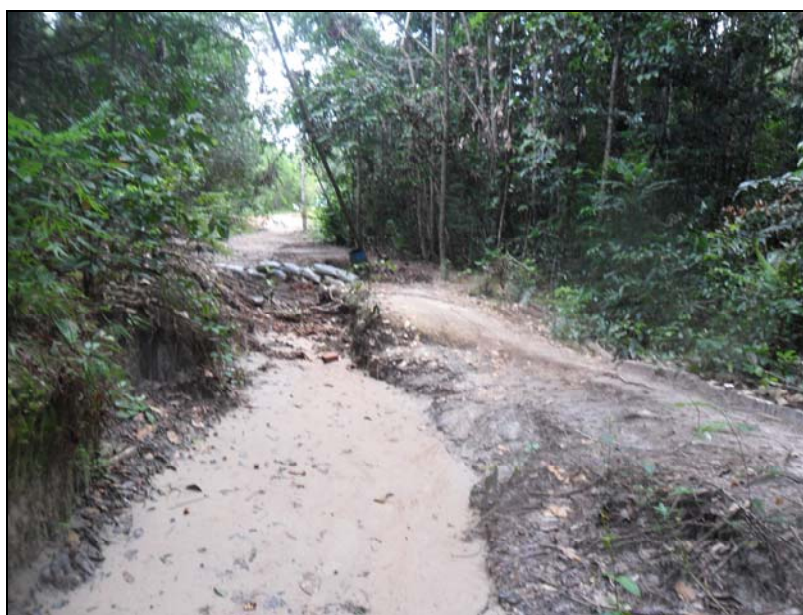
Figura 3.6.3.6-42 - Trilha para a cachoeira da Iracema com sacos de areia tentando conter a evolução do sulco erosivo, originado a partir do processo de escoamento superficial
