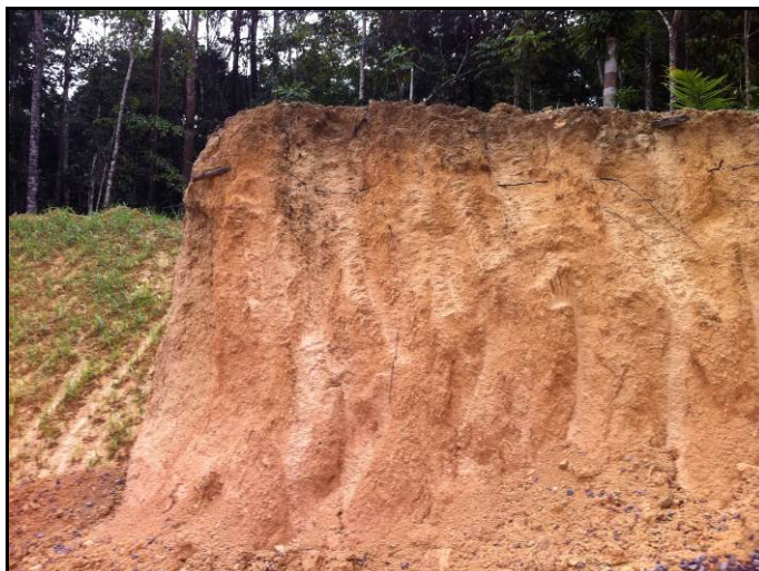
Figura 3.6.3.3-25 - Ocorrência do depósito argiloso amarelado, sobre as Formações sedimentares Alter do Chão, na estrada de acesso a Subestação Engenheiro Lechuga, próximo à cidade de Manaus/AM
