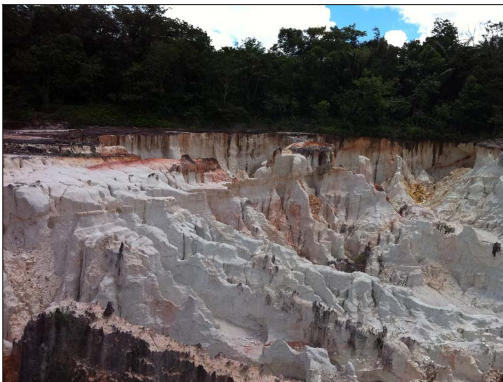
Figura 3.6.3.11-4 - Voçorocas instaladas no corte da Rodovia BR-174 sobre os arenitos friáveis da formação Alter do Chão
