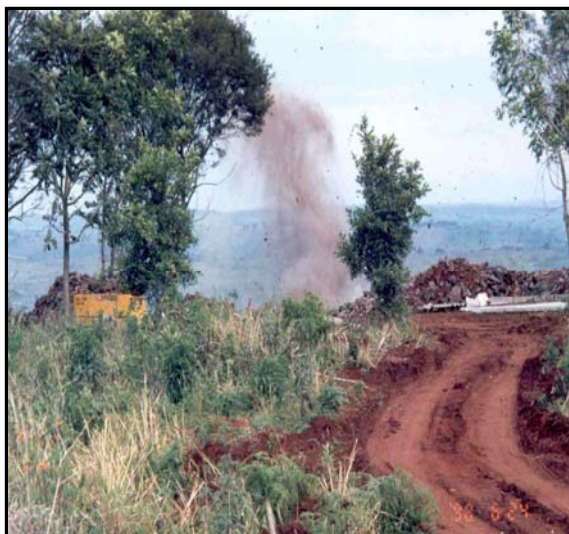
Figura 9.4.1-4 - Escavação para fundações das torres
