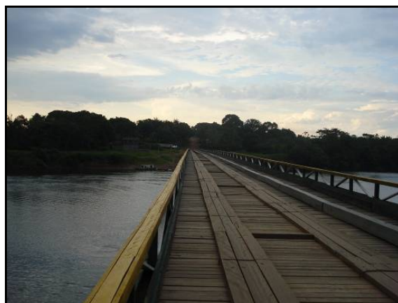
Figura 6.4.8-23 - Ponte sobre o rio Curuá, divisa de municípios
