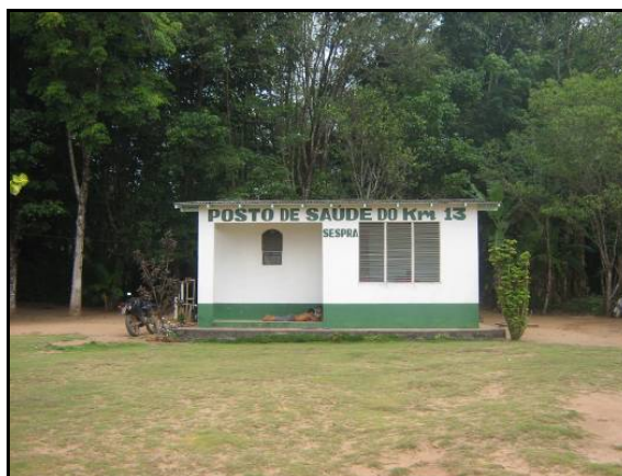
Figura 6.4.8-52 - PA-254 Posto de Saúde no Km 13.
