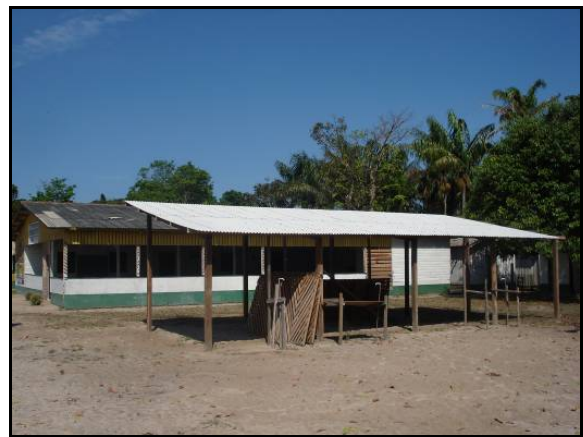
Figura 6.4.8-68 - Casas na palafita em Bela Vista.
