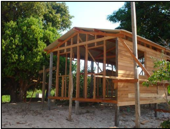
Figura 6.4.6-2 - Casa sendo construído utilizando recursos locais. Na comunidade de Praia Verde, município de Almeirim-PA.
