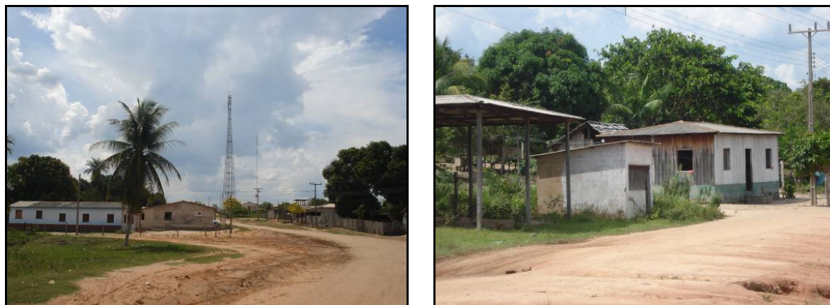
Figura 6.4.8-55 - Vista da sede do Jatuarana
