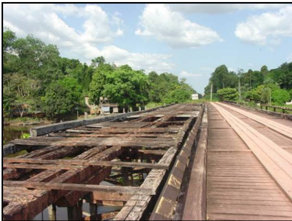
Figura 6.4.8-142 - Ponte na região do rio Vila Nova.
