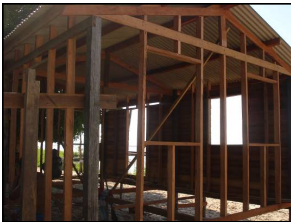
Figura 6.4.8-67 - Casas sendo construídas na comunidade
