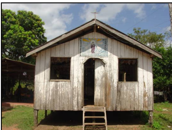
Figura 6.4.8-127 - Igreja de Santa Clara, na comunidade onde situa a COOPERALCA
