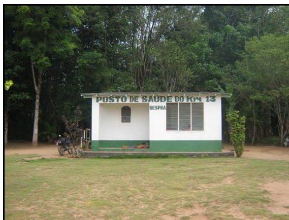
Figura 6.4.8-52 - PA-254 Posto de Saúde no Km 13.
