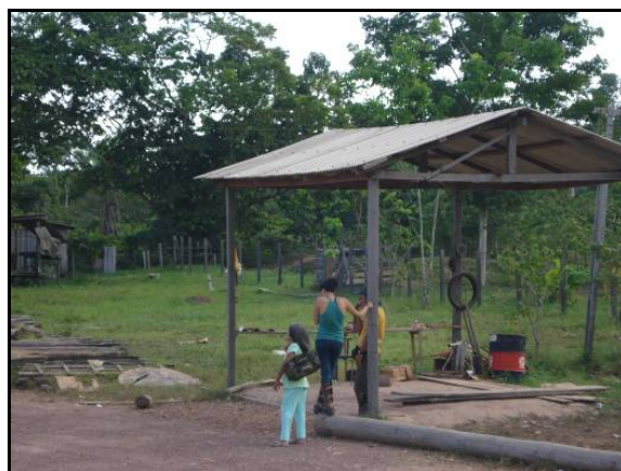
Figura 6.4.8-145 - Construção na Vila Nova.
