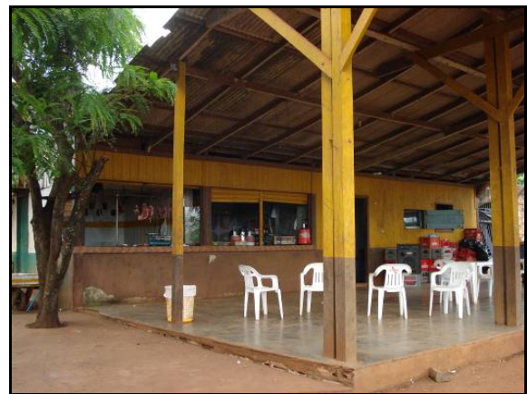
Figura 6.4.8-31 - Bar as margens da PA-254.
