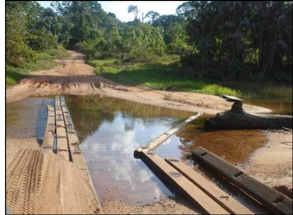
Figura 6.4.8-108 - Ponte sobre o Igarapé do Meio.
