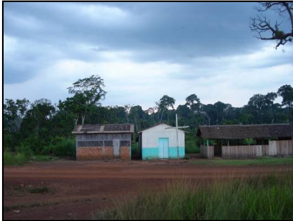
Figura 6.4.8-24 - Casas na região de Novo Progresso.
