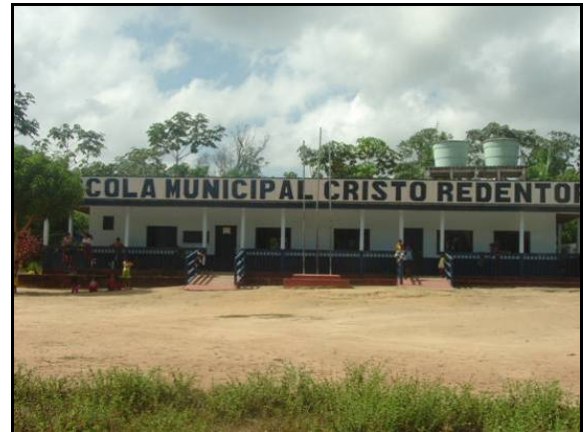
Figura 6.4.8-113 - Escola Municipal Cristo Redentor, as margens da BR-156, da comunidade do Martins
