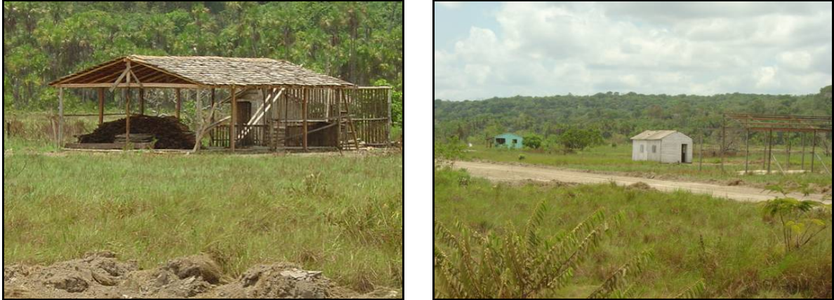
Figura 6.4.8-133 - Casas sendo erguidas na comunidade de Laranjal do Maracá.
