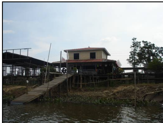
Figura 6.4.8-78 - Casas na palafita em Bela Vista.
