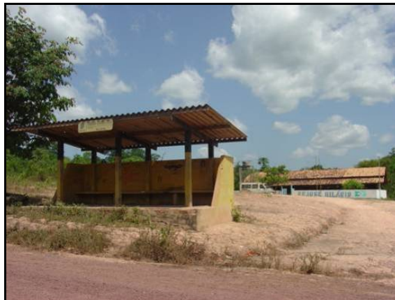
Figura 6.4.8-141 - Ponto de ônibus com escola ao fundo.
