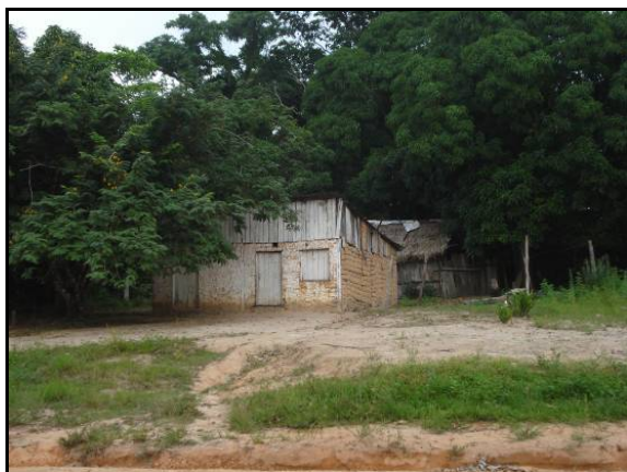
Figura 6.4.8-2 - Padrão construtivo na comunidade Poção
