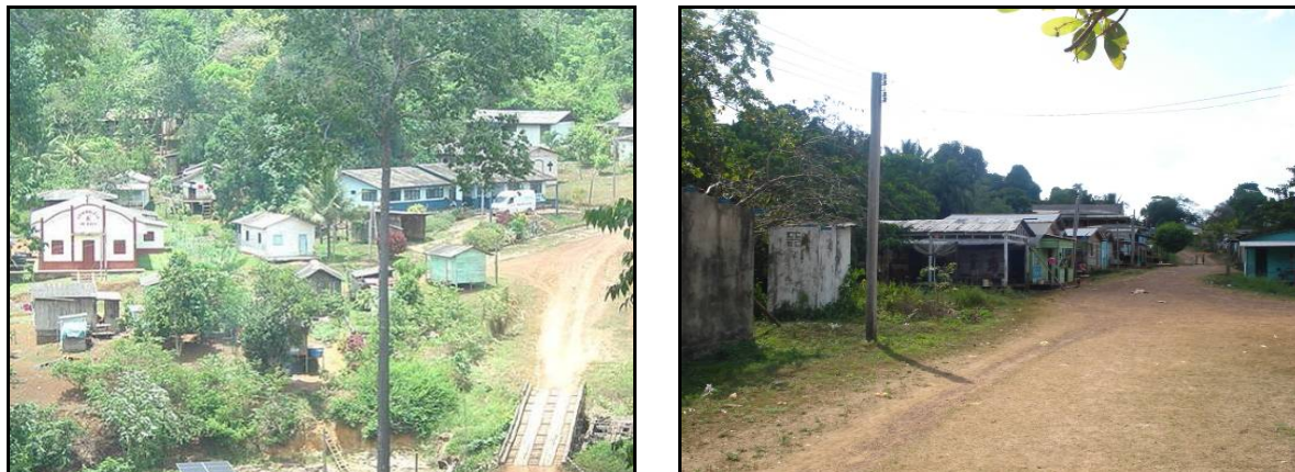
Figura 6.4.8-121 - Povoado de Água Branca do Cajari, nas margens da BR-156.
