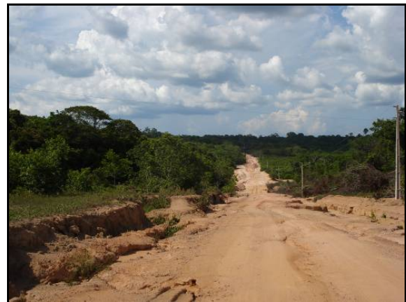
Figura 6.4.3-11 - Trecho da rodovia PA-254 entre Óbidos e Oriximiná.
