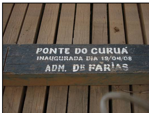
Figura 6.4.3-13 - Identificação da inauguração da ponte.
