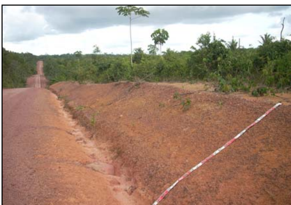
Foto 17 - Relevo suave ondulado em colinas amplas com Plintossolo Pétrico concrecionário distrófico, com vegetação de floresta. UTM 429372/0001175
