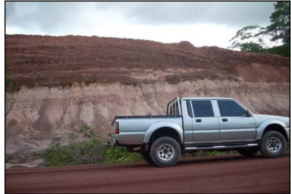
Foto 14 - Corte de estrada em relevo de colina, com Latossolo em superfície e camada de plintita em subsuperfície (plintite), em área de floresta. UTM 437503/0016812
