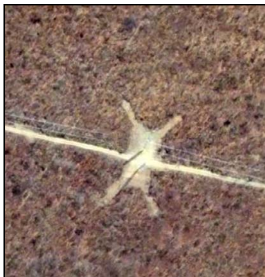
Figura 3-31 - Exemplo de torres estaiada instalada com mínima supressão de vegetação.
