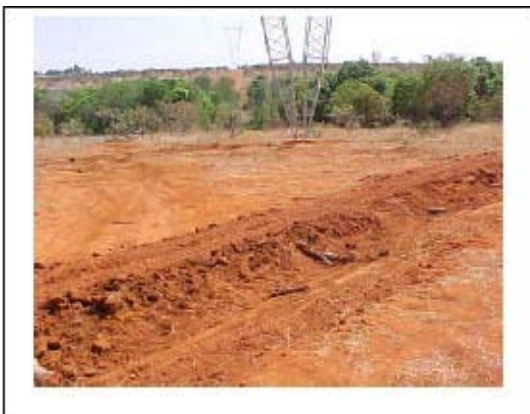
Foto 12-11 – Dispositivo provisório de drenagem para evitar erosão na área da torre.
