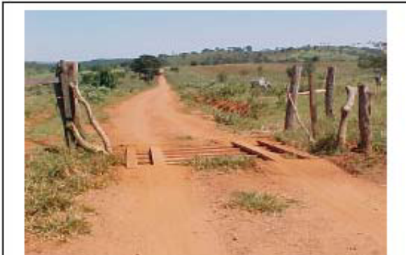
Foto 12-23 – Restauração de mata-burro danificado na obra.
