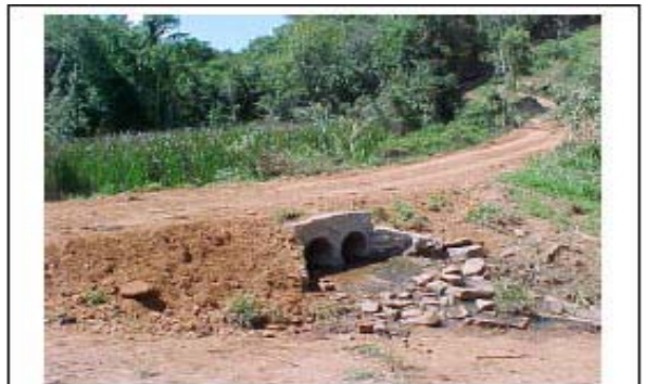
Foto 12-26 – Dispositivos de drenagem nas travessias de córregos.
