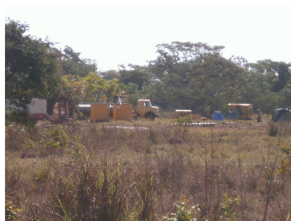
Foto 11-66 – Praça de Lançamento de cabos condutores.
