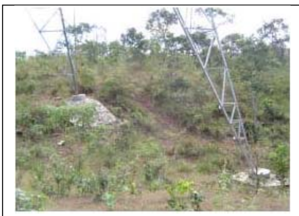
Foto 11-75 – Proteção definitiva na base. A cobertura vegetal conteve os processos erosivos.
