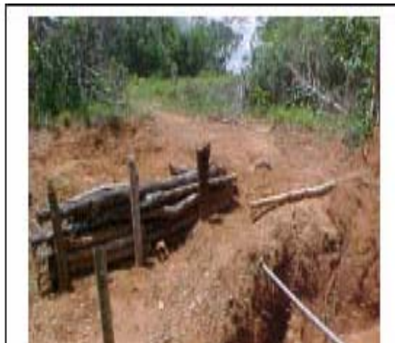
Foto 12-8 – Medida provisória para o controle de erosão.
