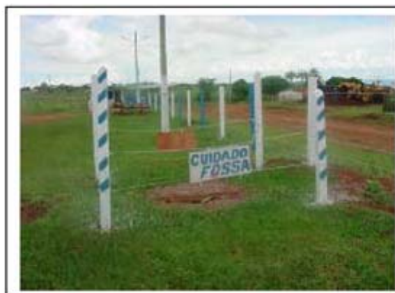
Foto 12-18 – Tratamento e disposição apropriados dos esgotos gerados no canteiro.
