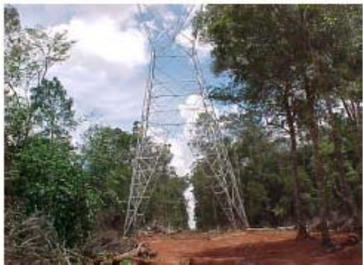
Foto 11-29 – Abertura da faixa com 3m de largura e corte seletivo de vegetação.
