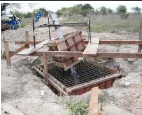
Foto 11-47 – Fundação in loco .
