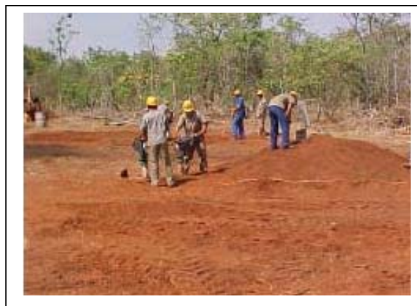
Foto 11-50 – Recomposição da área de fundação.
