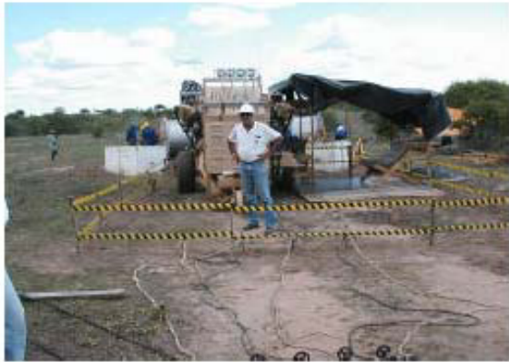
Foto 11-61 – Praça de lançamento de cabos locada corretamente.
