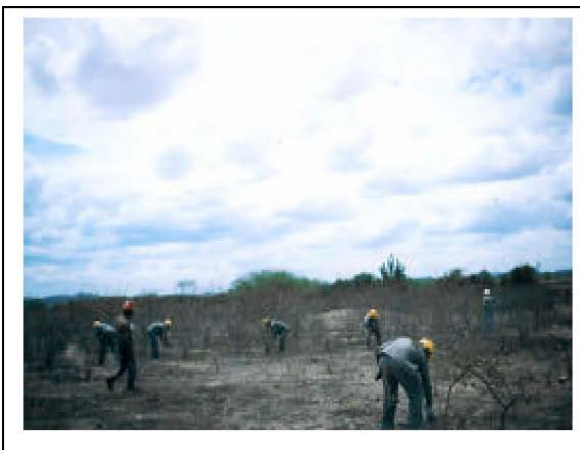
Foto 11-37 – Limpeza da área de torre com facão, sem uso de maquinaria pesada.
