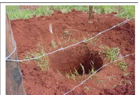
Foto 11-41 – Detalhe da escavação com broca do mastro central.
