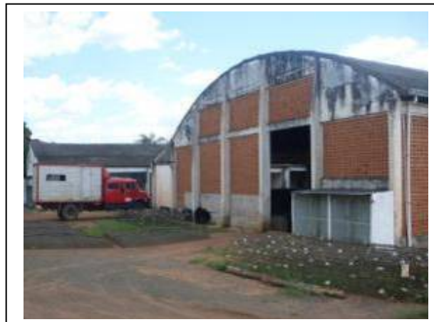
Foto 12-2 – Exemplo de canteiro. Galpão em bom estado de manutenção. Armazenamento de Bobinas.
