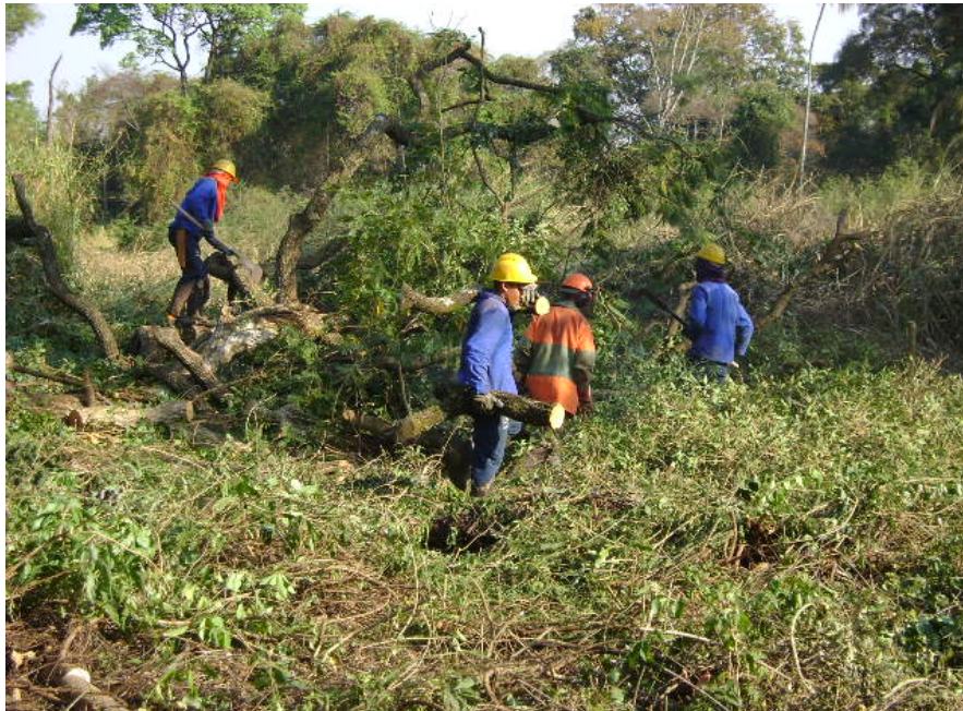
Foto 9-17 – Desdobro de toras, durante o processo de Supressão da faixa de serviço (outra LT).
