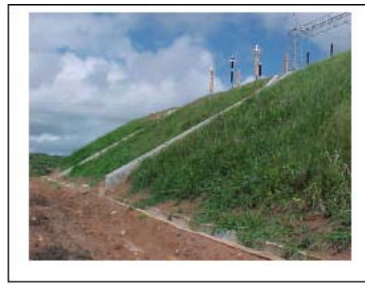
Foto 12-16 – Taludes com dispositivos de drenagem.
