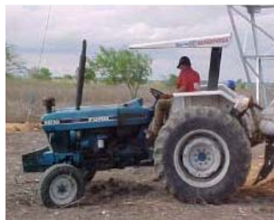
Foto 11-65 – Uso de trator para instalação do aterramento.
