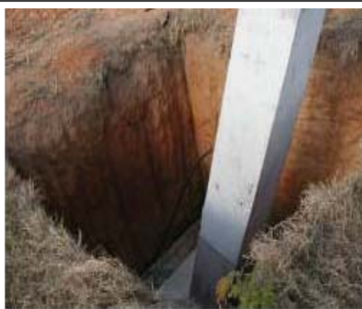
Foto 11-48 – Fundação pré-moldada.
