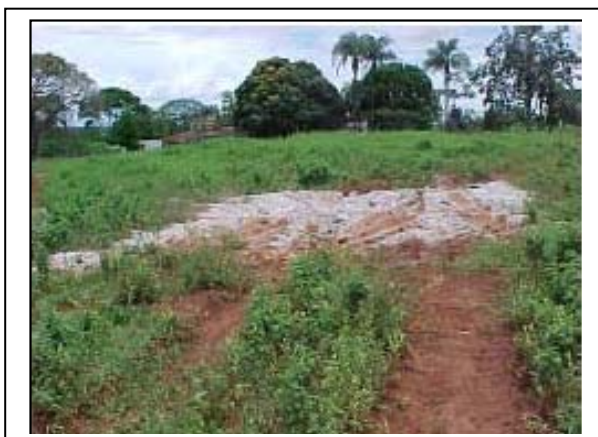
Foto 12-3 – Não conformidade: disposição de restos de concreto no campo.
