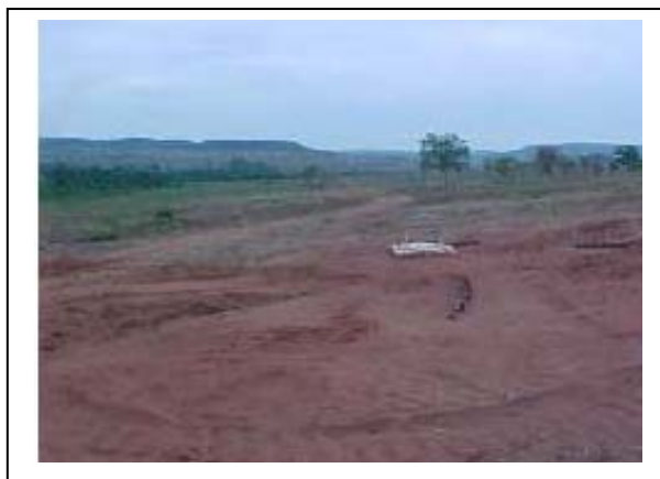
Foto 11-49 – Recomposição da área de fundação.
