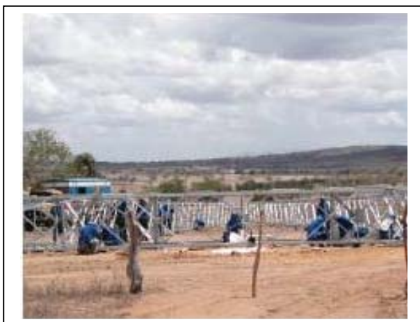
Foto 11-55 – Processo de montagem de torres.
