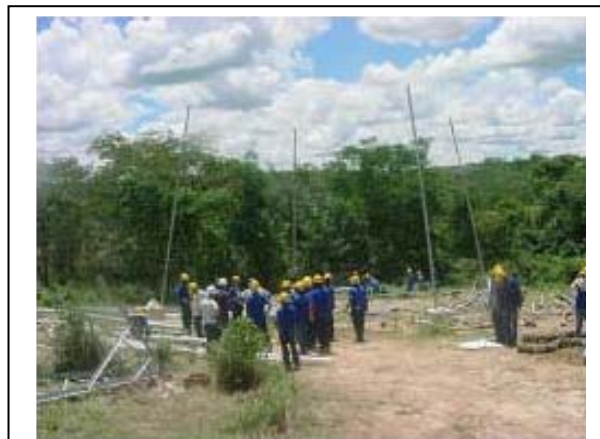
Foto 11-54 – Processo de montagem de torres.
