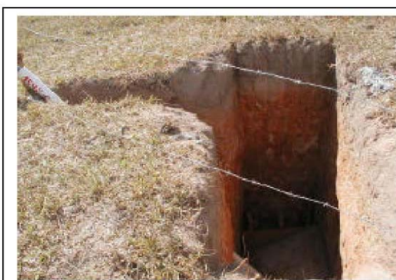
Foto 11-42 – Detalhe da escavação do estai.
