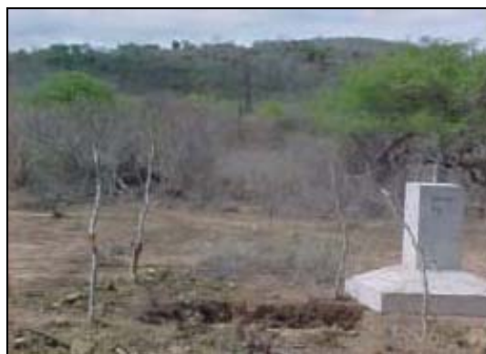
Foto 11-44 – Fundação pré-moldada.
