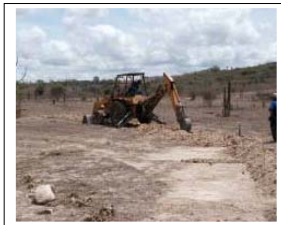
Foto 11-68 – Uso de trator para instalação do aterramento.
