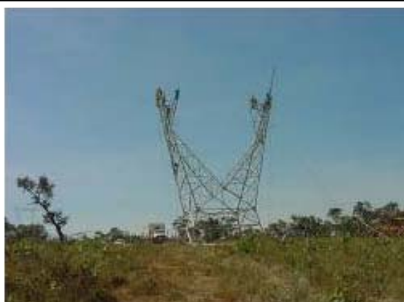
Foto 11-57 – Processo de montagem de torres.
