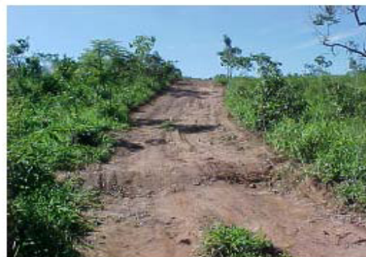
Foto 12-10 – Acesso com dissipadores de energia.
