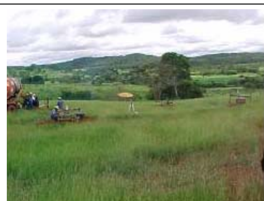
Foto 11-45 – Fundação in loco .
