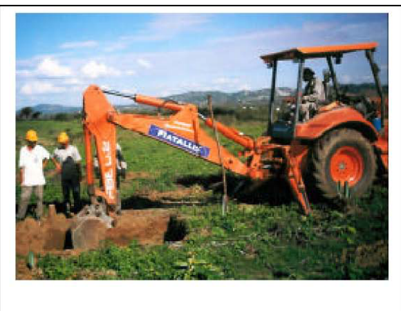
Foto 11-39 – Escavação de uma das fundações de uma torre autoportante.
