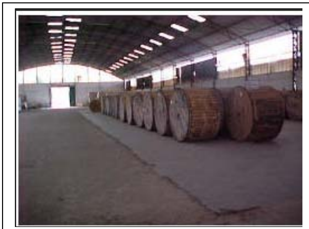
Foto 12-1 – Exemplo de canteiro. Galpão em bom estado de manutenção. Armazenamento de Bobinas.
