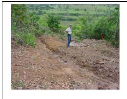
Foto 12-12 – Dispositivo provisório de drenagem para evitar erosão na área da torre.
