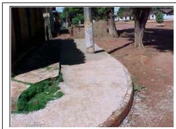
Foto 12-4 – Disposição apropriada de restos de concreto.
