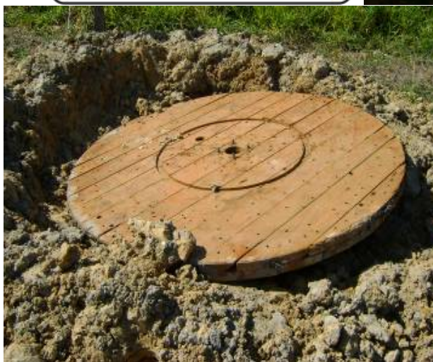
Fotos 10-1 a 10-4 – Placa de sinalização. Isolamento da cava utilizando lateral de bobina (à esquerda) e cerca de arame e tampa de madeira (à direita)
