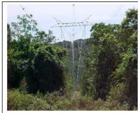
Foto 11-34 – Abertura da faixa com 3m de largura e corte seletivo de vegetação.
