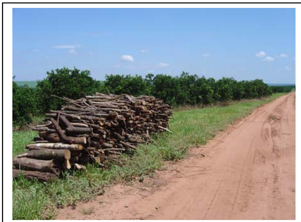
Foto 9-18 – Material vegetal suprimido empilhado, cubado e removido, sendo colocado à disposição do proprietário (outra LT).
