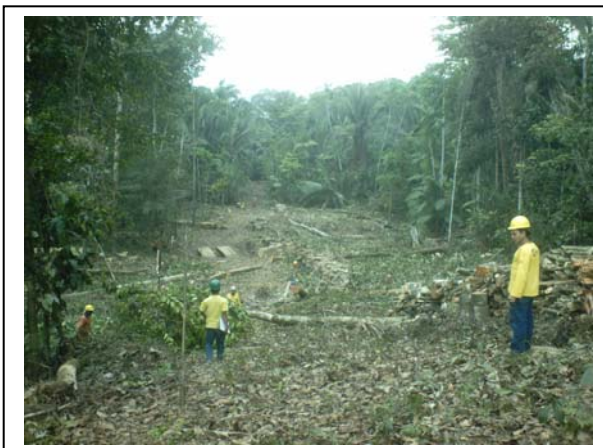
Foto 9-1. Faixa de serviço sendo aberta (em outra obra).
