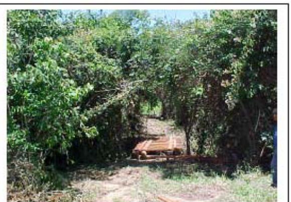
Foto 12-27 – Pontes provisórias para evitar danos aos cursos de água.
