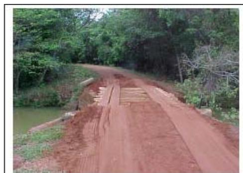
Foto 12-22 – Pontes provisórias para evitar danos aos cursos d'água.
