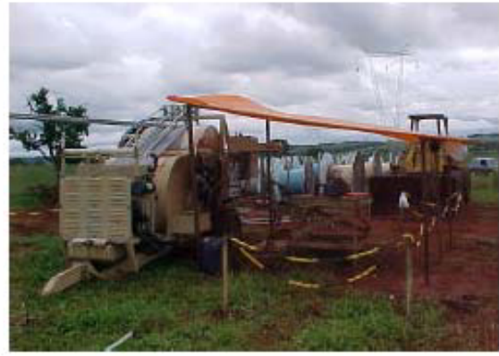
Foto 11-62 – Praça de lançamento de cabos locada corretamente.
