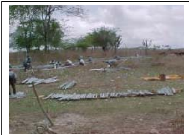
Foto 11-51 – Processo de montagem de torres.
