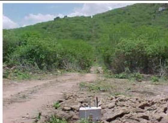
Foto 11-32 – Abertura de faixa com largura de 3m e o acesso no eixo da LT.
