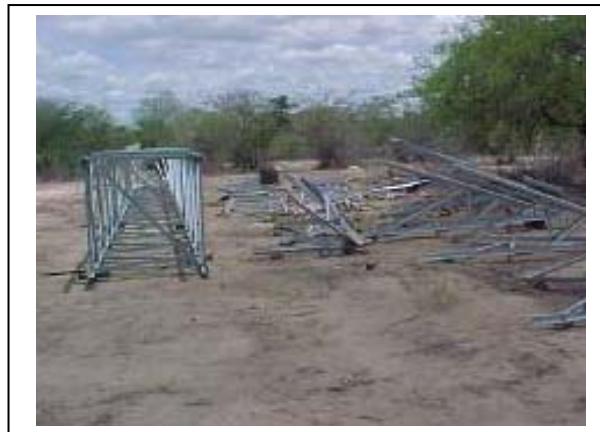
Foto 11-52 – Processo de montagem de torres.
