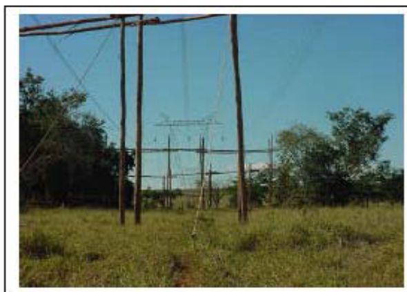
Foto 11-60 – Instalação de cavalete para o cruzamento de uma LT.
