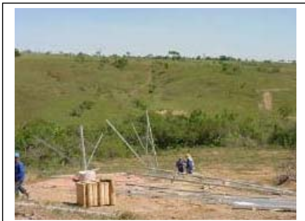
Foto 11-53 – Processo de montagem de torres.
