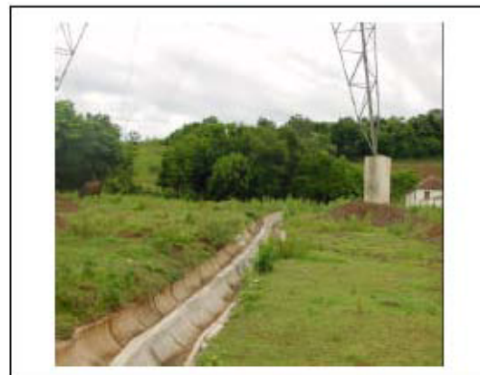
Foto 12-14 – Dispositivo permanente de drenagem para proteger o pé da torre sobrelevada.
