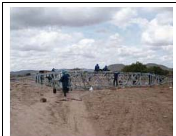
Foto 11-56 – Processo de montagem de torres.
