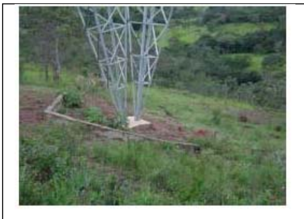
Foto 11-73 – Dispositivo para estabilização do solo e proteção do mastro central da torre.
