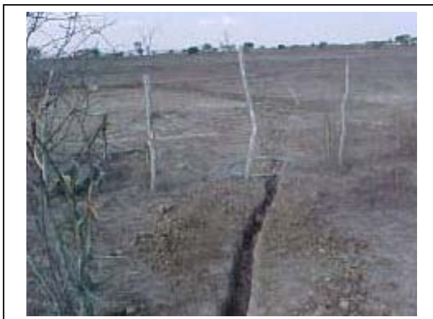
Foto 11-67 – Vala para instalação do aterramento.
