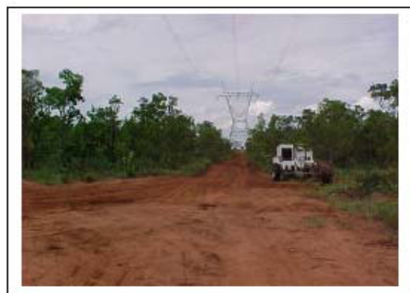
Foto 11-72 – Acesso utilizando a faixa de serviço.
