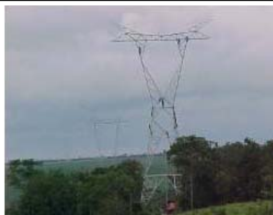
Foto 11-58 – Processo de montagem de torres.
