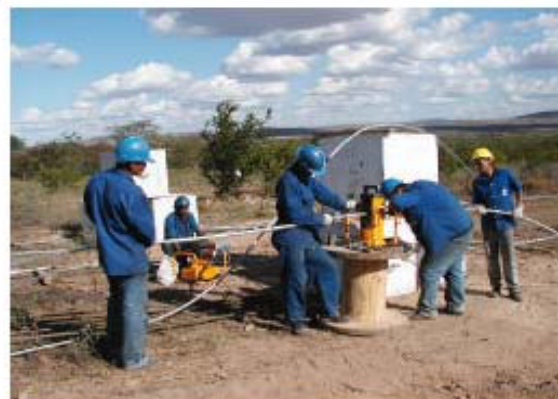
Foto 11-64 – Lançamento de cabo.
