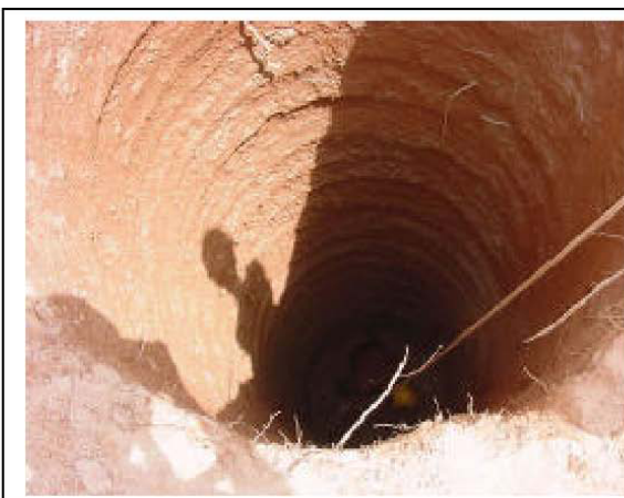
Foto 11-40 – Escavação de uma das fundações.
