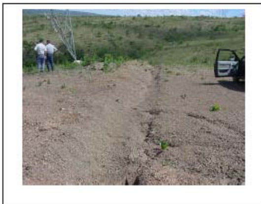
Foto 12-13 – Dispositivo provisório de drenagem para proteger o pé da torre.
