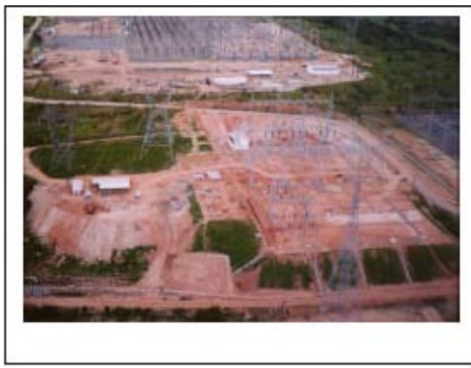
Foto 12-15 – Taludes com e sem dispositivos de drenagem.
