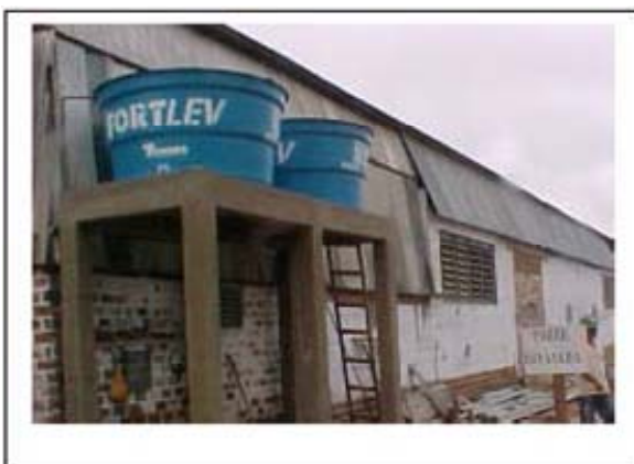
Foto 12-17 – Armazenamento apropriado de água para consumo no canteiro.
