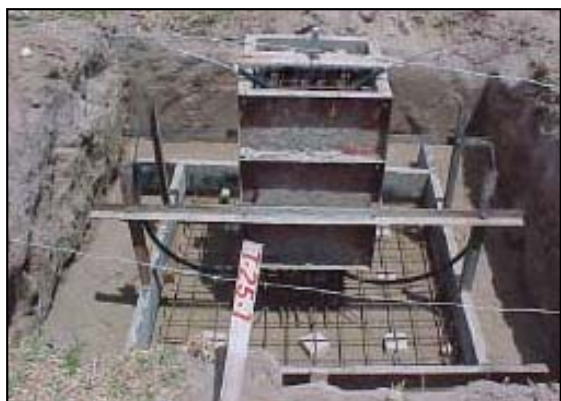
Foto 11-43 – Fundação in loco .
