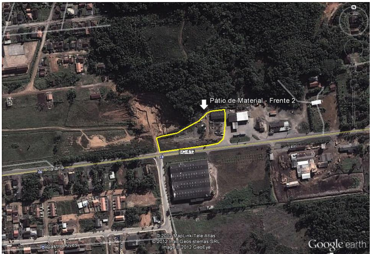
Figura 4 – Localização e entorno do pátio da CELESC, que está sendo desmobilizado e será utilizado como Pátio de Material – Frente 2
