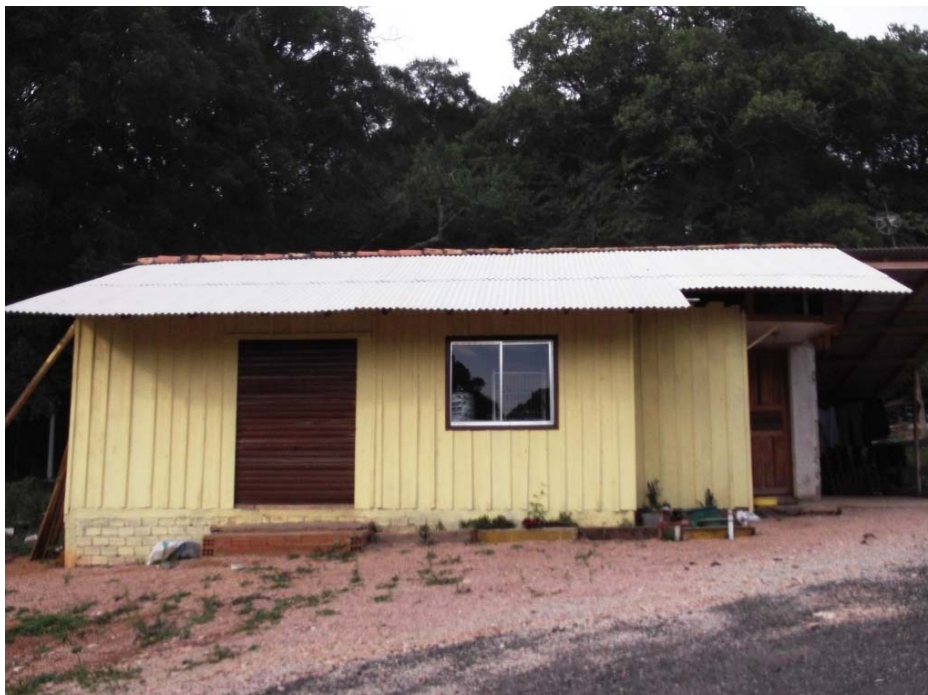
Fotos 3 – Casa nova que foi construída
