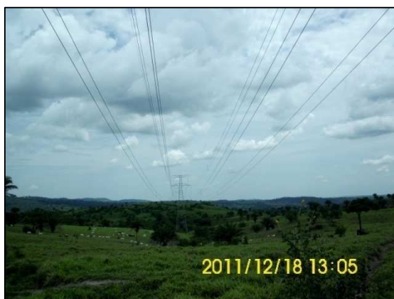
Alinhamento da LT Vilhena-Jauru em área de pasto
