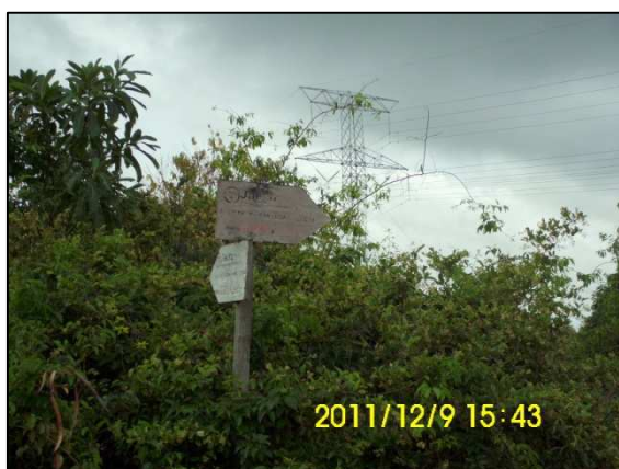
Vista de torre da LT Vilhena – Jauru – Ponto 149
