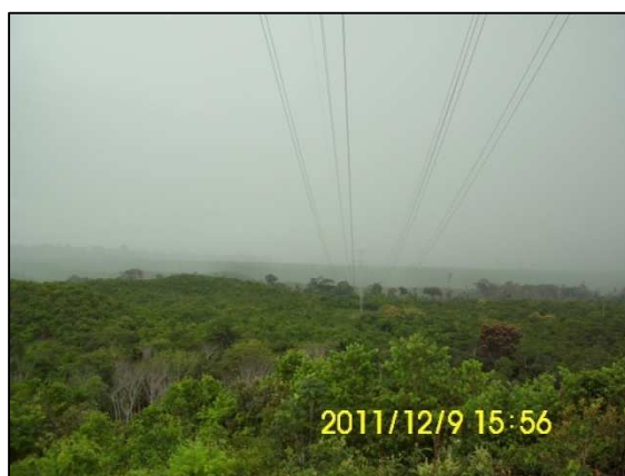
Vista do alinhamento da LT Vilhena – Jauru – Ponto 076
