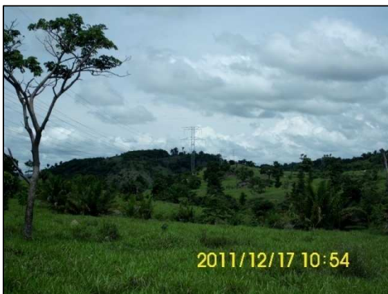
Torre da LT Vilhena-Jauru em área de pasto
