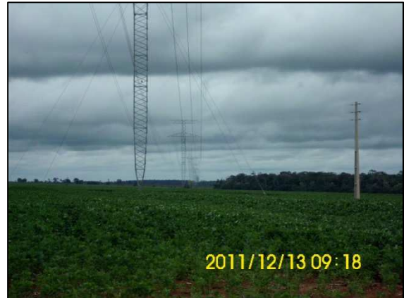
Vista de fragmento florestal e LT Vilhena-Jauru na plantação de soja – Ponto 163
