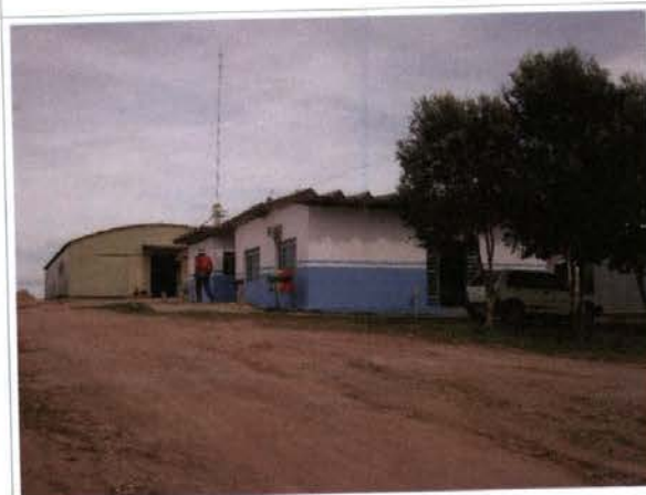
Foto 03 – Galpão e edificações anteriormente existentes reformadas e remodeladas para escritórios e almoxarifado
