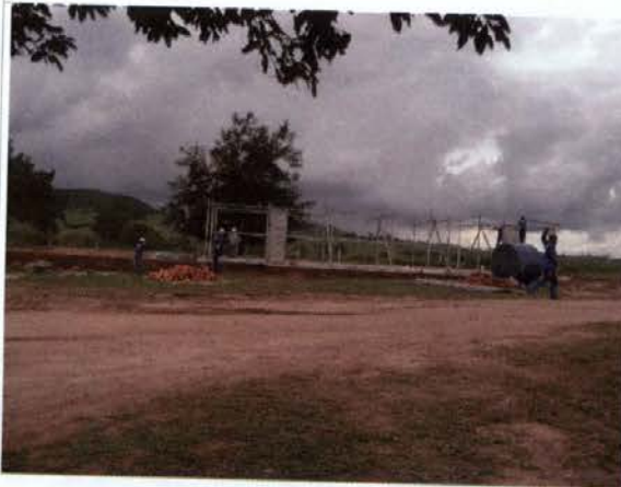
Foto 09 – Refeitório em instalação
