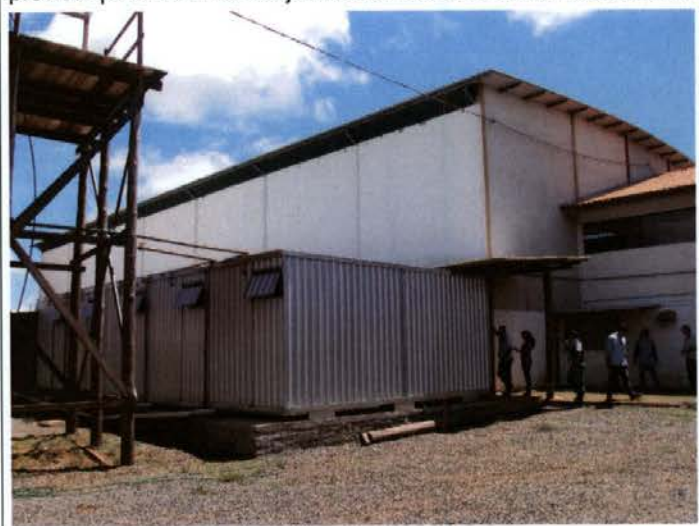
Foto 53: sanitários do tipo contêiner instalados junto ao galpão previsto para servir de alojamento. Fossas estavam construídas
