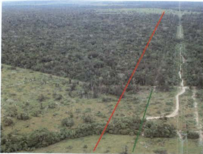
Foto 141: vista de fragmento na altura do km 500 do traçado da nova Linha, saindo da SE Pimenta Bueno em direção a Vilhena. Trecho de paralelismo dos 3 Circuitos: LVTE, JTE, Eletronorte.
