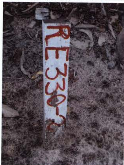
Foto 357: após percurso pelo assentamento, que fica na área que poderia ser alternativa ao traçado paralelo, foi alcançado o local proposto para instalação da torre 330-2 da LT da LVTE .
