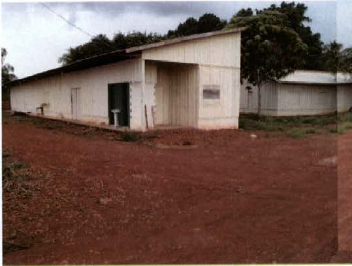
Foto 07: vista do centro para a parte frontal do terreno proposto pela LVTE para instalação do Canteiro de Candeias do Jamari.
