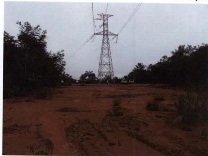
Foto 360: Entre Vilhena e Porto Velho, a LT existente é o Circuito 1 da Eletronorte (torre e áreas degradadas abaixo, na altura do km 360 do traçado da LVTE). O C2, da JTE, está em Instalação.
