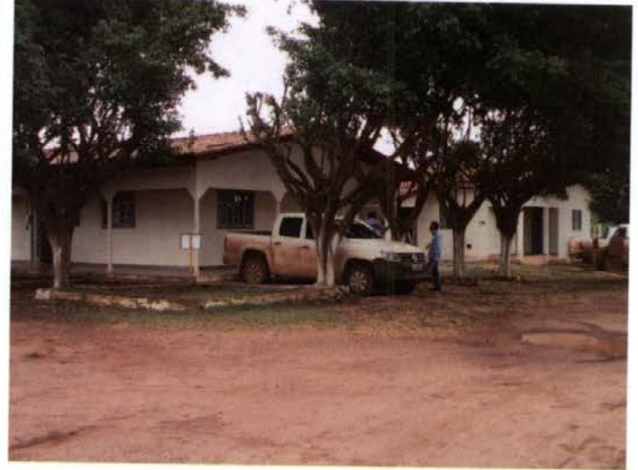
Foto 344: após a vistoria no primeiro ponto do trecho do km 325 ao 338, foi visitada a área proposta pela LVTE para instalação do Canteiro e Alojamento de Vilhena. Edificações existentes.
