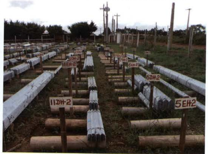
Foto 346: depósito de peças das estruturas metálicas das torres na área proposta para Canteiro e Alojamento de Vilhena.
