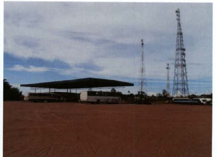
Foto 132: posto de gasolina na Vila Guaporé, onde está instalado um alojamento da JTE, que também instalará ali um canteiro.
