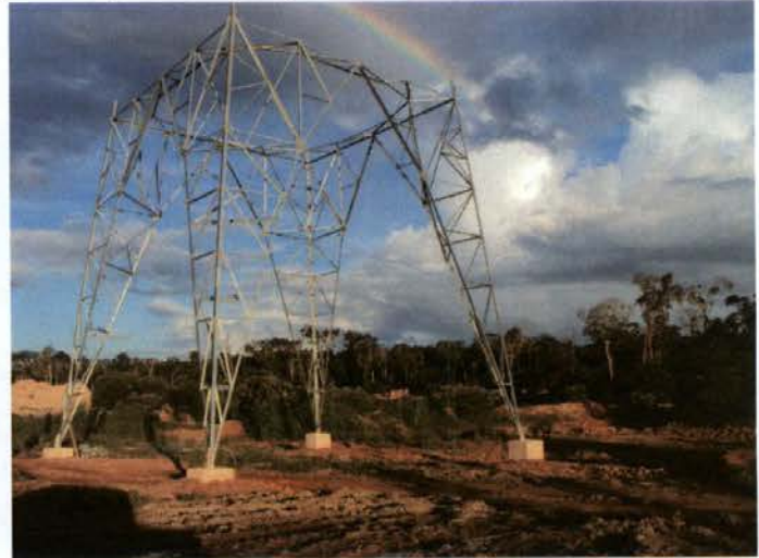
Foto 24: antes de chegar à área que de lavra, foi possível verificar o andamento final da montagem de torres da Linha da JTE (Circuito 2), com traçado paralelo ao Circuito 1 da LT Eletronorte.
