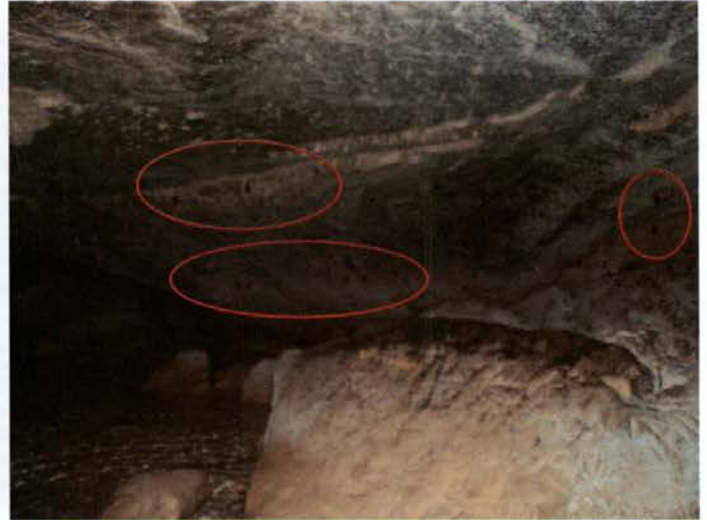
Foto 164: aspecto da parede lateral, com marcas de ampliação por erosão hídrica. No dia da vistoria foi possível contar um grupo de quirópteros de cerca de 20 indivíduos.
