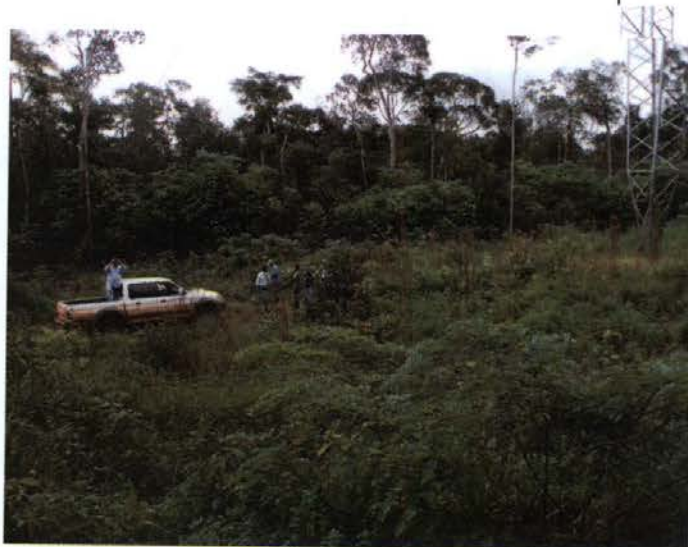
Foto 335: na altura do km 310, supressão vegetal em toda a base de torre estaiada.
