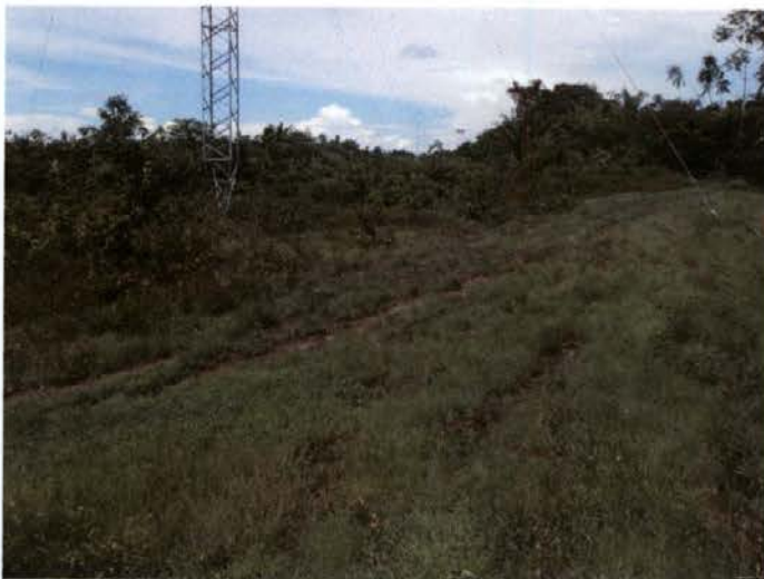
Foto 131: aspecto de campo úmido marginal ao córrego Melgacinho. Observa-se torre estaiada da LT C1 Eletronorte.
