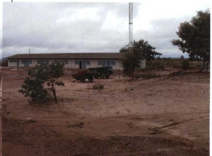
Foto 252: notar as edificações existentes que serão aproveitadas. O local foi utilizado como canteiro pela Jauru Transmissora - JTE.
