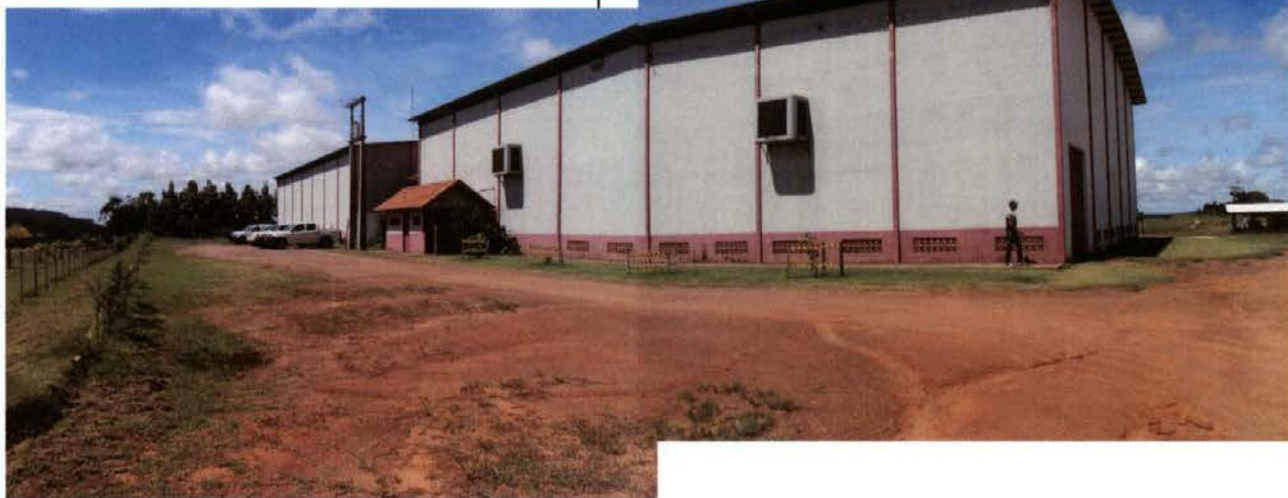
Foto 45: vista de pátio frontal da área proposta para o Canteiro e Alojamento de Ouro Preto do Oeste, local que foi autorizado pelo IBAMA apenas para instalação de depósito de materiais.
