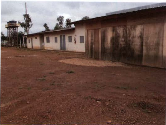
Foto 347: galpão existente no local que deverá ser aproveitado para construção dos alojamentos de trabalhadores.
