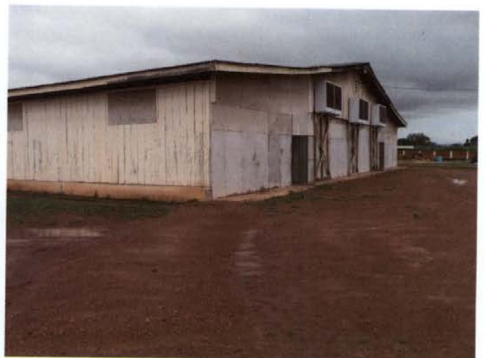
Foto 348: nova vista da mesma edificação existente no local.
