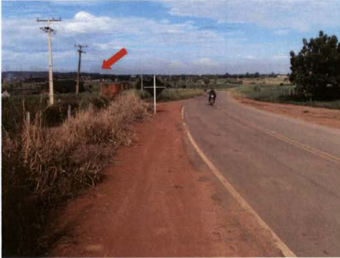
Foto 31: rodovia em frente à área proposta para instalação do Canteiro de Ariquemes, primeiro ponto vistoriado no dia 20. Essa via dá acesso à cidade, situada ao fundo da foto (seta).
