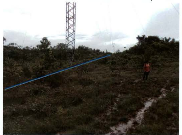
Foto 94: a LT Eletronorte C1 passa no topo da vertente oposta do tributário atravessado. Base de estaiada totalmente suprimida.
