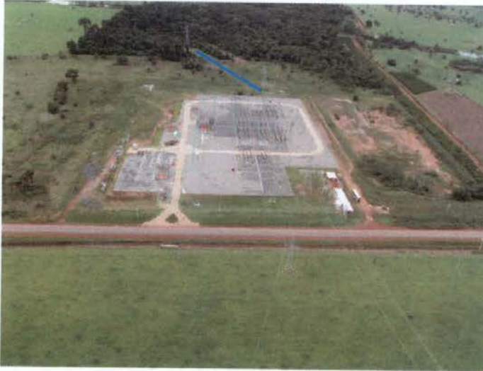
Foto 139: vista da SE Pimenta Bueno pela estrada de acesso.
