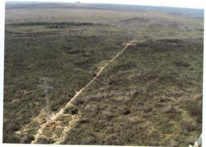
Foto 236: trecho entre o km 75 e 70. Supressão vegetal realizada em toda a área da base da torre estaiada.
