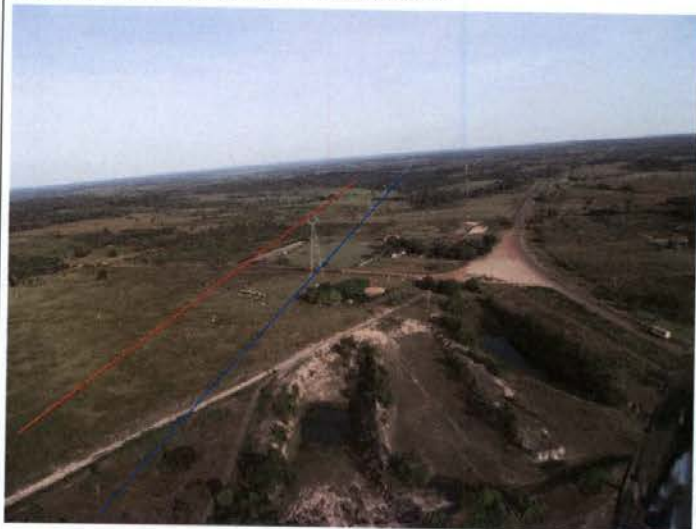
Foto 151: relevo plano e supressão da vegetação nativa na altura do km 466 , onde a LT existente e a diretriz paralela da LVTE voltam a se aproximar da BR-364.
