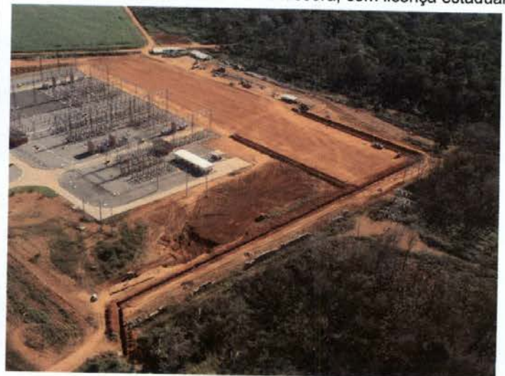
Foto 180: obras de ampliação da SE Vilhena, vinculadas à LT 230 kV Vilhena-Samuel, da Jauru Transmissora, com licença estadual.
