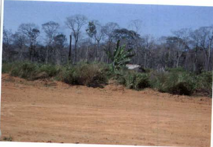
Foto 306: lote recém implantado do Assentamento Águas Claras.
