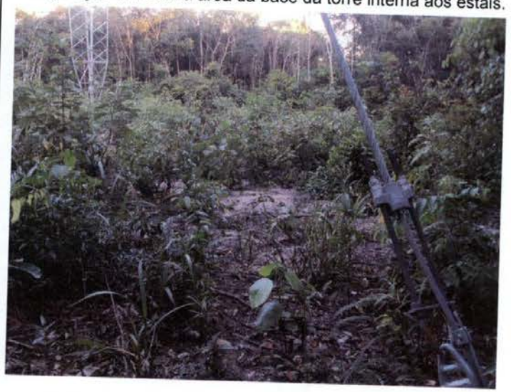
Foto 299-H: vista a partir do ponto de ancoragem/fundação do estai de torre na faixa da LT existente, evidenciando a supressão de vegetação em toda a área da base da torre interna aos estais.
