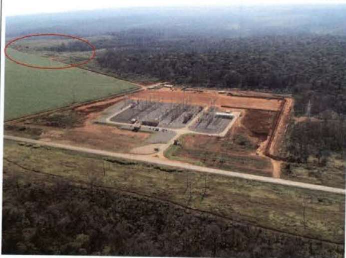
Foto 179: Segundo dia de vistoria aérea (16/05/2011), a partir de Vilhena. O assentamento assinalado seria visitado por terra.
