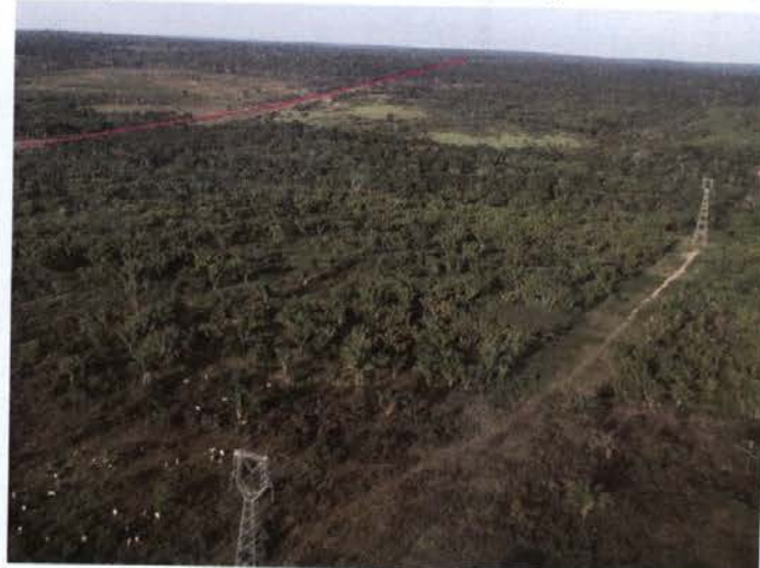
Foto 156: após o cruzamento com a BR-364, a faixa existente e a LVTE voltam a se afastar da rodovia (magenta), altura do km 447 .
