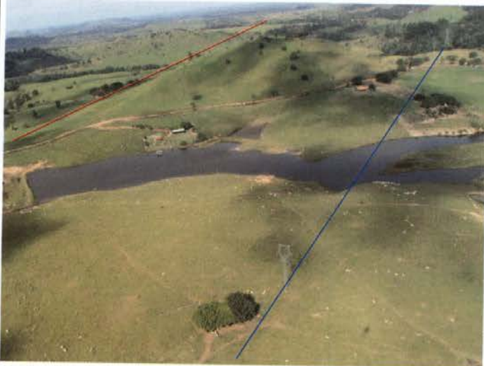
Foto 118: na altura do km 572, a LT existente intercepta área de ocupações e benfeitorias. A LVTE propõe um desvio.
