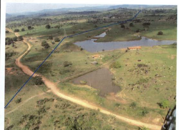
Foto 108: desvio pontual de traçado realizado pela LT existente em razão de interferência com moradias e benfeitorias na altura do km 602.
