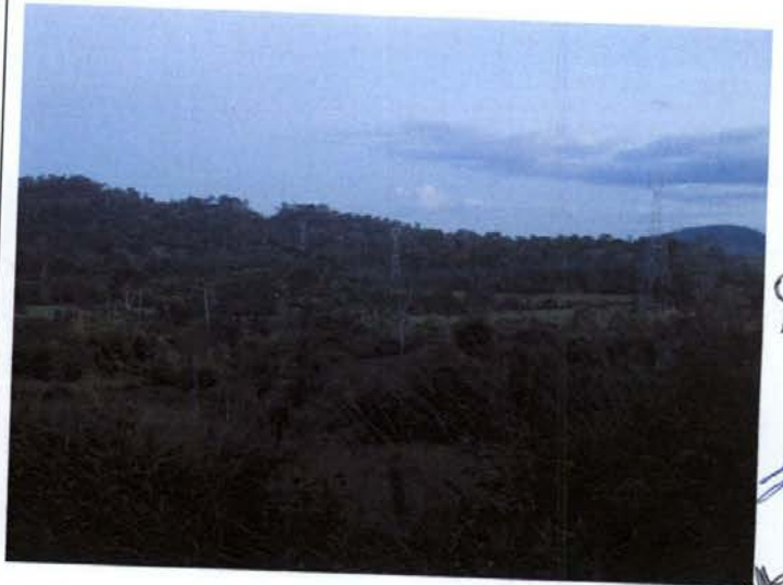
Foto 315: Inserção da LT 230 kV Cacoal – Ji-Paraná, já implantada, onde observa-se a presença de vegetação nativa e pastagens.
