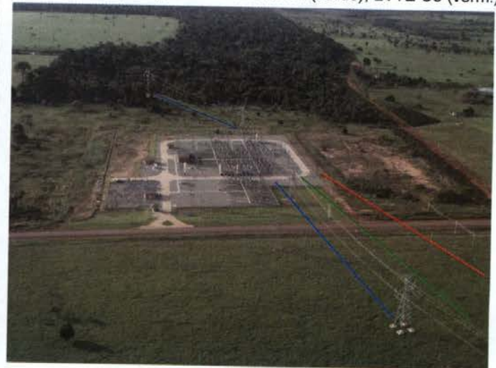
Foto 144: sobrevôo da diretriz preferencial proposta foi retomado na SE Pim. Bueno. Abaixo, saída das 3 LTs no sentido Vilhena: Eletronorte C1 (azul), Jauru Transm. C2 (verde), LVTE C3 (verm.)
