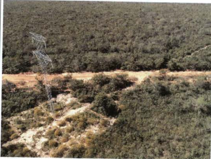
Foto 239: km 53, cruzamento da BR-364 (sem pavimentação) Supressão total da área da base da torre estaiada.
