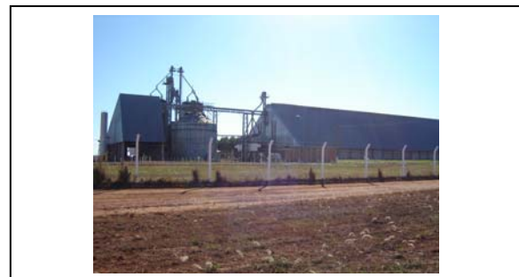
Foto 3.6.5-142 – Armazém da Cargill Agrícola, em Comodoro (MT). Fonte: Biodinâmica Rio, pesquisa de campo, 2010.
