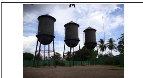
Foto 3.6.5.8-225 – Três Caixas d'Água, em Porto Velho (RO). Fonte: Biodinâmica Rio, pesquisa de campo, 2010.
