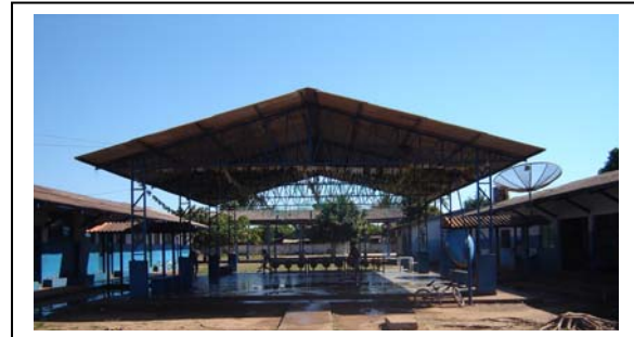
Foto 3.6.5-120 – Escola Estadual de Ensino Fundamental Bom Sucesso, em Pimenta Bueno (RO). Fonte: Biodinâmica Rio, pesquisa de campo, 2010.
