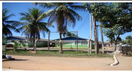
Foto 3.6.5-17 – Hospital Regional de Ariquemes (RO) Fonte: Biodinâmica Rio, pesquisa de campo, 2010.
