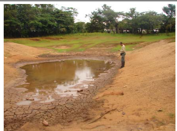
Foto 3.6.5-96: Possível Criadouro artificial localizado no Ponto V31.
