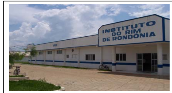
Foto 3.6.5-10 – Instituto do Rim de Rondônia, em Vilhena (RO). Fonte: Perfil Socioeconômico de Vilhena, 2006.
