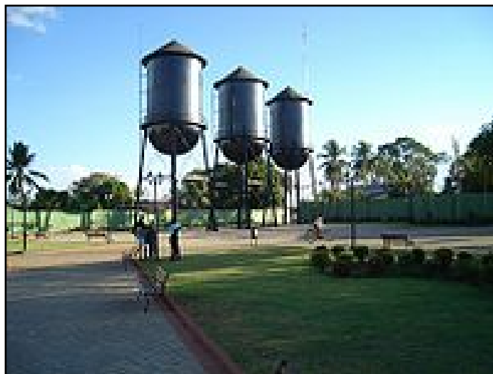
Figura 3.6.5-95 - As Três Caixas d'Água ou "Três Marias" Fonte: www.portovelho.ro.gov.br
