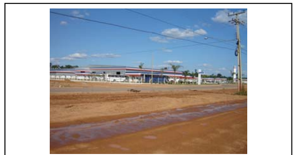
Foto 3.6.5-202 – Distrito Industrial, em Porto Velho (RO). Fonte: Biodinâmica Rio, pesquisa de campo, 2010.
