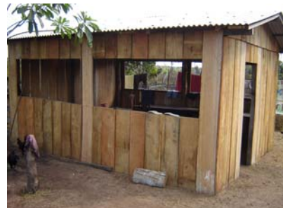
Foto 3.6.5-148 – Casa de madeira sendo construída na Chácara São João, no Setor Chacareiro, em Chupinguaia (RO). Fonte: Biodinâmica Rio, pesquisa de campo, 2010.
