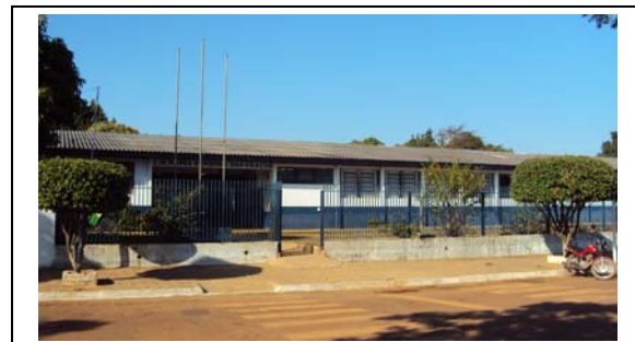
Foto 3.6.5-114 – Escola Municipal Nossa Senhora das Graças, em Comodoro (MT). Fonte: Biodinâmica Rio, pesquisa de campo, 2010.
