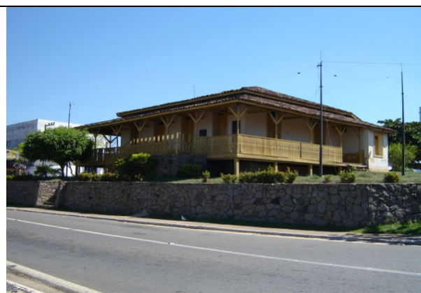
Foto 3.6.5-238 – Outro ângulo do Museu das Comunicações Marechal Rondon, antigo posto de Correios e Telégrafo, em Ji-Paraná (RO).
