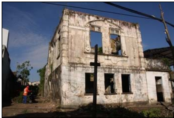
Figura 3.6.5-101 - Prédio da antiga Câmara Municipal Fonte: www.portovelho.ro.gov.br
