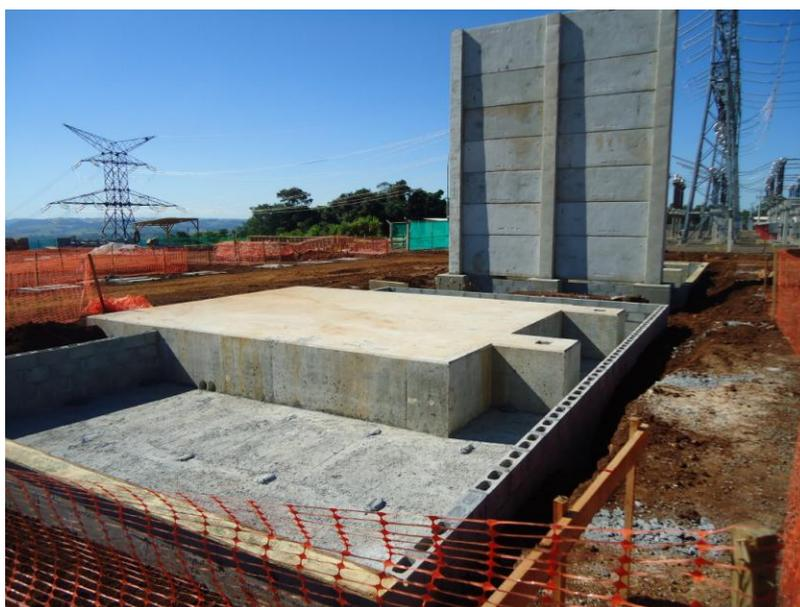
**Figura 15:** Vista de bacia de captação em local de implantação de transformador.
