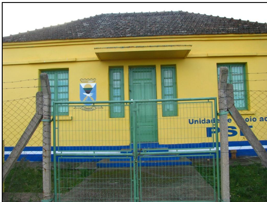
Figura 16: Infraestrutura de saúde na zona rural de Candiota, PSF no ponto de coordenada Long. 238.614 e Lat. 6.500.333
