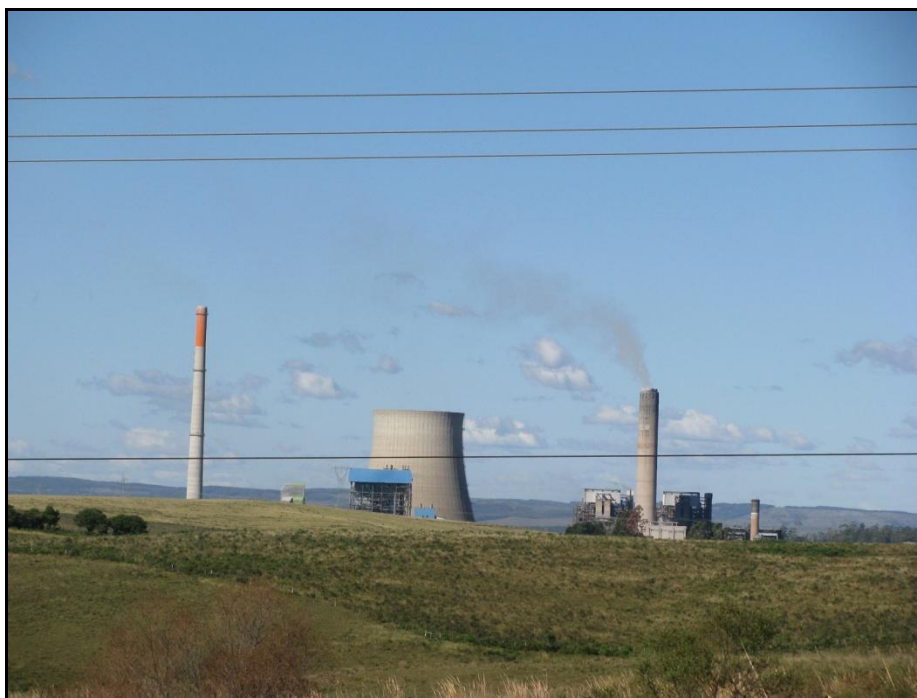
Figura 5: Vista panorâmica da Usina Termoeletrica Presidente Médici.
