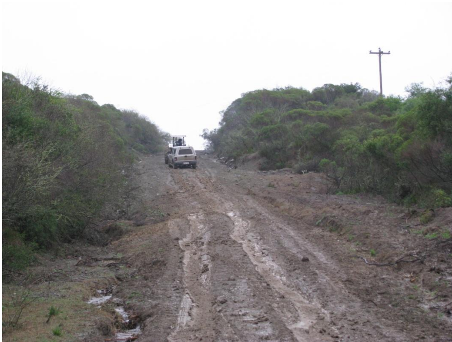
Figura 43: Vista de Vertissolo em estrada próxima a área de influencia direta. Destaque para as características plásticas destes solos.
