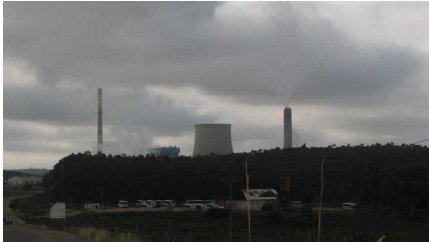
Figura 87: Usina Presidente Médici. Fonte: Geo Consultores Eng. e Meio Amb. Ltda., 2012.
