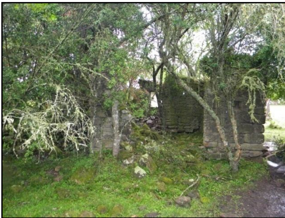
Foto 30: Lateral esquerda da segunda estrutura.
