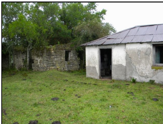
Foto 32: Ao lado das ruínas antiga habitação.
