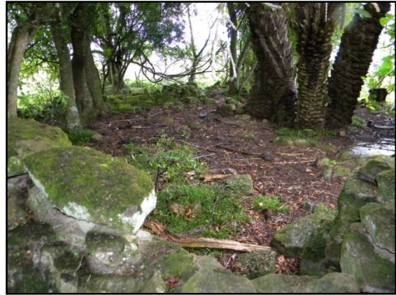
Foto 35: Continuação do muro e palmeira exótica 14 .
