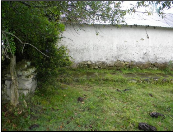
Foto 34: Pedras nas paredes da antiga habitação.
