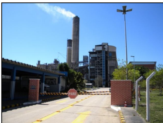
Foto 2: Usina Termelétrica Candiota
