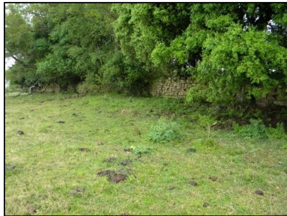
Foto 31: Muro de aproximadamente 150 m.
