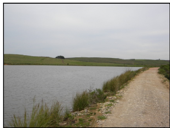
Foto 27: Barramento Santa Elmira.
