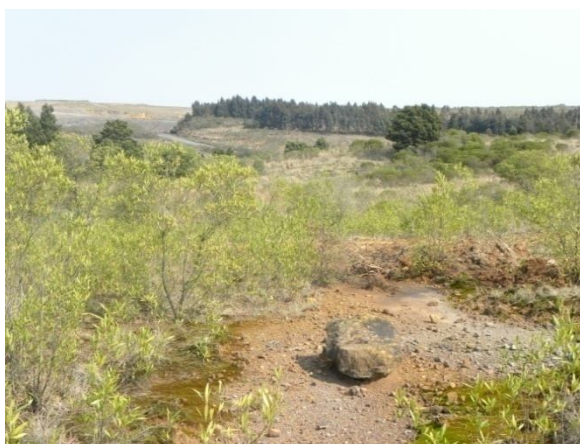
Figura 28. Vista geral de paisagens degradadas por atividade mineradora interceptada pela alternativa “ B3 ” no município de Candiota/RS.
