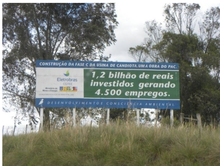
Figura 31. Placa referente à construção da Fase C da Usina Presidente Médici
