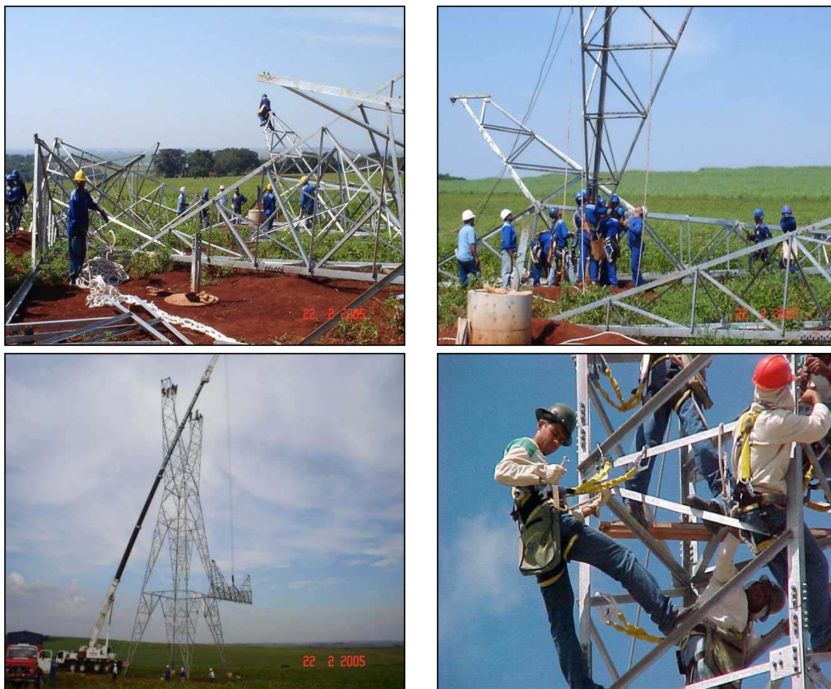
Figura 3.6.8.4.1-7 - Praça de montagens das torres
