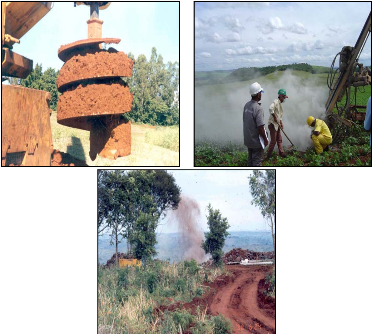
Figura 3.6.8.4.1-4 - Escavação para fundações das torres
