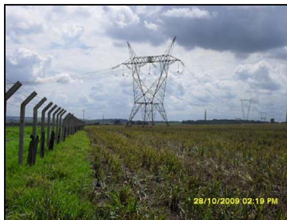
Figura 3.6.5.10-92 - Plantações próximo aos limites da Subestação de Rio Verde
