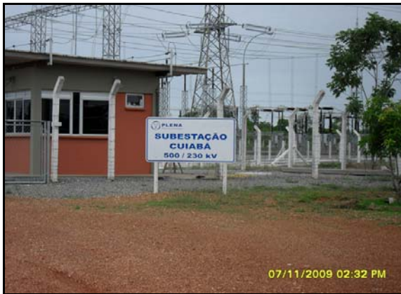
Figura 3.6.5.10-7 - Entrada da Subestação Cuiabá
