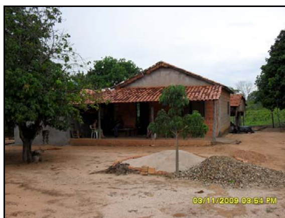
Figura 3.6.5.10-42 - Casa na Localidade Morro Dois Irmãos
