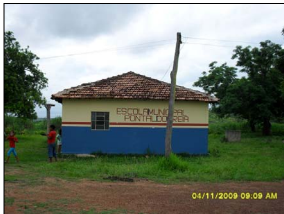
Figura 3.6.5.10-33 - Escola Municipal Pontal do Areia
