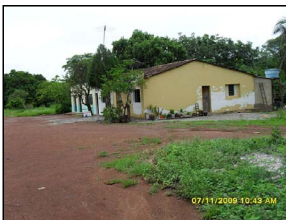
Figura 3.6.5.10-17 - Localidade Bamba - entrada para alojamentos.
