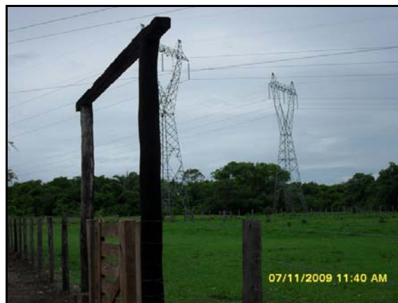
Figura 3.6.5.10-14 - Torres já instaladas na Fazenda Baía do Jacaré
