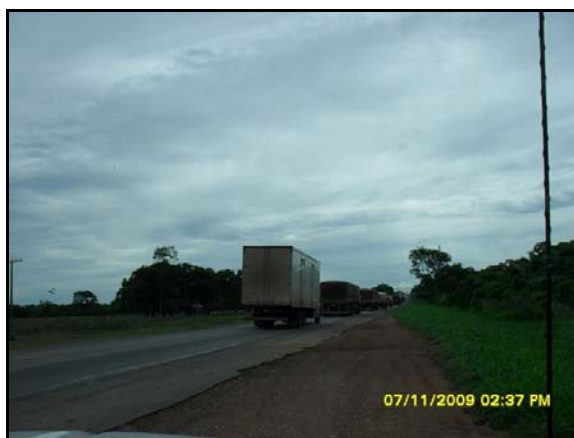
Figura 3.6.5.10-11 - Rodovia BR 364 - Trecho entre a Vila Olho d'Água e a subestação de Cuiabá.
