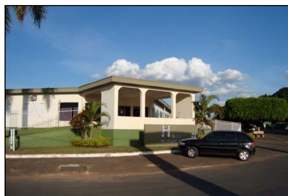
Figura 3.6.5.4-2 - Hospital Municipal - Município de Jaciara
