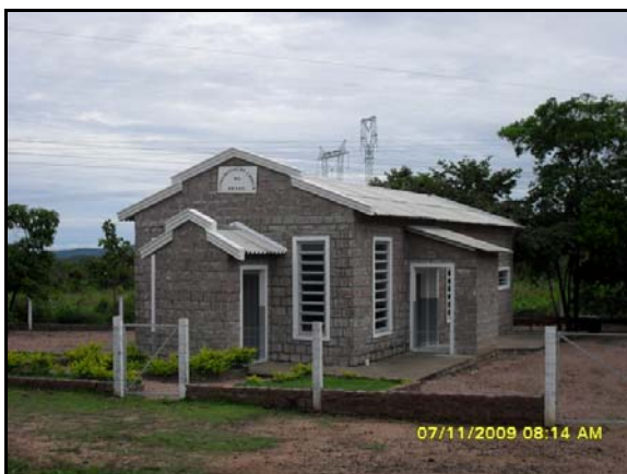
Figura 3.6.5.10-21 - Igreja de Pedra - Assentamento Fazenda Serrana - Município de Santo Antônio do Leverger
