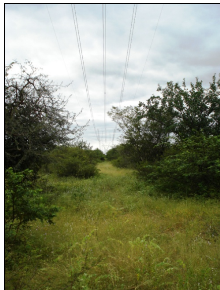
Figura 3.6.4.2-22 - Exemplos de manutenção da faixa de servidão sob LT's.
