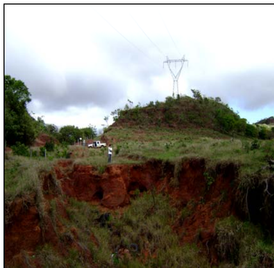
Figura 3.6.3.5-9 - Ravina próxima a base de uma torre de transmissão. Sinais de tentativa de contenção do processo com a inserção de pneus. P: 418299/8111791
