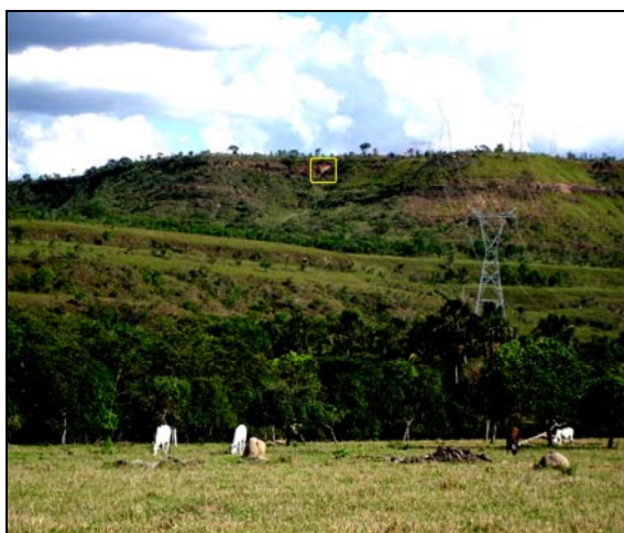
Figura 3.6.3.5-14 - Deslizamento de detritos localizado na concavidade da encosta, orientado pelo escoamento pluvial, correndo em arenito. Visto a partir do ponto, UTM: 428559/8103564
