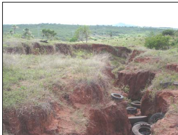
Figura 3.6.3.6-13 - Ravina de grandes proporções aberta em Latossolo Vermelho distrófico; a drenagem do escoamento corre em direção ao córrego Cava. UTM 419108/8110032.
