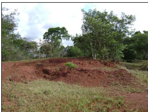
Figura 3.6.3.2-12 - Característica das coberturas detríticas que recobrem de maneira intermitente o traçado da linha de transmissão, por vezes laterizadas, município de Rio Verde, estado de Goiás.
