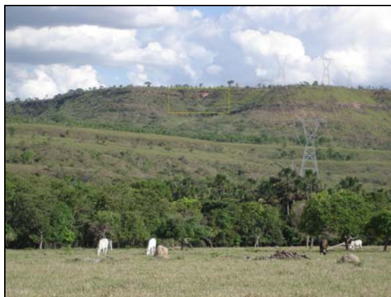
Figura 3.6.3.6-5 - Cicatriz de movimento de massa em destaque, localizada no hollow da concavidade em ponto próximo a fixação de uma torre da LT Cuiabá - Ribeirãozinho - Rio Verde Norte. Área de ocorrência de Cambissolo Háplico, com litologia composta por arenito da Formação Aquidauana. UTM 428559/8103564.
