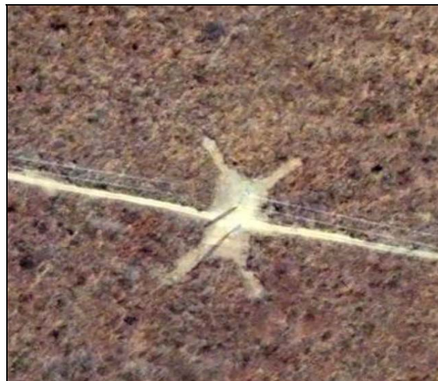
Figura 3.4-16 - Exemplo de torres estaiada instalada com mínima supressão de vegetação.
