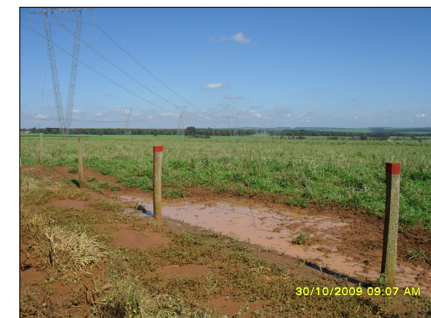
119- Marcação do traçado da futura LT próximo a Integração Perdigoão
