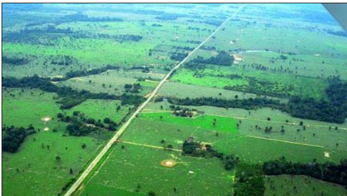
Figura 3.6.6-2 – Exemplo da ocupação na segunda Subunidade (sobrevoo, novembro de 2009)
