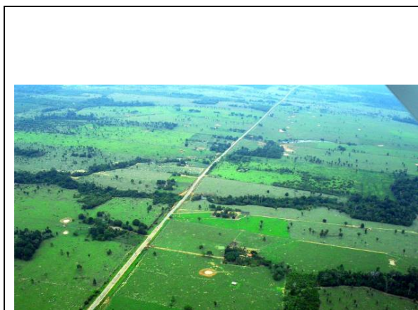
Foto 3.3-1 - Padrão de ocupação em linhas no Sul de Rondônia
